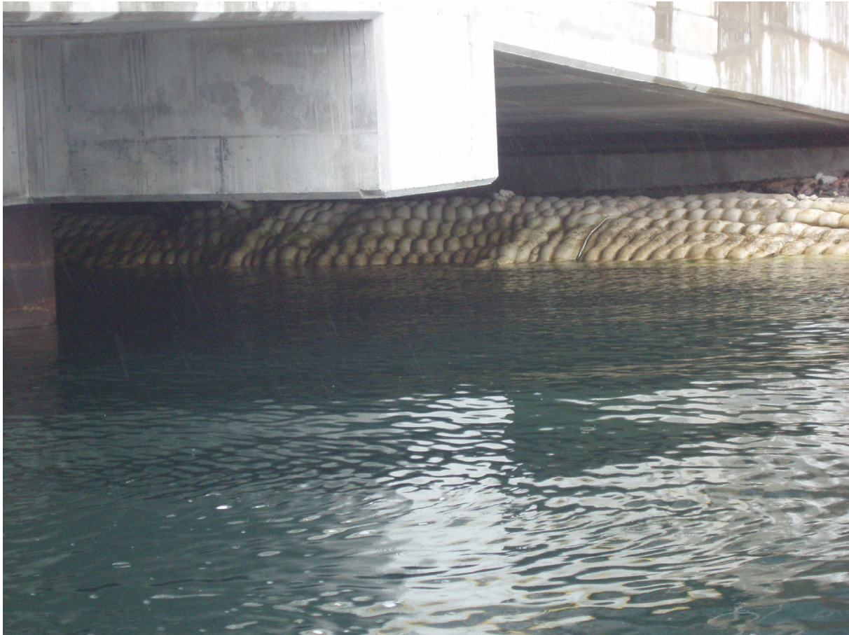
Figur 4. Betongmatte som dekker sjøbunnen fra overgangen land/sjø til kote -12m. Bildet er fra nordenden av kaianlegget. (Foto Jarle Håvardstun)
