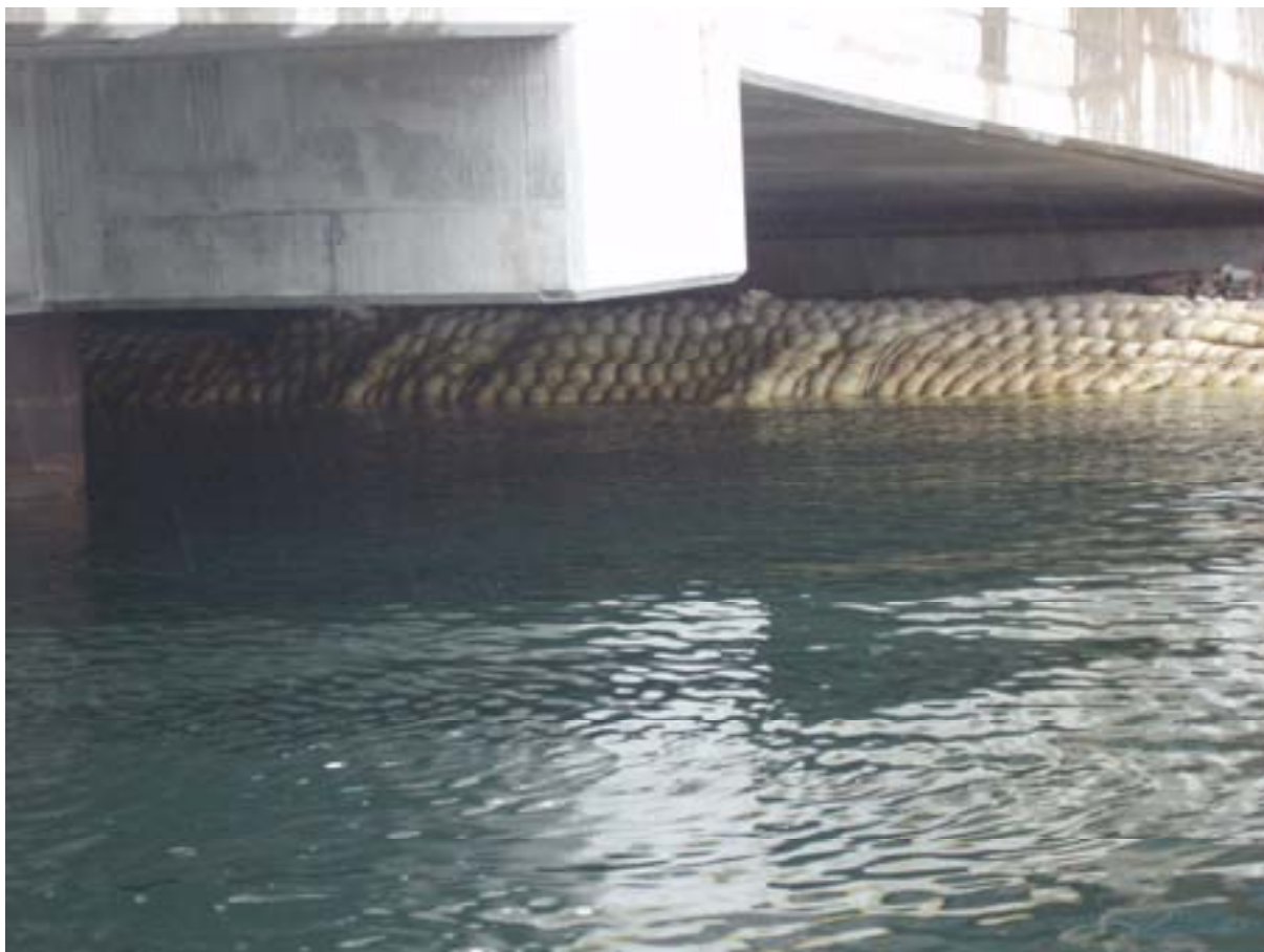
Figur 4. Betongmatte som dekker sjøbunnen fra overgangen land/sjø til kote -12m. Bildet er fra nordenden av kaianlegget. (Foto Jarle Håvardstun)
