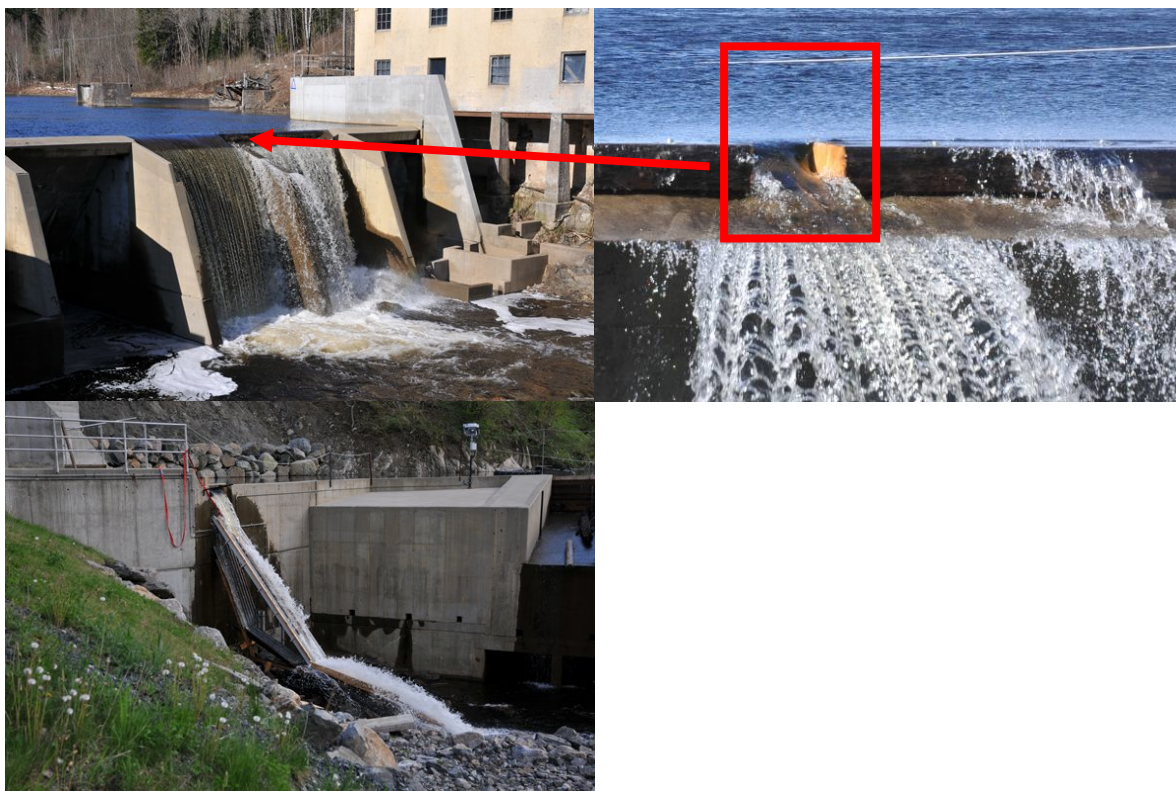
Figur 5. Venstre bilde viser vannløp over damkrona. Selve hovedstrømmen gikk i forsøksperioden gjennom en utsparing i damkrona vi fikk laget. Denne hadde en åpning på 43 cm bredde og 20 eller 30 cm vanddybde (høyre bilde). I nederste bilde er den provisoriske vannsklia (badeland) ned fra kraftinnløpet montert.
