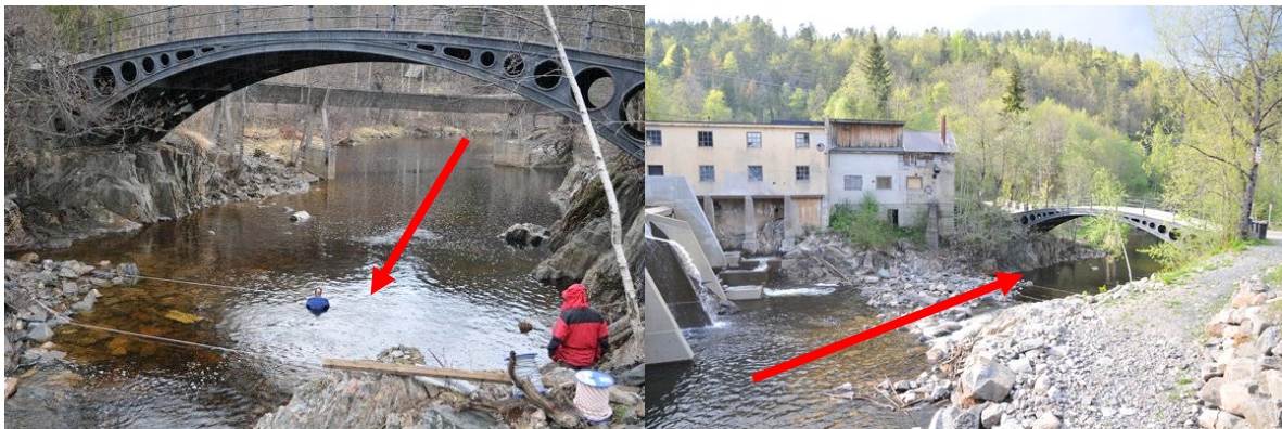
Figur 8. Bilder av PIT-BRU. Det er 10 til 30 m fra demningen til stasjonen, avhengig av hvor det måles.
