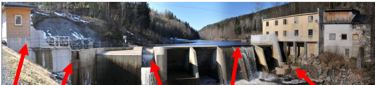
Figur 4. Bilde som angir de fire ulike nedvandningsrutene for smolt som ikke nedvandrer gjennom kraftverket. Fisk som bruker en av disse løpene vil havne i minstevannføringsløpet.
