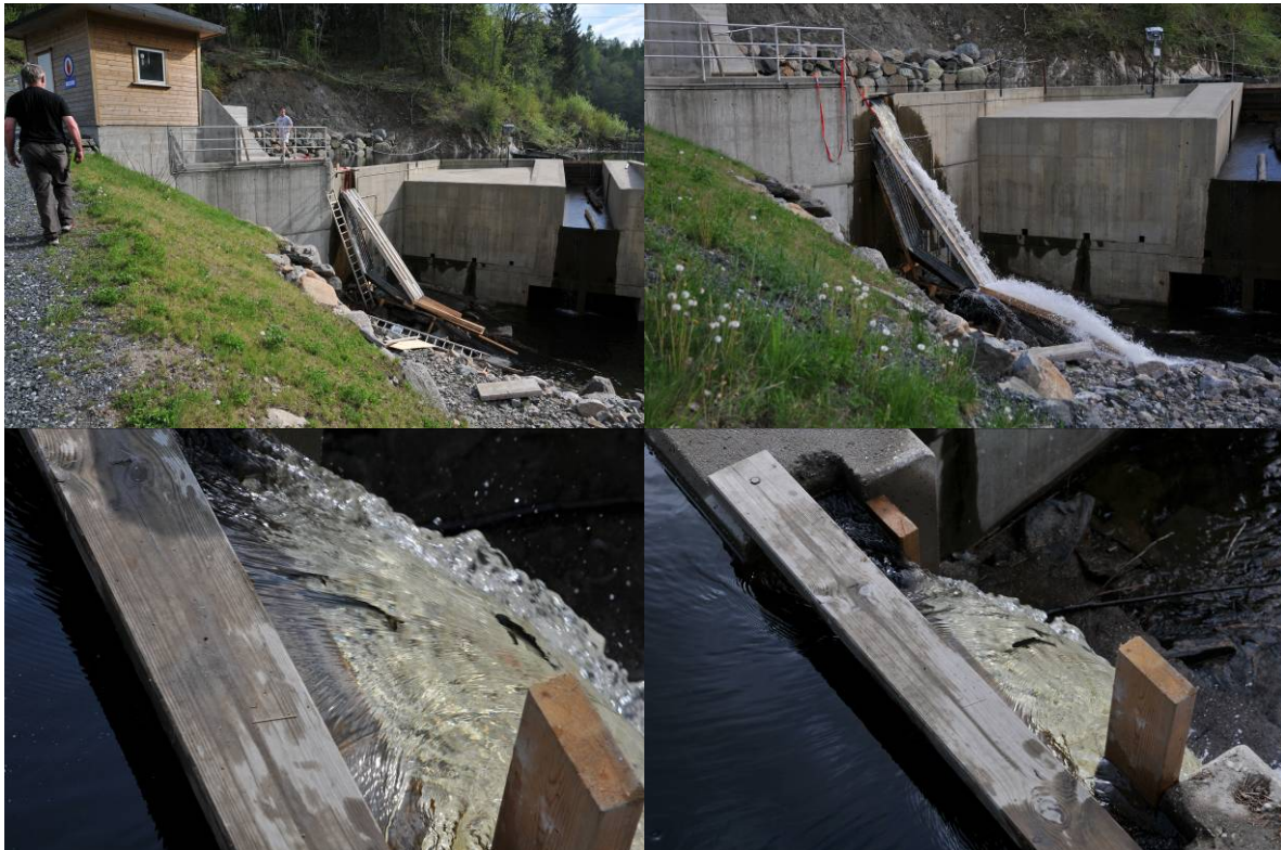
Figur 19. Øverst venstre: Renne som ledet smolten fra utløpsluke til minstevannføringsløpet. Øverst høyre: samme bilde, men nå med vann i renna. Nederst høyre og venstre. Smolt på vei ned renna sett fra inntaket til kraftverket.
