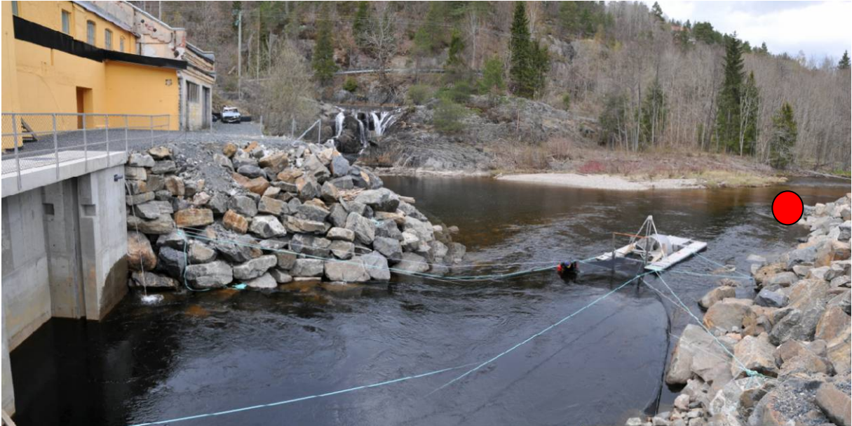
Figur 9. Bilde av smoltfelle på tunnelutløpet nedstrøms kraftverket. I bildet anes fossen som dannet det opprinnelige vandringshindret for laks i elva. Utsetningspunkt for PIT-merket kontrollsmolt er antydnet med rød sirkel.
