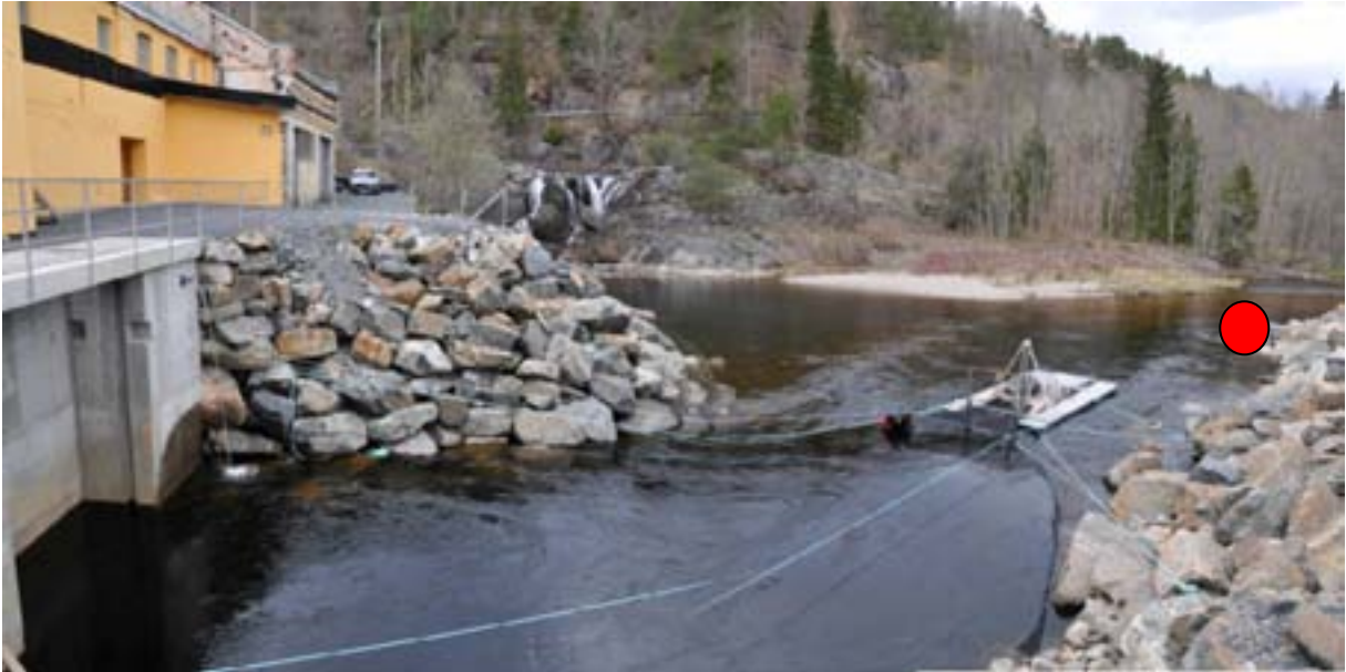
Figur 9. Bilde av smoltfelle på tunnelutløpet nedstrøms kraftverket. I bildet anes fossen som dannet det opprinnelige vandringshindret for laks i elva. Utsettingspunkt for PIT-merket kontrollsmolt er antydnet med rød sirkel.
