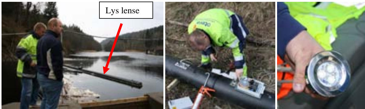
Figur 6. Plassering av LED-lyssperre benyttet ved Fosstveit kraftverk i 2010. Bildene til høyre viser selve LED-armaturen og innmontering i rør. Foto: Lars Tormodsgard.
