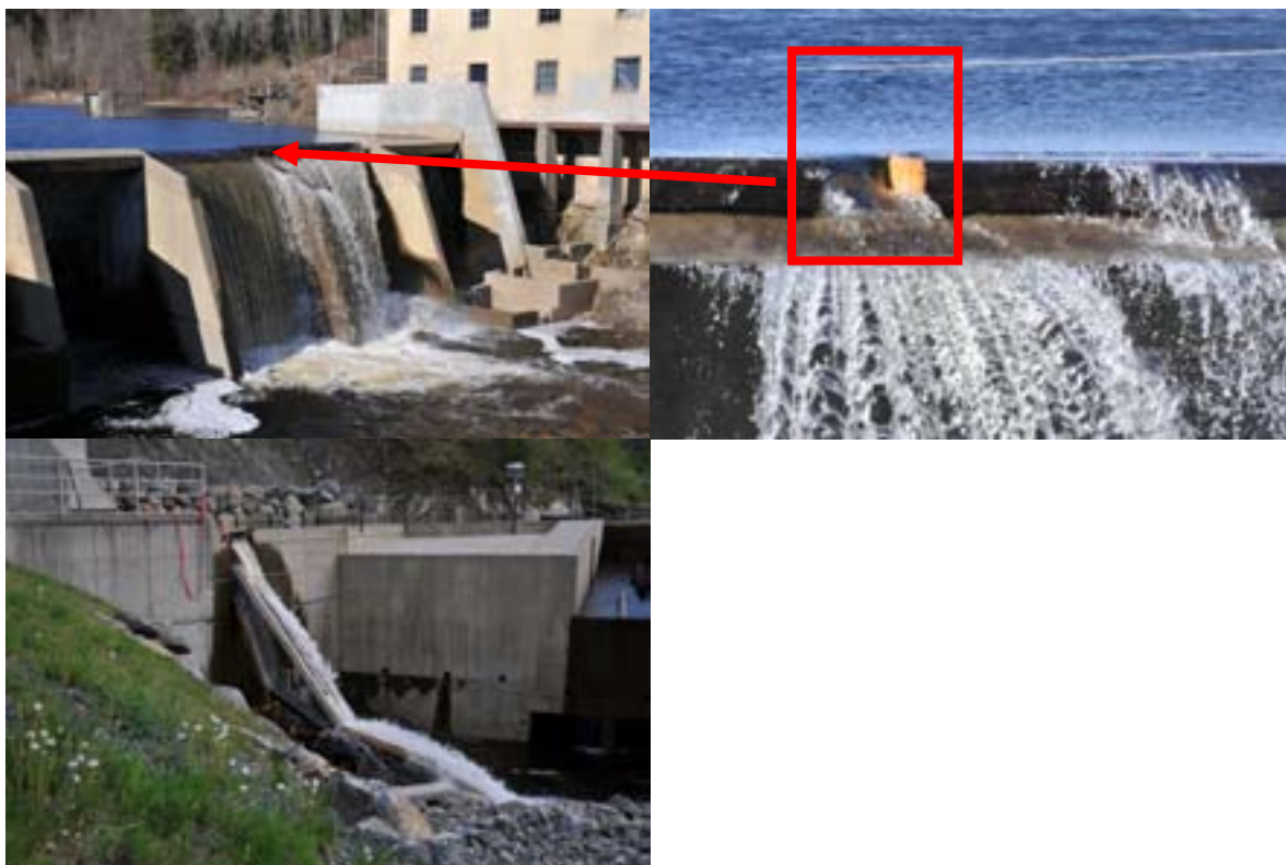
Figur 5. Venstre bilde viser vannløp over damkrona. Selve hovedstrømmen gikk i forsøksperioden gjennom en utsparring i damkrona vi fikk laget. Denne hadde en åpning på 43 cm bredde og 20 eller 30 cm vanddybde (høyre bilde). I nederste bilde er den provisoriske vannsklia (badeland) ned fra kraftinnløpet montert.
