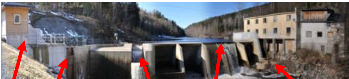
Figur 4. Bilde som angir de fire ulike nedvandningsrutene for smolt som ikke nedvandrer gjennom kraftverket. Fisk som bruker en av disse løpene vil havne i minstevannføringsløpet.
