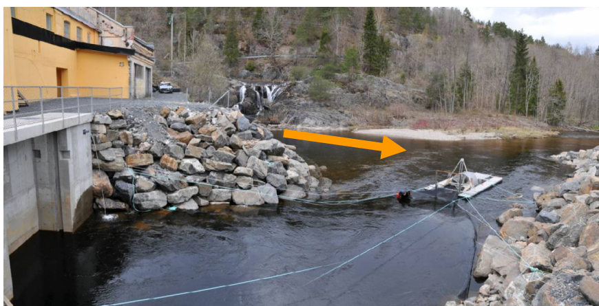
Figur 9. Foto av smolthjul med ledegarn nedstrøms turbinutløpet fra Fosstveit kraftverk. Vann fra minstevannføringsløpet er markert med oransje pil i bildet.
