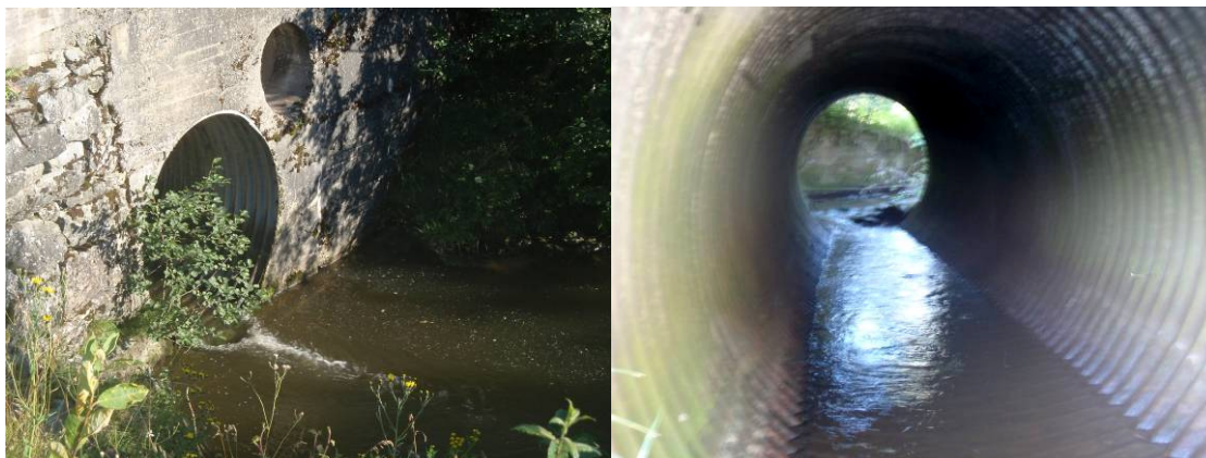
Foto: Kulverter i Amundbekken under FV855.
