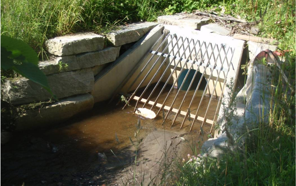
Foto: Kulvert under Lyngvegen (inkludert passasje under E6).
