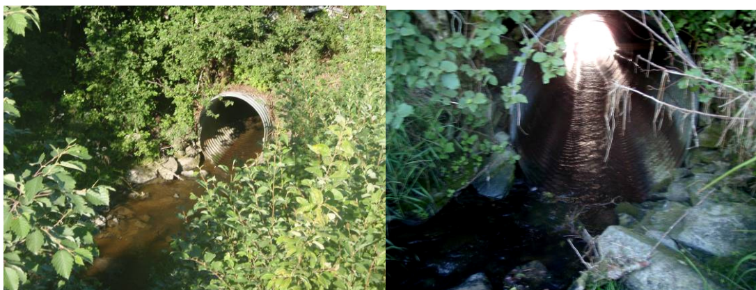
Foto: Kulvert der Solemsbekken munner i Amundbekken.
