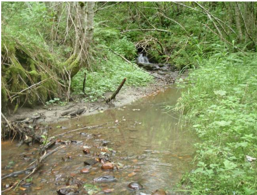
Foto: Mjølkhusbekken. Dagens åpne strekning opp mot øvre kulvert, der bekken går i bakken.
