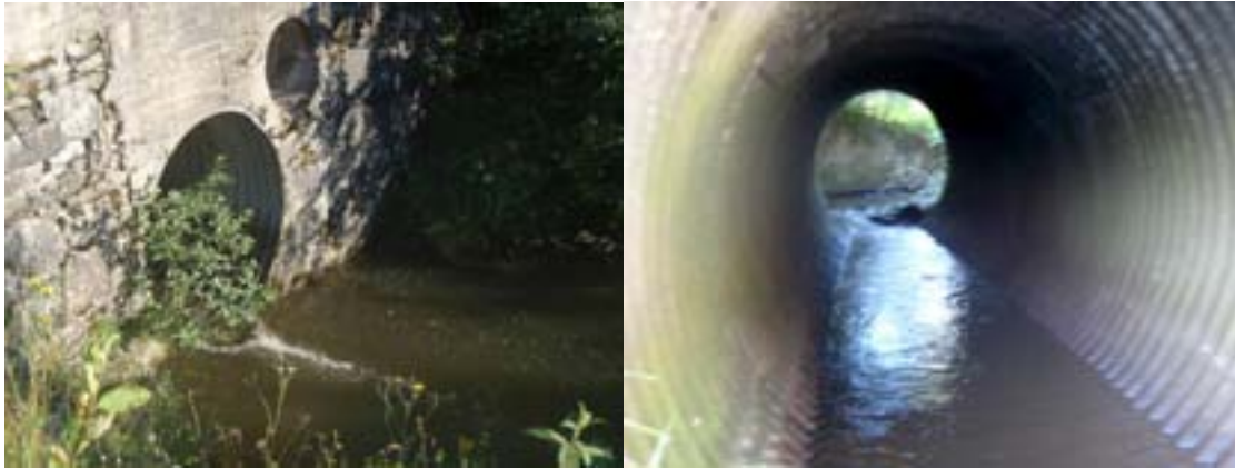
Foto: Kulverter i Amundbekken under FV855.
