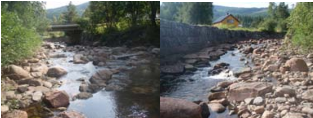
Foto: Sevilla ned mot krysning av jernbane og flomforbygd strekning.
