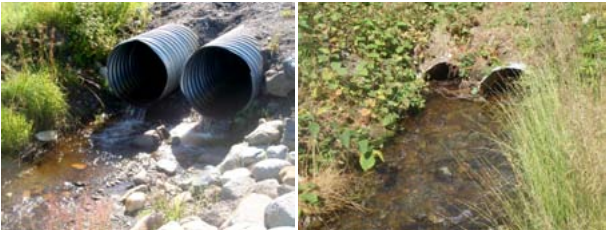
Foto: Ut- og innløp av kulvert under Ringvegen, som er vandringshindrende etter kriteriesett A.
