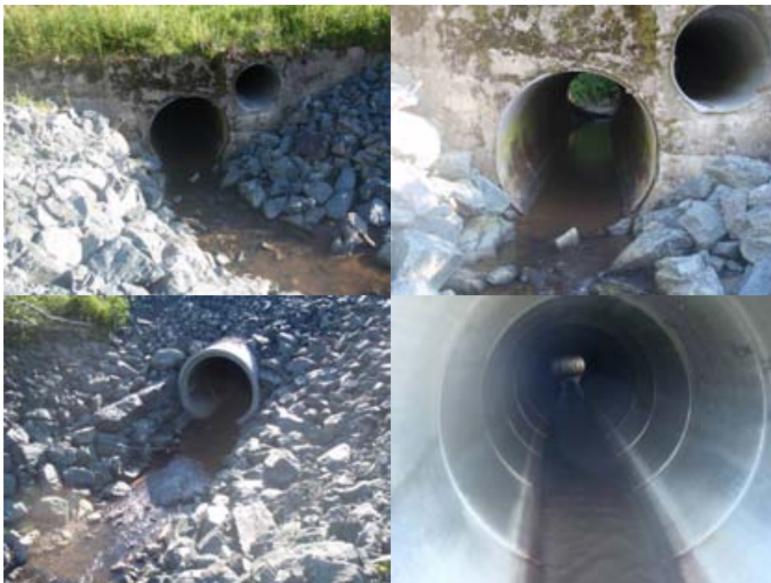
Foto: Gammel (øverste bilder) og nyanlagt kulvert (nederste bilder) i steinsatt strekning av Solemsbakkens nedre deler. Den nye kulverten (nederst) har ugunstige vandringsmuligheter for laksefisk ved lav vannføring, og det er noe usikkert om den er mindre problematisk i perioder med større vanngjennomstrømming. Kulverten er trolig vandringshindrende etter Kriteriesett A.
