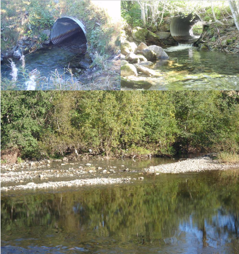
Foto: Tilfredsstillende kulverter i Horunda (over), men kulvert til høyre burde vært senket mer (eller vannstanden nedstrøms justert noe) for lettere vandringer av yngel-/ungfisk. Munningsområde til Orkla (under) vurderes som uproblematisk i normalår.
