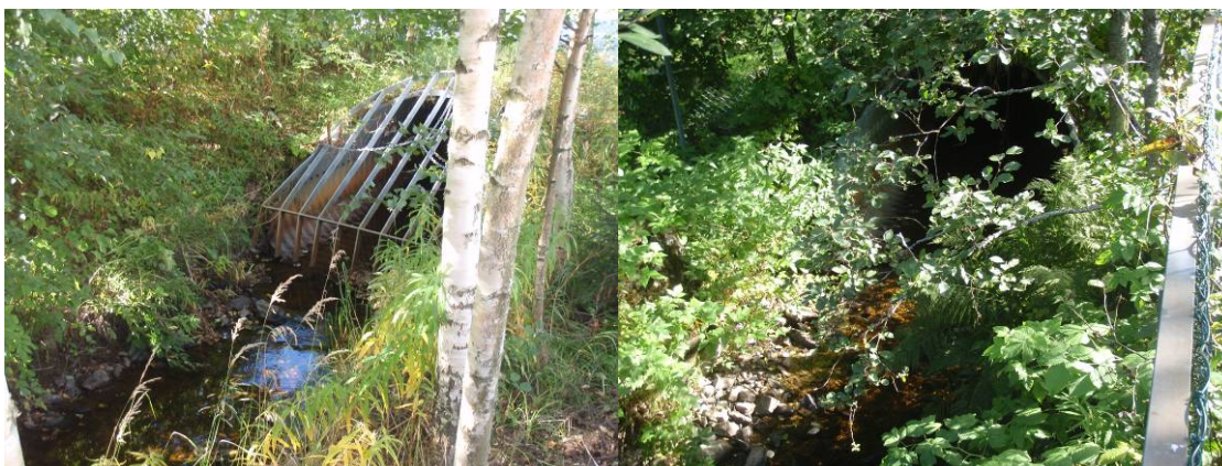
Foto: Inn- (t.v.) og utløp (t.h.) av kulvert på rørlagt strekning. Kulverten er trolig tilfredsstillende, med relativt bred og flat bunn som ikke hindrer passasje. Rista foran inngangen kan derimot være til hinder dersom den tettes. Denne bør ettersees jevnlig.
