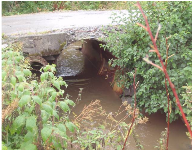
Foto: Uproblematisk vegkrysning i nedre avsnitt av Ystørja.
