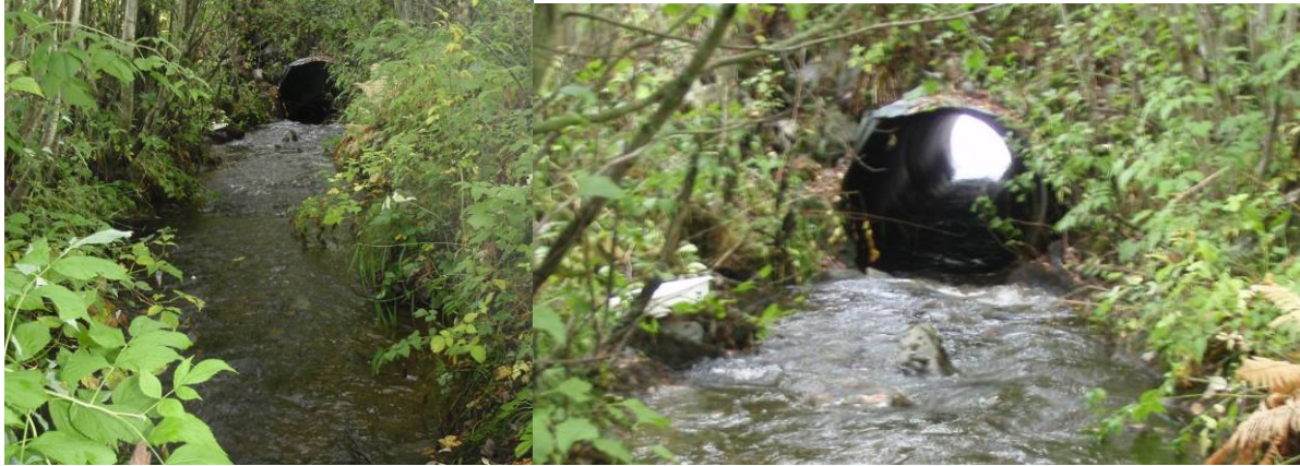
Foto: Inngangen til kulvert i nedre deler av Tonga før munning til Orkla.
