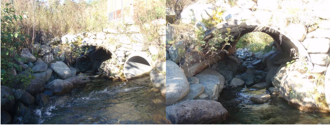
Foto. Horunda starter i dag fra utløpstunnelen til Horunda Kraftverk. Opprinnelig bekkeløp går tørt.
