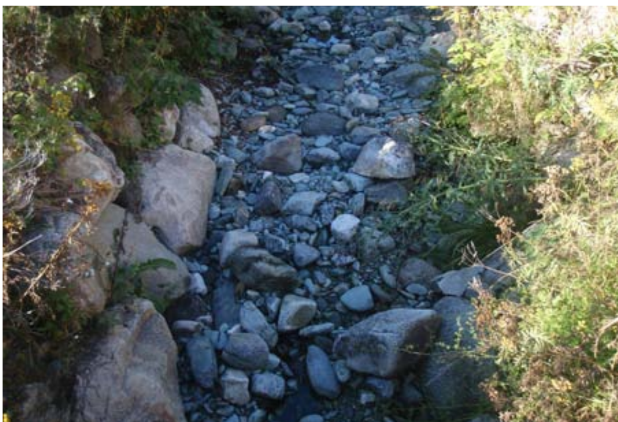
Foto. Sidegrein av Horunda oppstrøms kraftverket.
