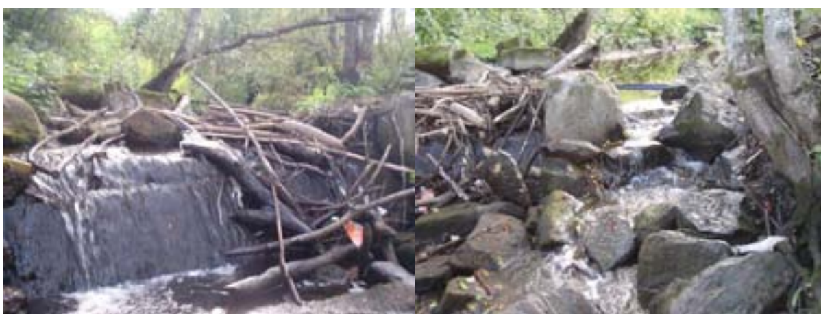
Foto: Terskel. Det ble gjort et forsøk på midlertidig utbedring av vandringsveier på stedet, ved å flytte stor stein og blokk, slik at oppvandring lettes. Terskelen må derimot fjernes eller utbedres betydelig for at miljømål skal nåes på sikt.
