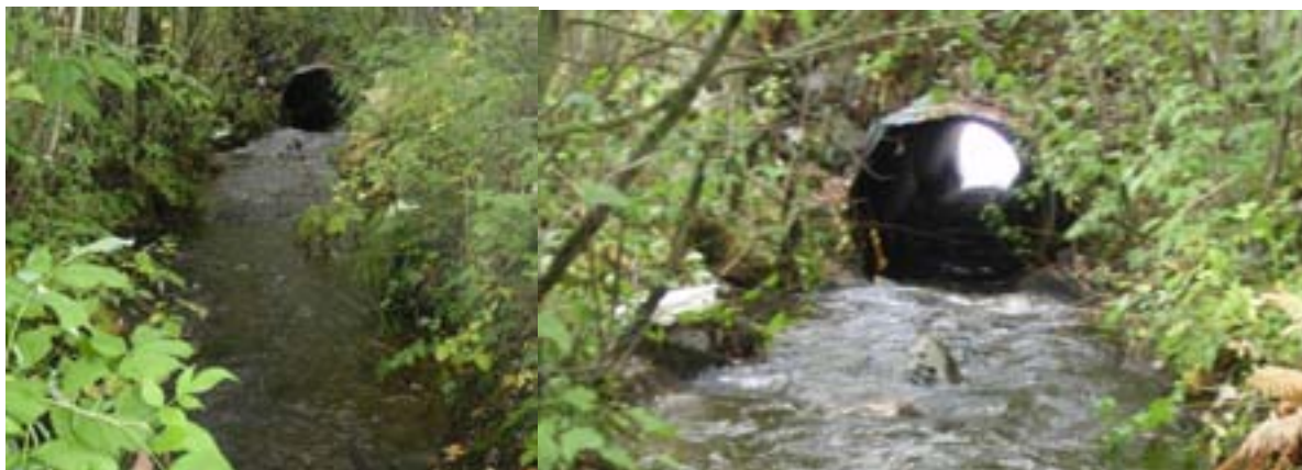
Foto: Inngangen til kulvert i nedre deler av Tonga før munning til Orkla.
