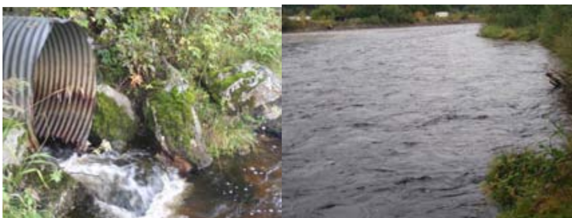
Foto: Sprang opp til kulvert selv når Orkla går med vannføring over middels på undersøkelsestidspunktet.
