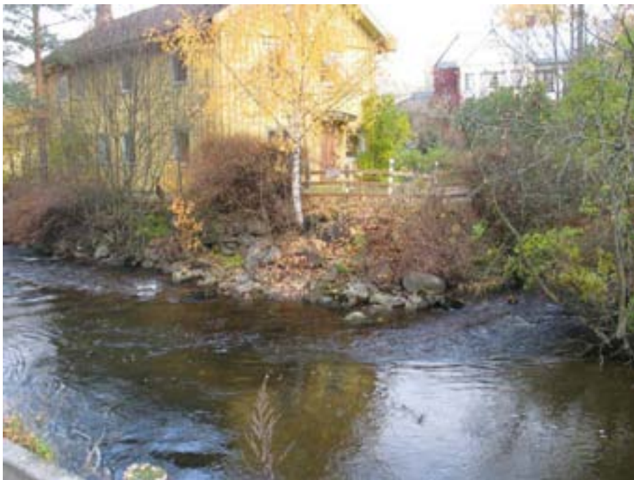
Stasjon El_5 ved utløp Eggeelva.
