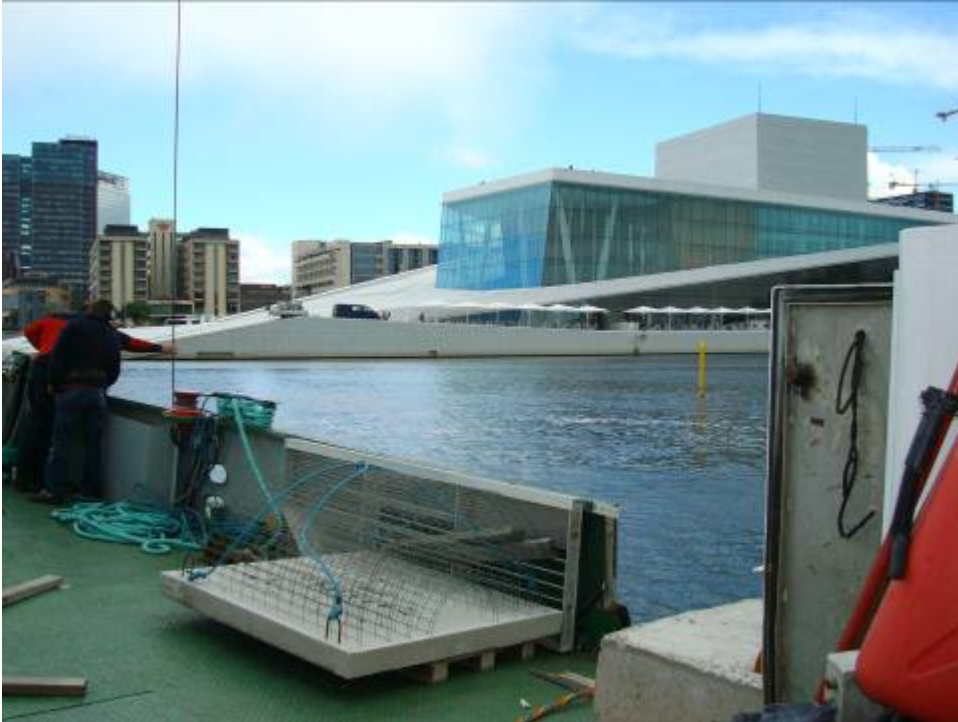
Bilde 3. Renserev på dekket av dykkebåten.
