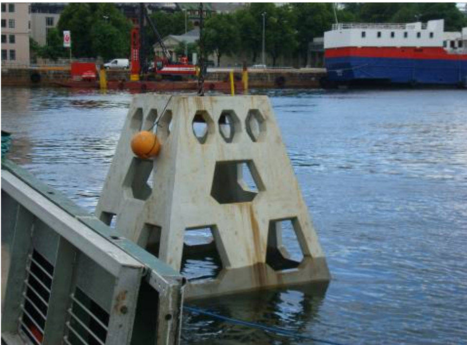
Bilde 2. Pyramideformet rev, fiskerev, på vei ut i sjøen.
