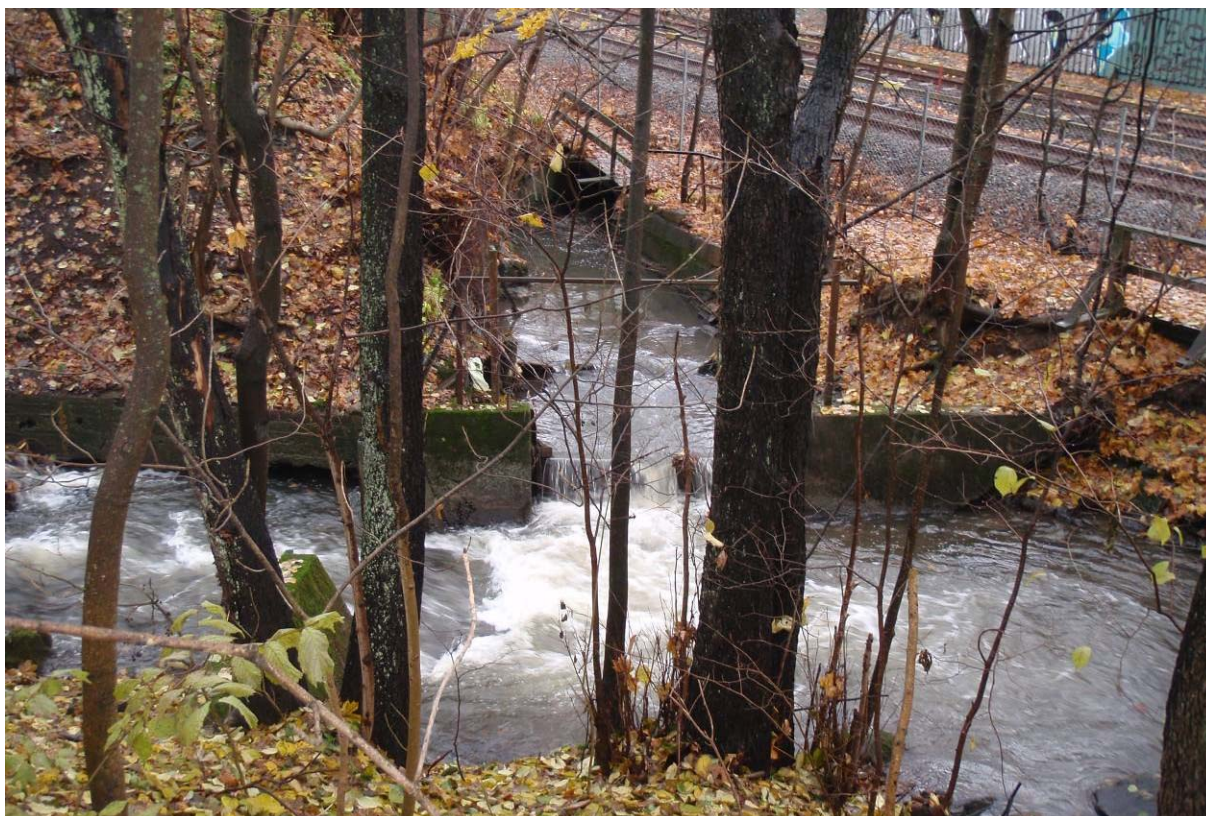
Foto. Gaustadbekken møter hovedelva, med kulvert under T-banen og en liten terskel før samløp.
