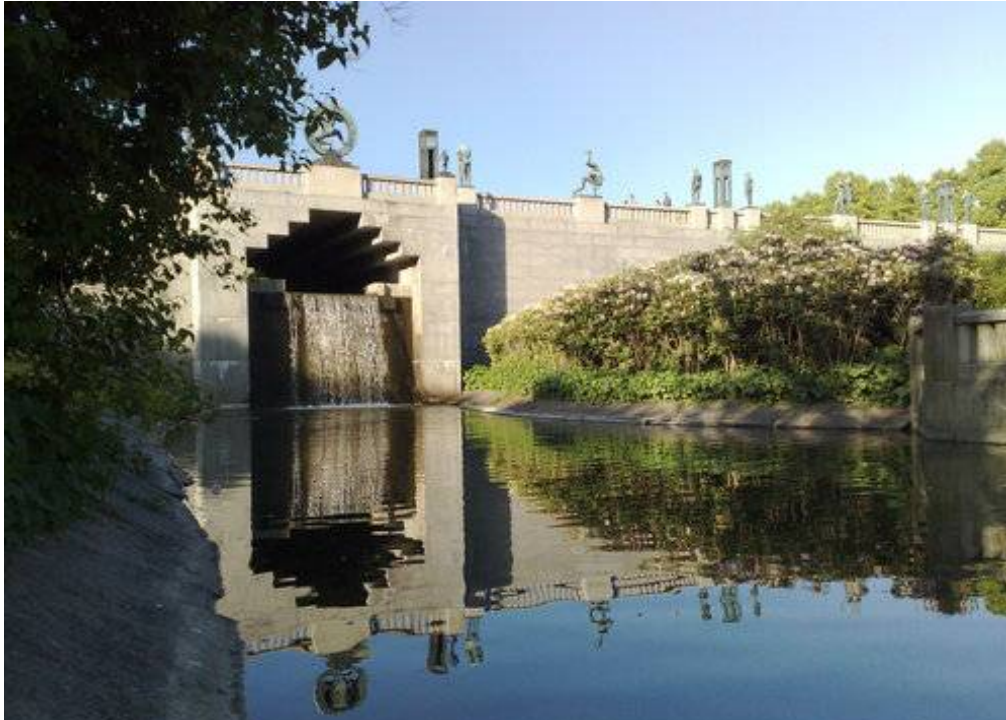
Foto: Det er åpenbare brudd på kontinuitet mellom øvre og nedre dam for vandrende fisk i Frognerdammene.
