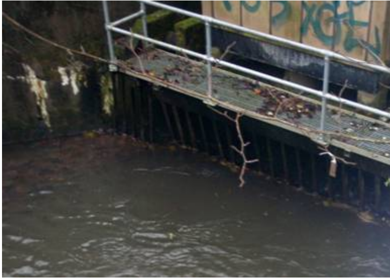
Foto. Inngangen til kulvert i nedre del av Frognerelva. Kulverten er stor, godt nedsenket og har uproblematisk helning og vannhastighet, men ristene i åpningen må holdes ved like i forhold til tilstopping og tetting.
