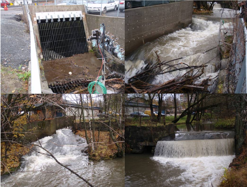
Foto: Kulvert mot munning til sjøen i Alna, med problempunkter umiddelbart oppstrøms denne (i form av terskel) dersom miljømålet for elveavsnittet blir å reetablere tilgang for sjøvandrende fisk.
