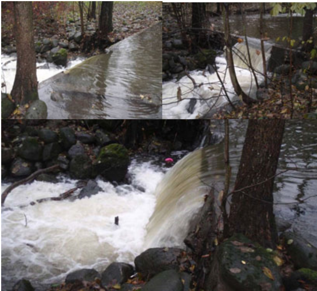
Foto. Ukurant terskel i Frognerelva, med høyt sprang og vanskelige oppgangsmuligheter for gytefisk.
