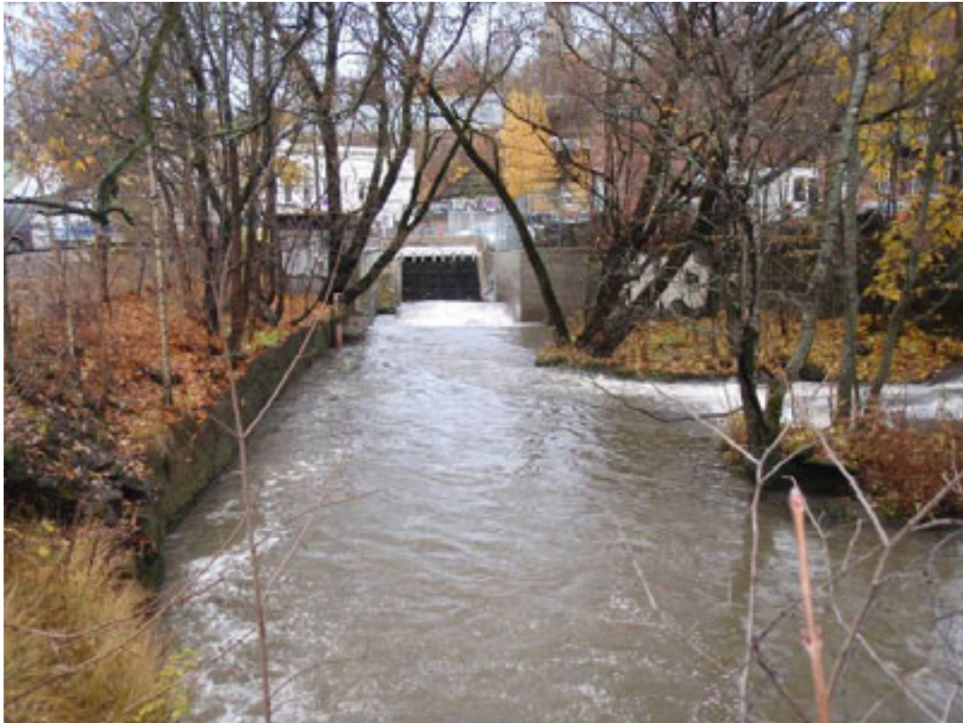
Foto: Kulvert mot munning til sjøen i Alna.
