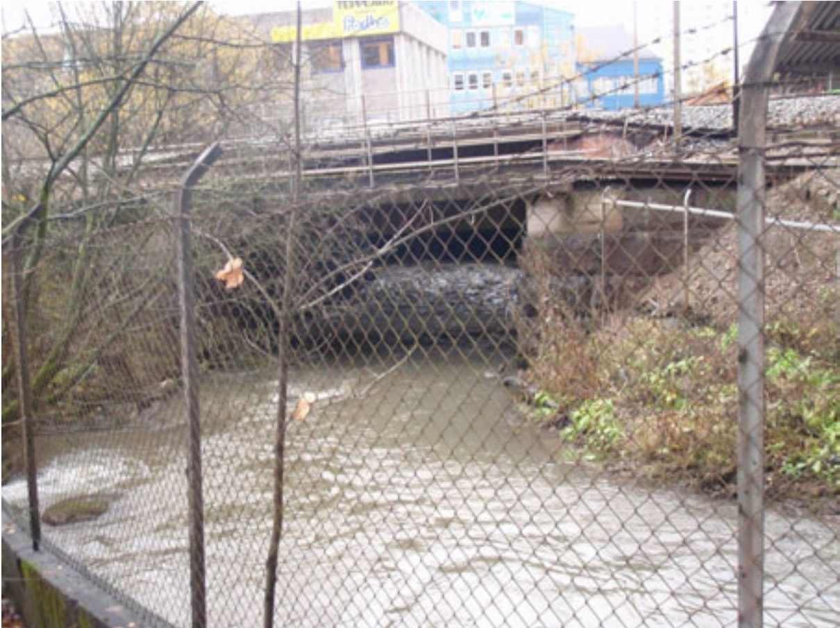
Foto: Stasjonsområdet ALN5, med kulvert under jernbane. Jernbanekrysningen er godt utført i forhold til kontinuitet for fisk, der elvebunnen er bevart i forbindelse med krysningen.
