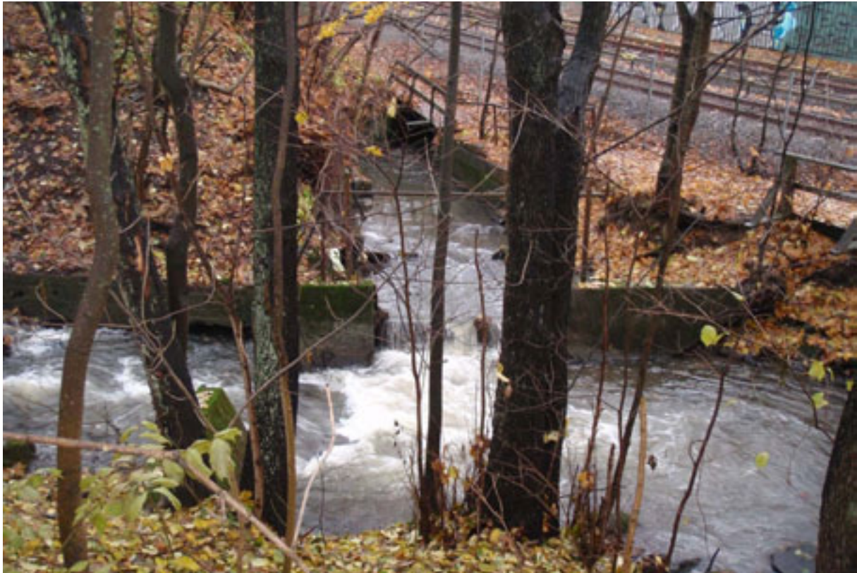
Foto. Gaustadbekken møter hovedelva, med kulvert under T-banen og en liten terskel før samløp.
