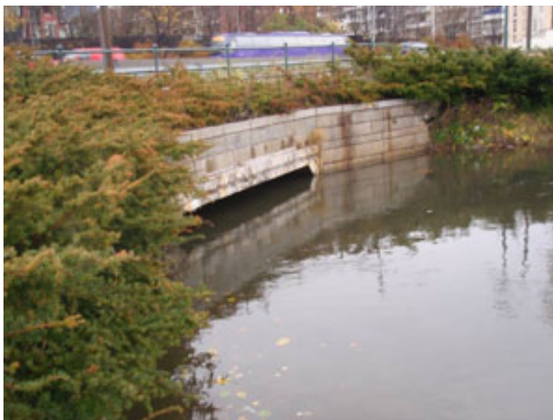
Foto: Frognerelvas utløp til sjøen. Godt nedsenket kulvert med tilfredstillende dimensjon.
