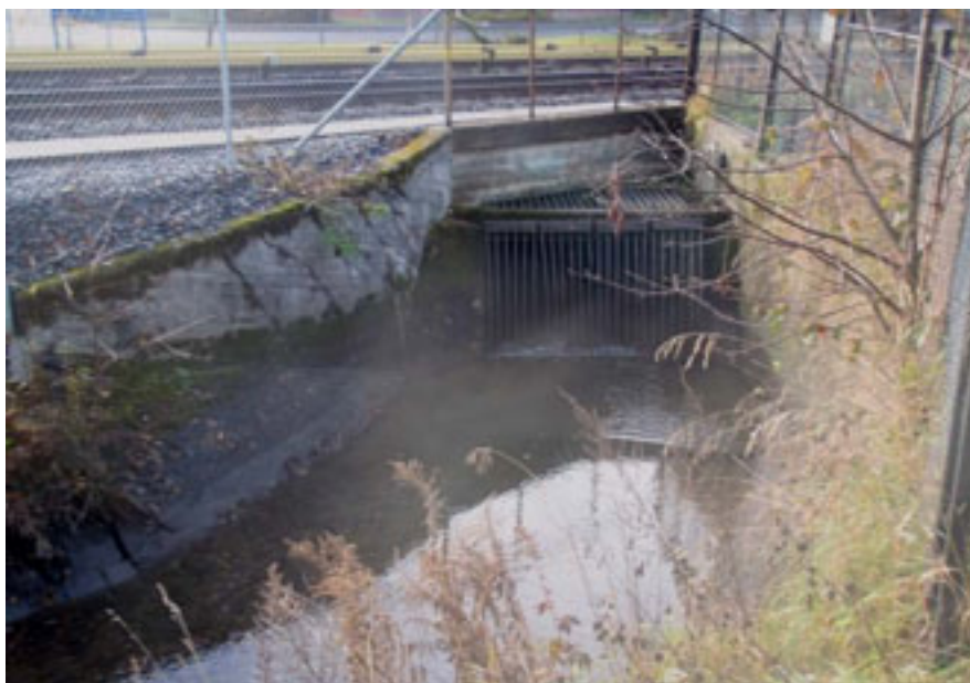
Foto: Kulvert nedstrøms HOV2, der Hovinbekken går i bakken en lengre strekning.
