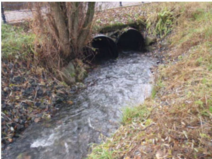
Foto: Kulvert som ikke er til hinder for fiskevandring i stasjonsområdet HOV2.
