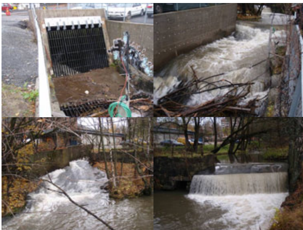
Foto: Kulvert mot munning til sjøen i Alna, med problempunkter umiddelbart oppstrøms denne (i form av terskel) dersom miljømålet for elveavsnittet blir å reetablere tilgang for sjøvandrende fisk.
