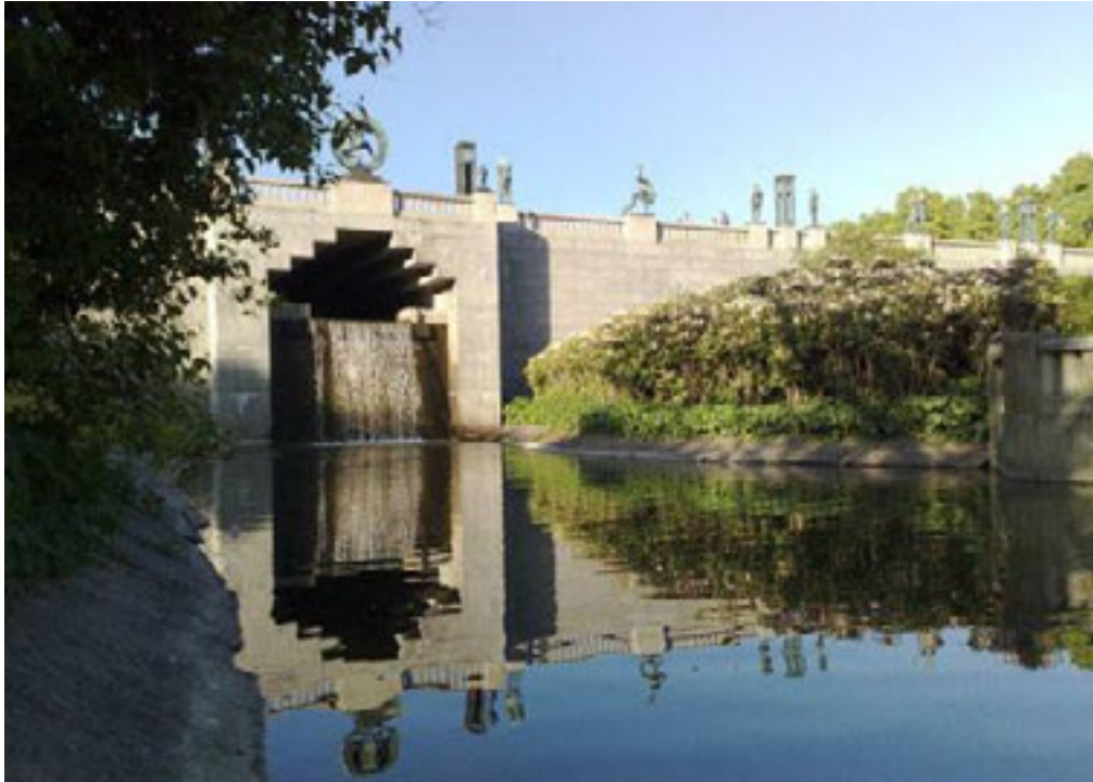
Foto: Det er åpenbare brudd på kontinuitet mellom øvre og nedre dam for vandrende fisk i Frognerdammene.
