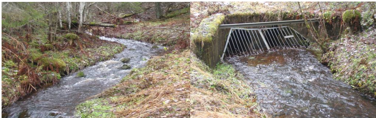
Foto: Sørå ved Katteskogen, der bekken går i rør nedstrøms bunndyrstasjonen.
