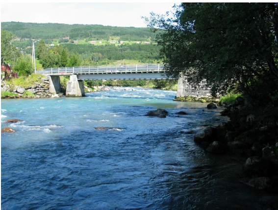
Seimsbrua sett nedenfra.
