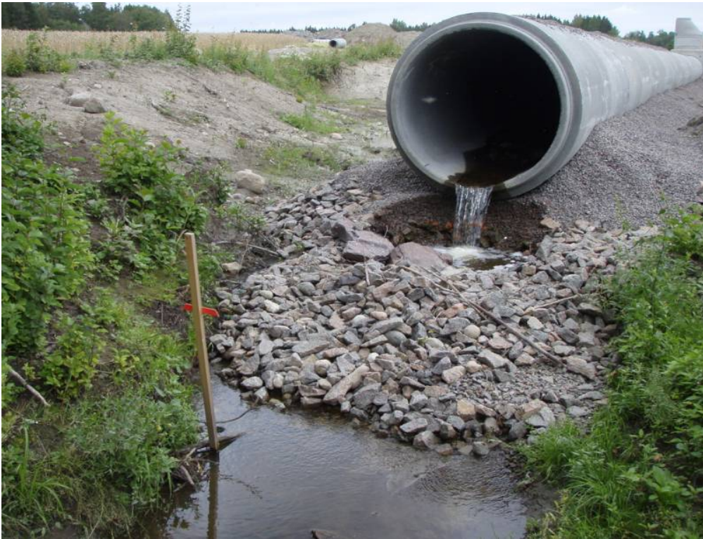
Figur 10. Nyanlagt kulvert over sjørrretførende bekker i Tønsberg, i forbindelse med anlegging av ny trase for Sørlandsbanen i 2009. Vil sjørrreten passere her på høyere vannføring eller flom?
