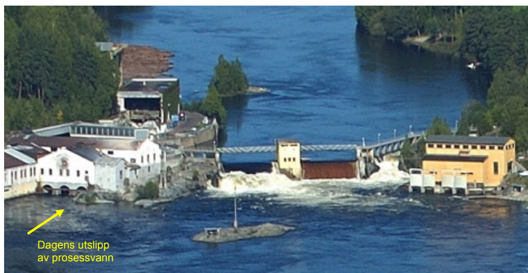
Figur 1. Foto av Hellefoss i Drammensvassdraget. Bedriften Hellefos AS ligger like ved kraftstasjonen på vestsiden av fossen. Dagens utslippspunkt er markert på figuren (Foto Hellefoss kraft as).
