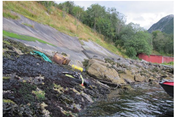
Figur 38. Stasjon B2- Gomen, fotografert nord mot naustene innenfor.
