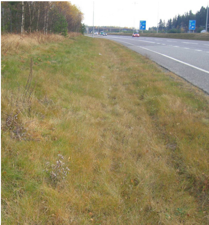
Figur 21. Graskledd veigrøft med infiltrasjon av overvannet (rv 35 Gardermoen).
