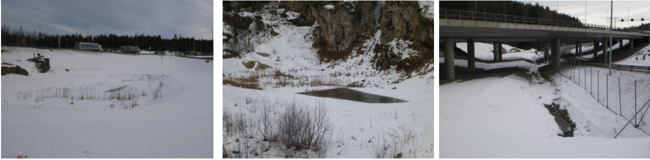
Figur 15. To rensedammer for veivann i nedbørfeltet til Tussetjern (til venstre v/krysset Assurdiagonalen, midtre bilde v/Follotunnelens nordre ende). Høyre bilde: All avrenning fra E6 går til Assurbekken som krysser under E6 ved nordenden av Follotunnelen. Bekken har sitt utspring fra Assuren.
