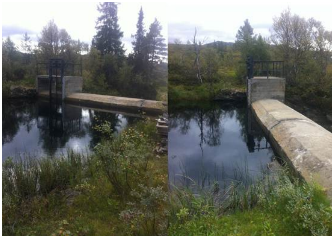
Figur 22. Demningen ved Burusjøen. (Foto: Morten Andre Bergan)
