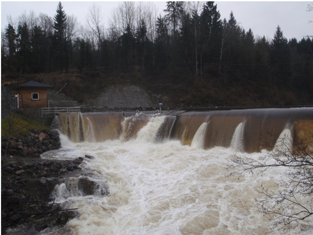
Figur 6. Vanskelige arbeidsforhold når elva går i flom.
