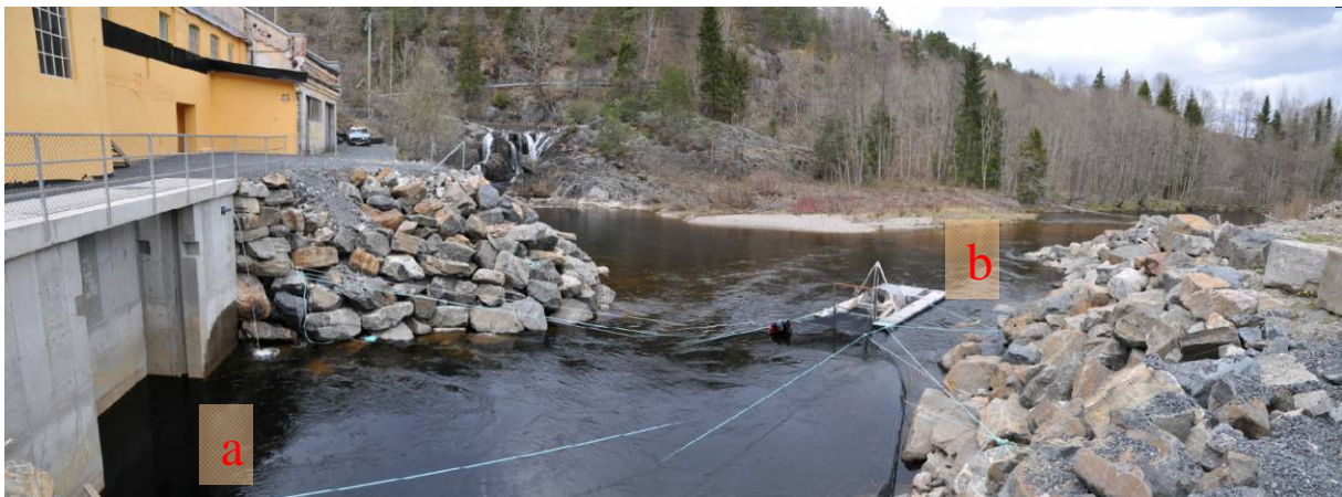
Figur 2. Illustrasjon som viser kraftverksdemning, minstevannføringsløp og utløp av kraftverksvann. Ål kan passere kraftverket via (fra venstre i figuren) laksetrapp, smoltoverløp, rensekanal, alternativt bunnluke og gjennom kraftverksturbinen. Fra minstevannføringsløpet vil ål kunne nedvandre via laksetrapp etablert i 1975 og over fossen Fosstveit. Oppvandringsruter er ikke vurdert, men her synes laksetrappa mest sannsynlig. Før 1975 (ny laksetrapp) må ålen ha passert fossen ved Fosstveit.
