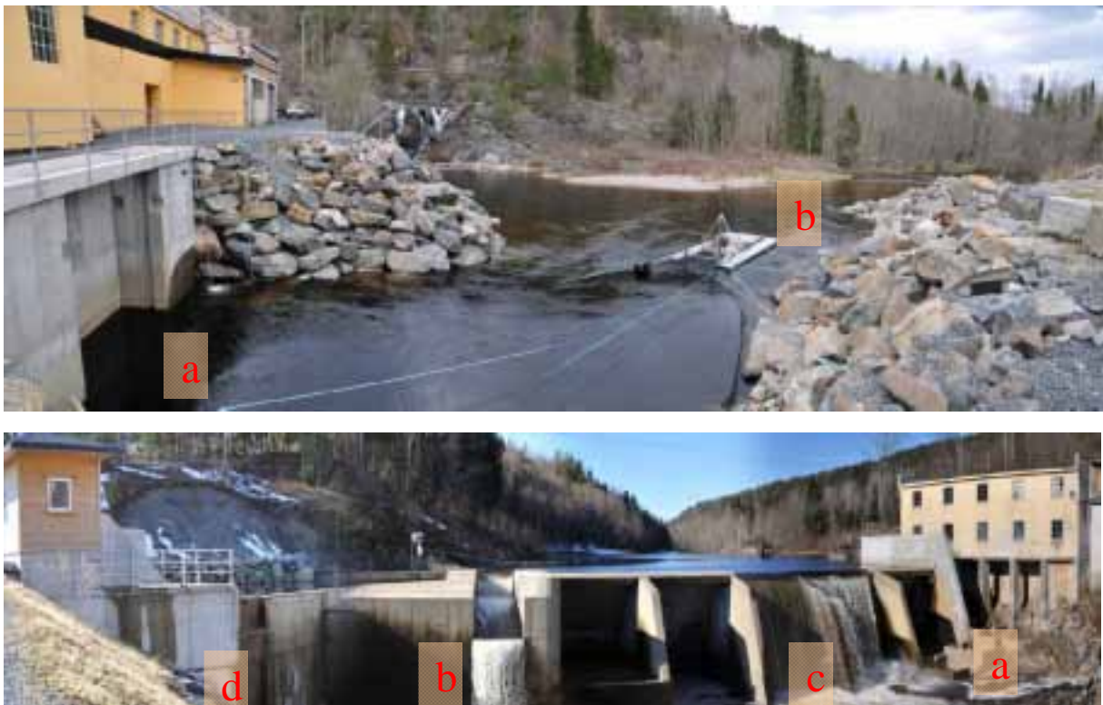
Figur 3. Øverst: utløpet fra kraftverket. Mye død ål ble funnet langs hele elveområdet fra turbinutløpet (a) til der elva forsvinner til høyre i bildet (b).
