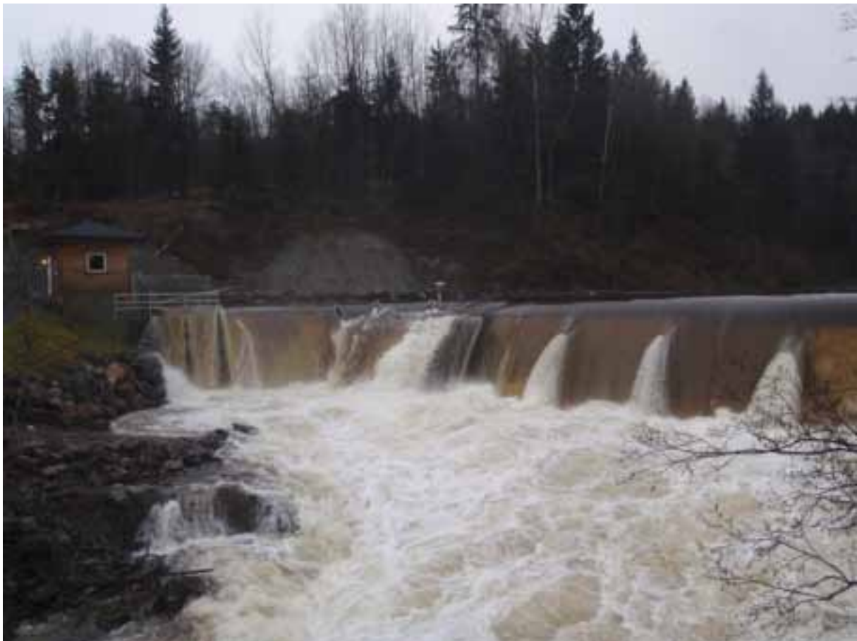
Figur 6. Vanskelige arbeidsforhold når elva går i flom.
