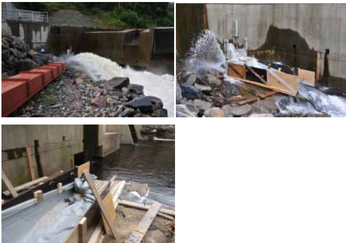
Figur 4. Venstre figur. Vannsprut ut av renseluke før denne ble dempet med bruk av en OB Wik-presenning. Høyre figur. Vann ut fra spyleluke er samlet inn i en OB-Wig-presenning og ledet til en åleruse montert på utløpet av presenningen. Nederste figur viser renna uten vann. Foto: F.Kroglund/J.Guttrup.
