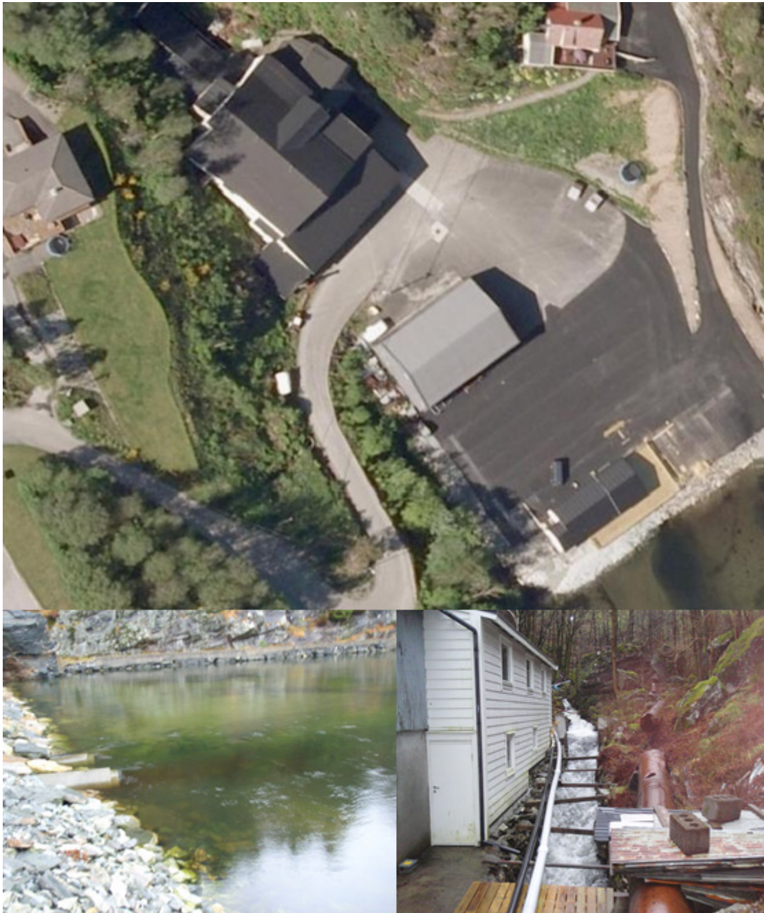
Figur 56. Fabrikkområdet hvor bekken går under (øverst), utløpskulverten (nederst t.v.) og strekning oppstrøms lukkingen (nederst t.h.)
