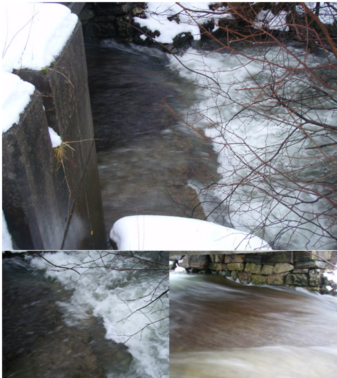
Figur 58. Kulvert under Vikanesveien.
