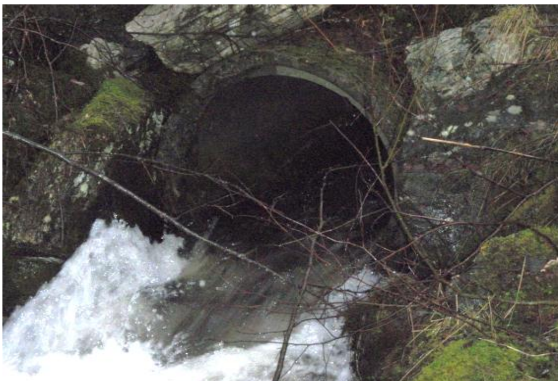
Figur 55. Kulvert under E 39.
