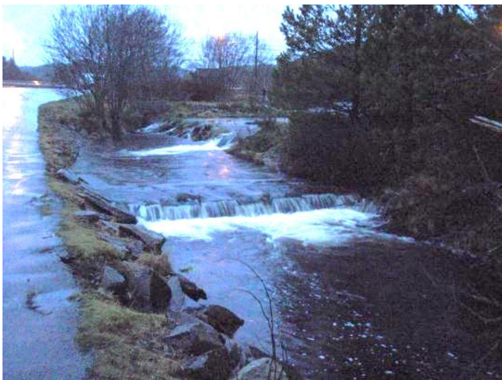
Figur 47. Utløpsbekkene nedstrøms Fv 211 framstår som ledet over fast fjell, som medfører passeringsproblemer for gytefisk på mange vannføringer. Tersklene videre nedover mangler dessuten lavvannsrenne, og er periodevis vandringshindrende.
