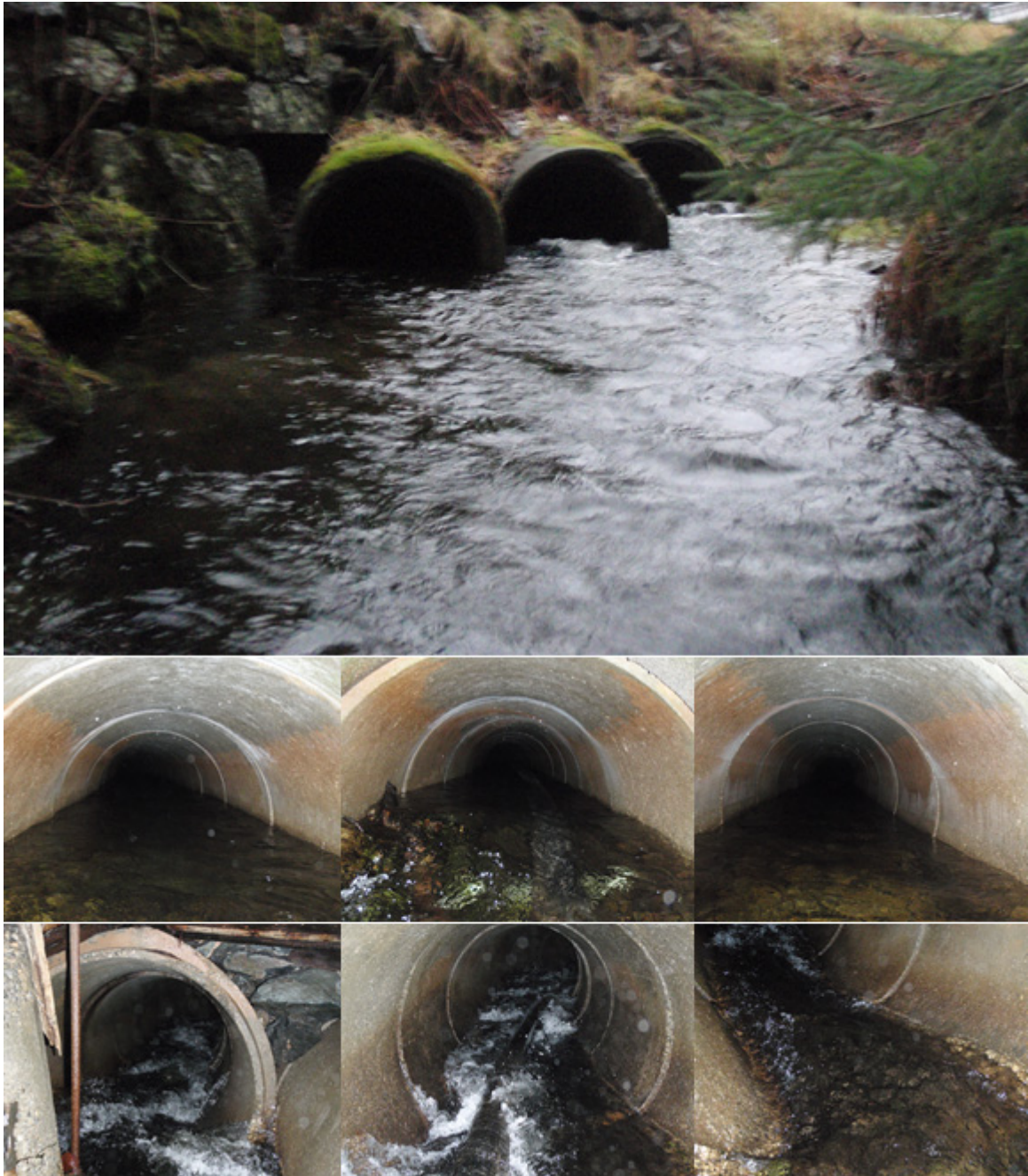
Figur 52. Krysning under Fv 559 med tre betongrør (øverst), og innside av betongrørene oppstrøms og nedstrøms veien
