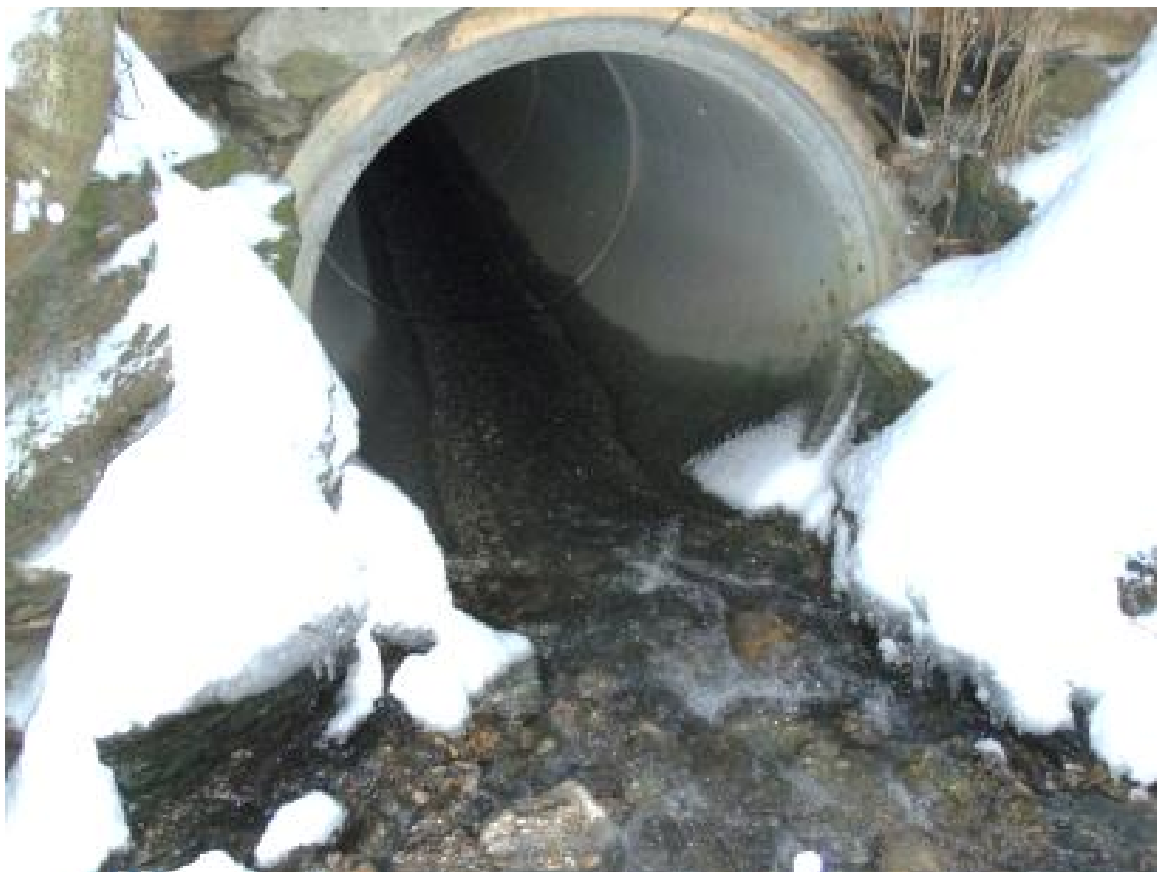
Figur 42. Kulvert under E 16.
