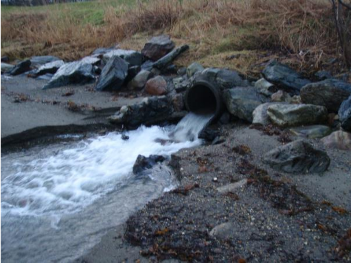
Figur 31. Bekken er lagt i kulvert under jordbruksarealer og Fv 61.
