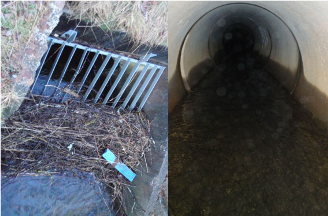
Figur 34. Innløp til kulvert under Fv 219 i Juvikbekken.
