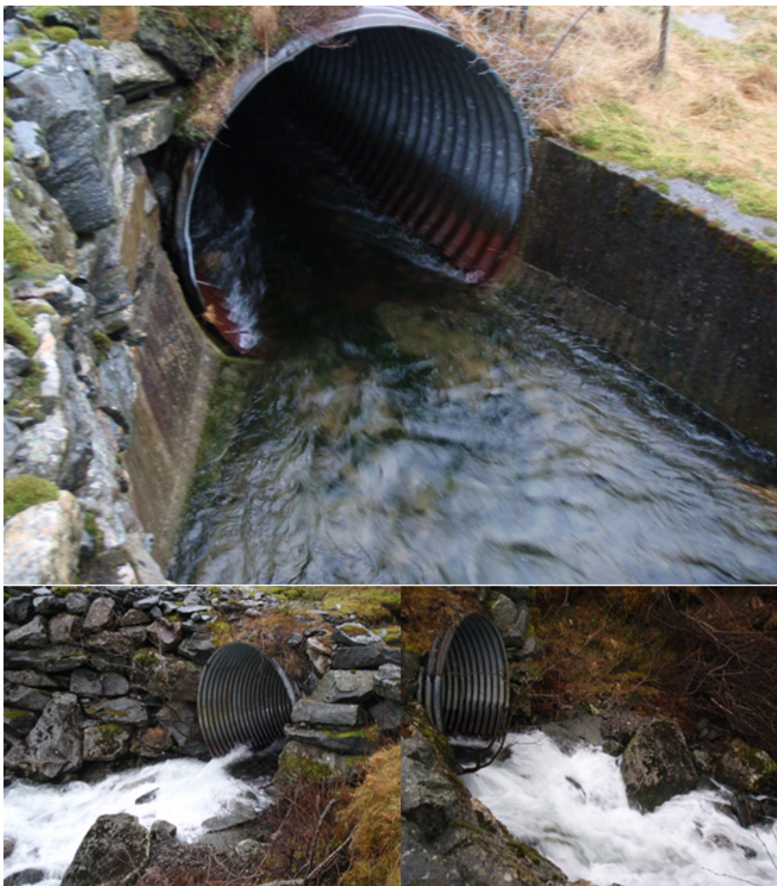
Figur 57. Innløp (øverst) og utløp (nederst).
