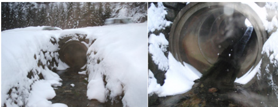
Figur 61. Kulvert under E 39
