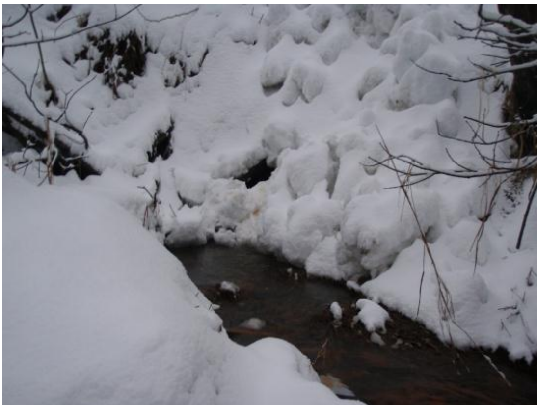
Figur 36. Bak et deponi av snø er utgangen av kulverten under Fv 7 i sidebekken til Steinsdalselva.
