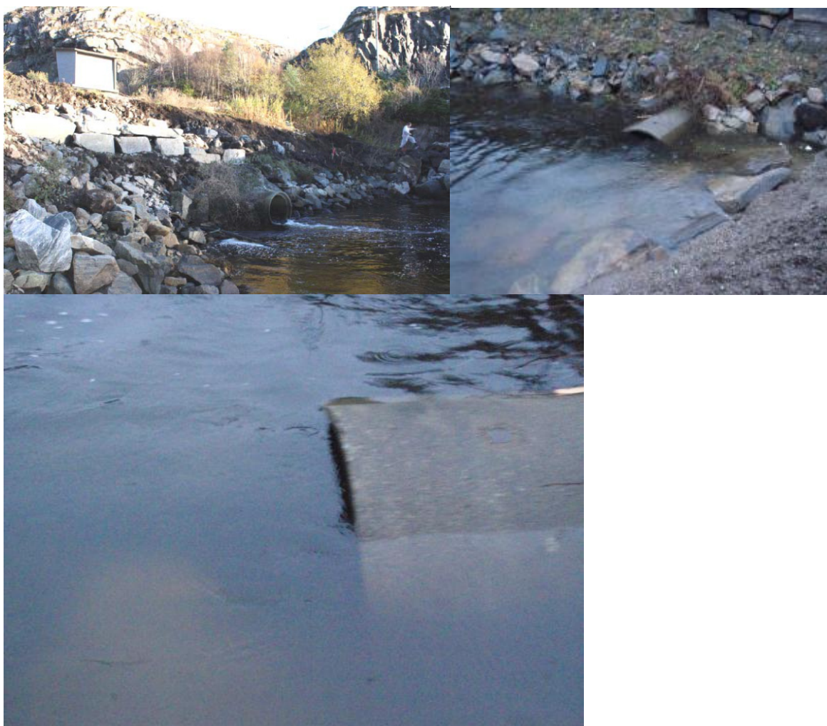
Figur 48. Munning til sjø i kulvert under Fv 210 i Apalvågselva på fjære og lav vannføring (øverst t.v. fra Pulg m.fl. 2010) og på høyvann (t.h. og under).
