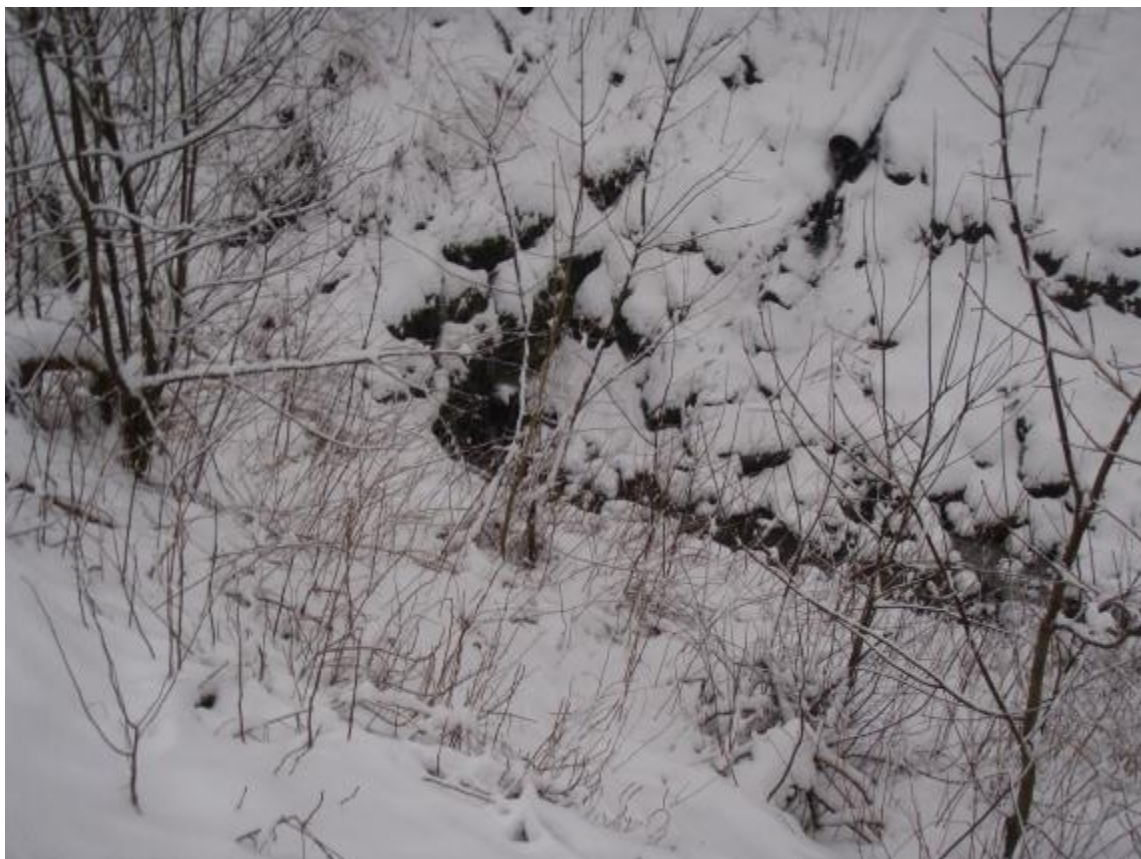
Figur 38. Steinsbekken går under veien i større veifyllingskulvert.
