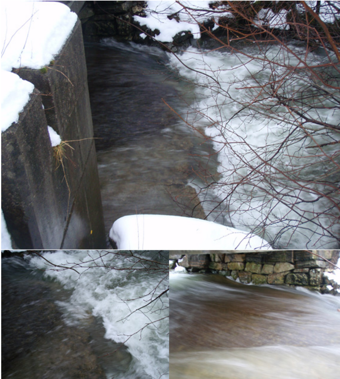
Figur 58. Kulvert under Vikanesveien.
