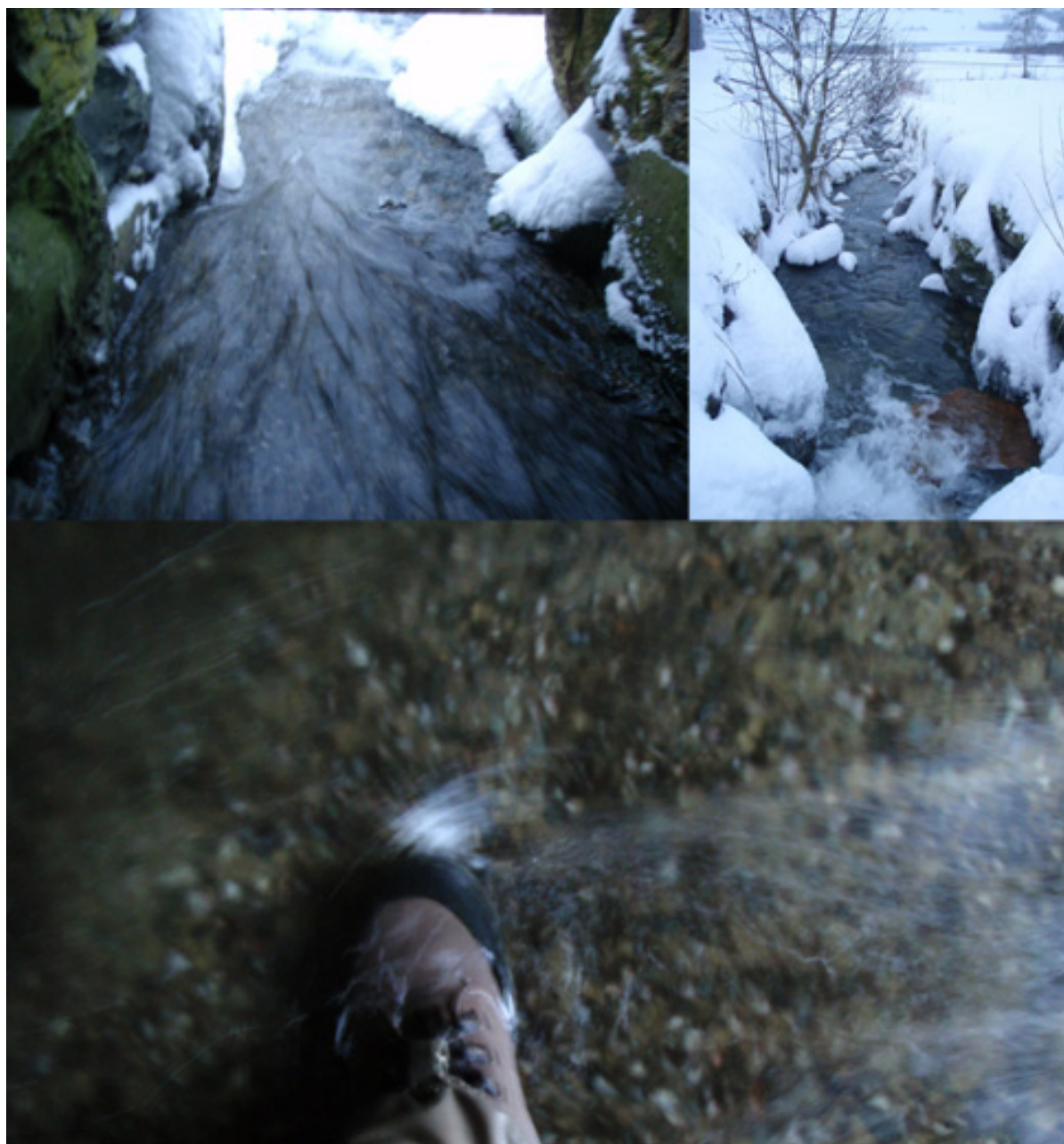
Figur 43. Kulvert under Fv 312.
