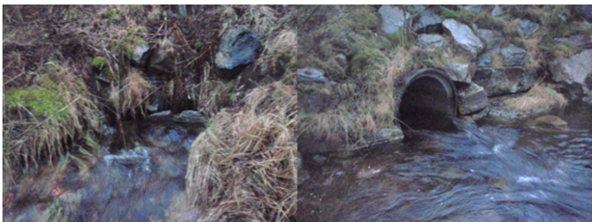
Figur 45. Lekkasje gjennom veiforbygningen (t.v.) og kulvertutløp (t.h.) på høy vannføring ved Fv 210.
