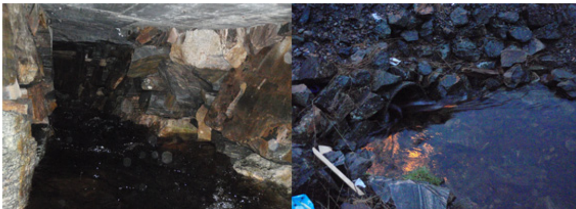
Figur 46. Kulvert under Fv 211 på høy vannføring.
