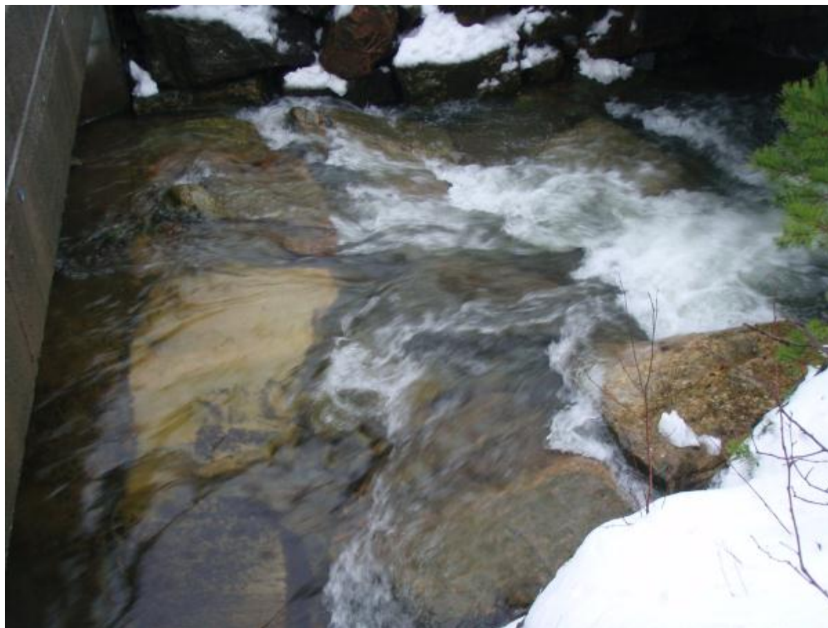
Figur 59. Parti mellom kulvert under E39 og Vikanesveien.
