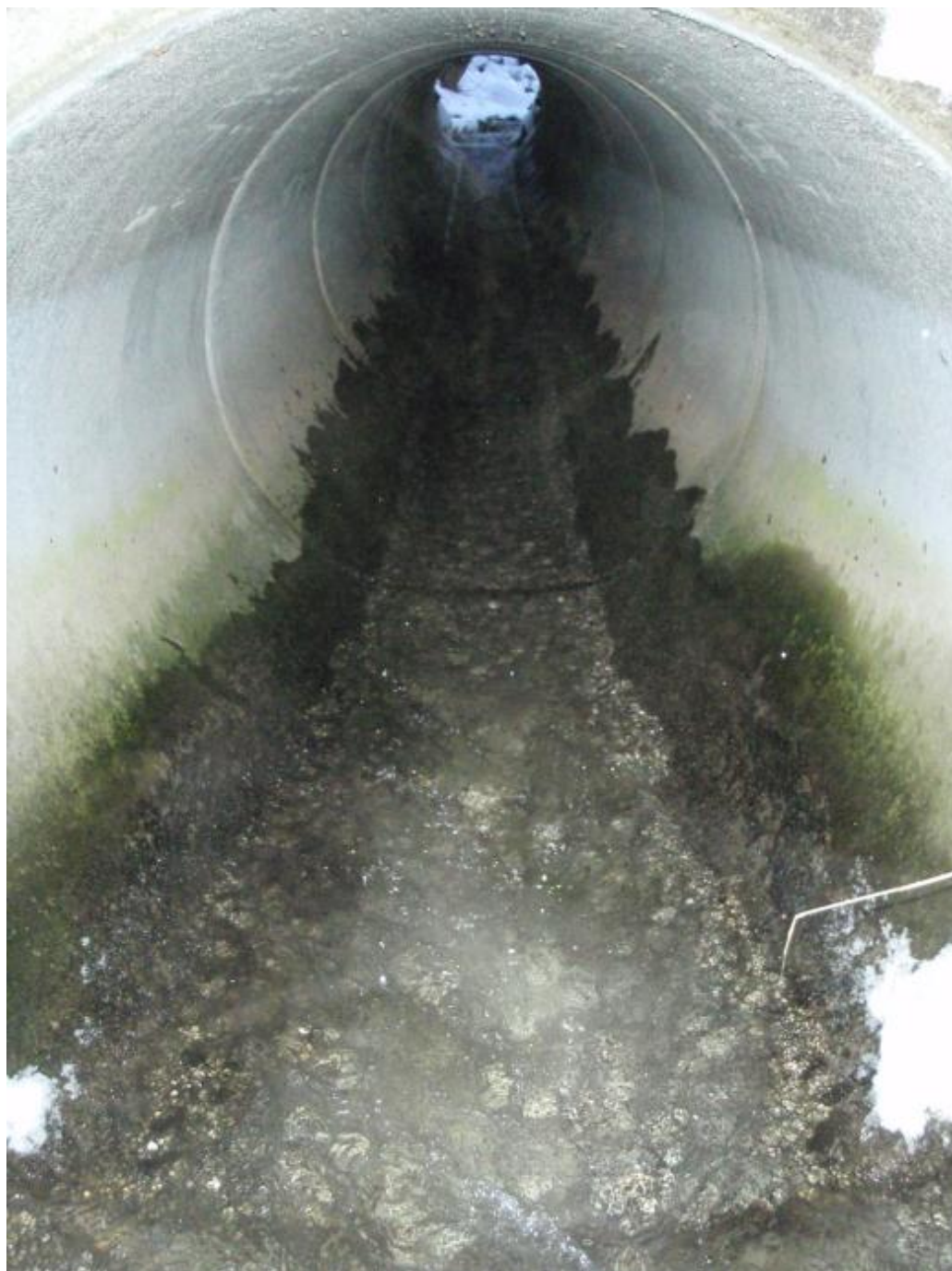
Figur 41. Kulvert under E 16.
