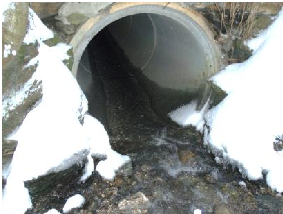
Figur 42. Kulvert under E 16.
