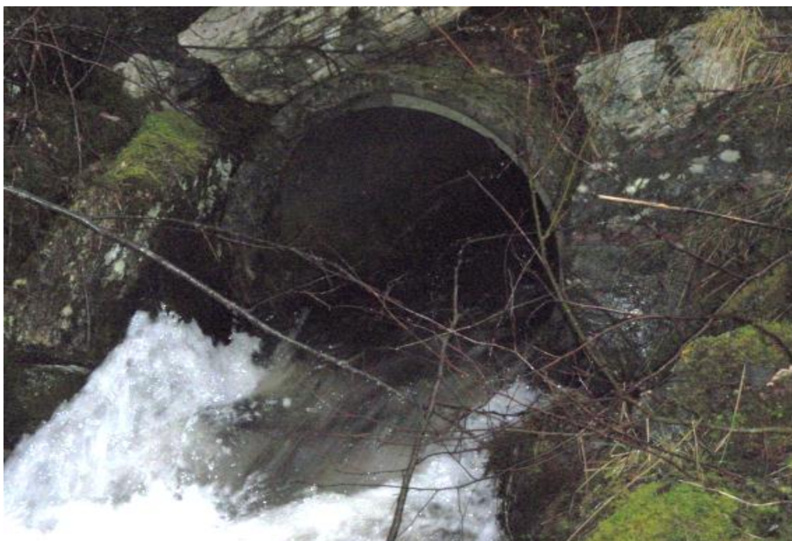
Figur 55. Kulvert under E 39.
