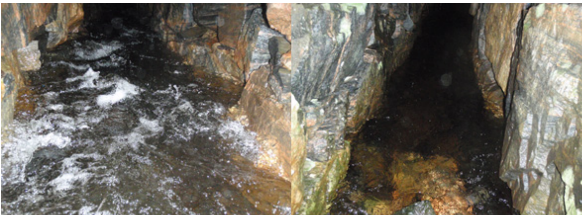
Figur 50. Innside av stikkrenne med sikker kontinuitet (t.v.) og forbygd stikkrenne hvor vann går gjennom forbygningen.
