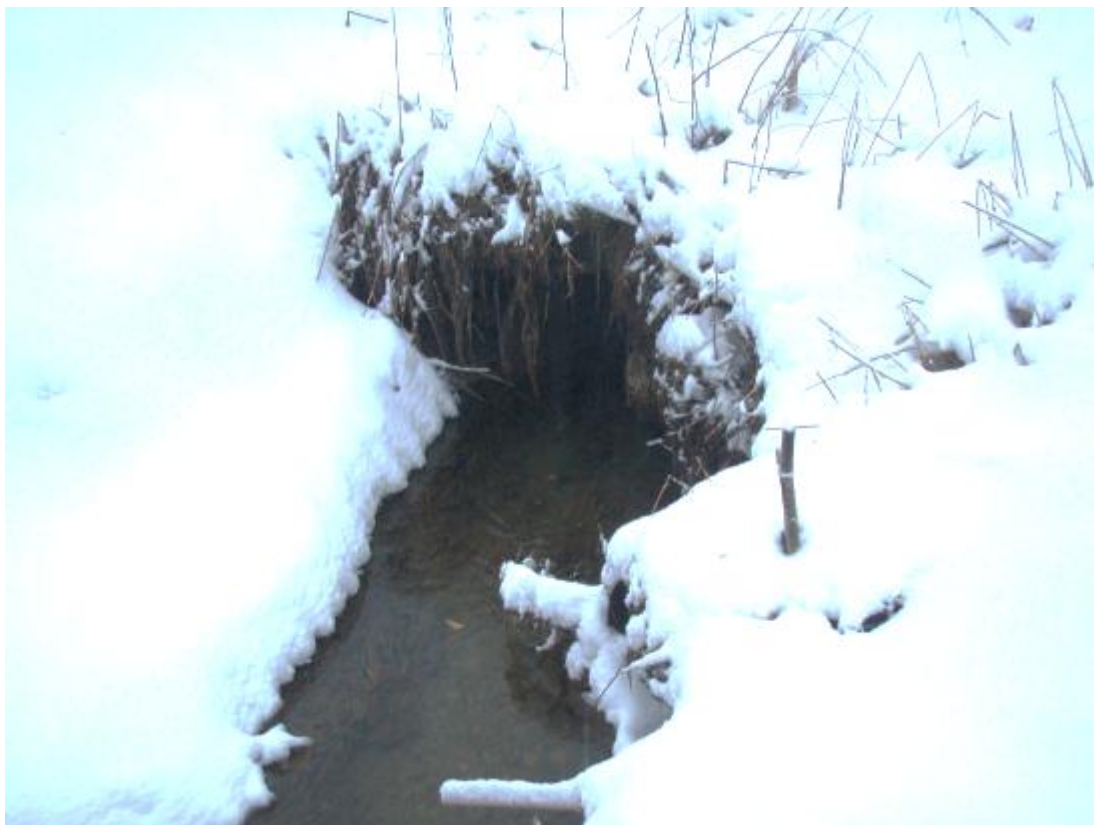
Figur 37. Inngang til kulvert under Fv 7 i sidebekk til Steinsdalselva.
