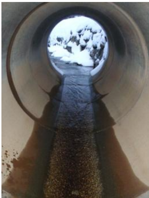
Figur 62. Kulvert i forbindelse med krysning under E 39. Foto opp mot innløp.
