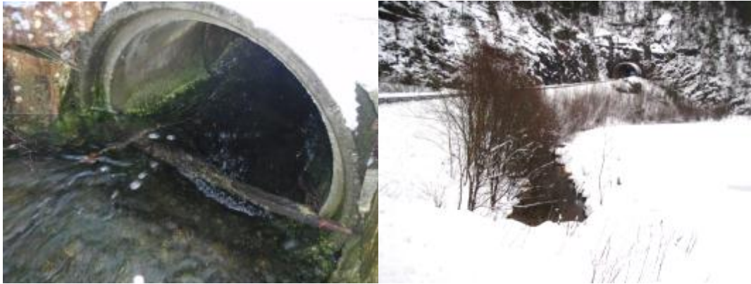
Figur 60. Kulvert under Fv 539 i Lona, og bekkeløp nedstrøms.
