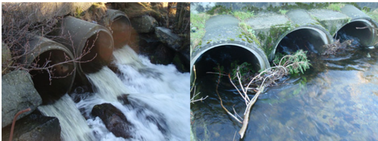
Figur 38. Inngang (t.h.) og utgang (t.v.) av kulvert under Rv13 i Strandåna.
