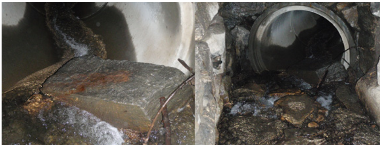
Figur 49. Kulvert under E39 i sidebekk
