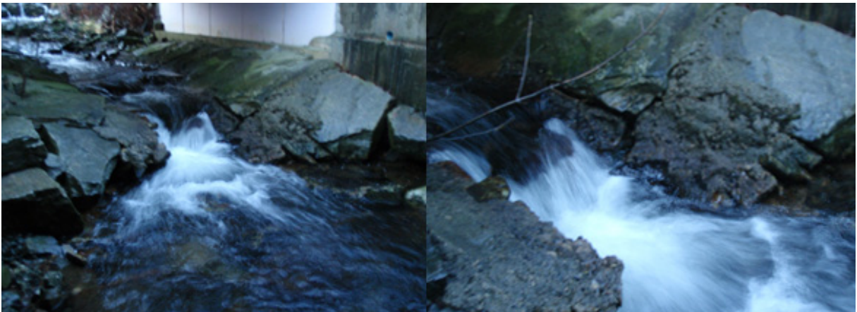
Figur 47. Murt betongbunn under E 39.
