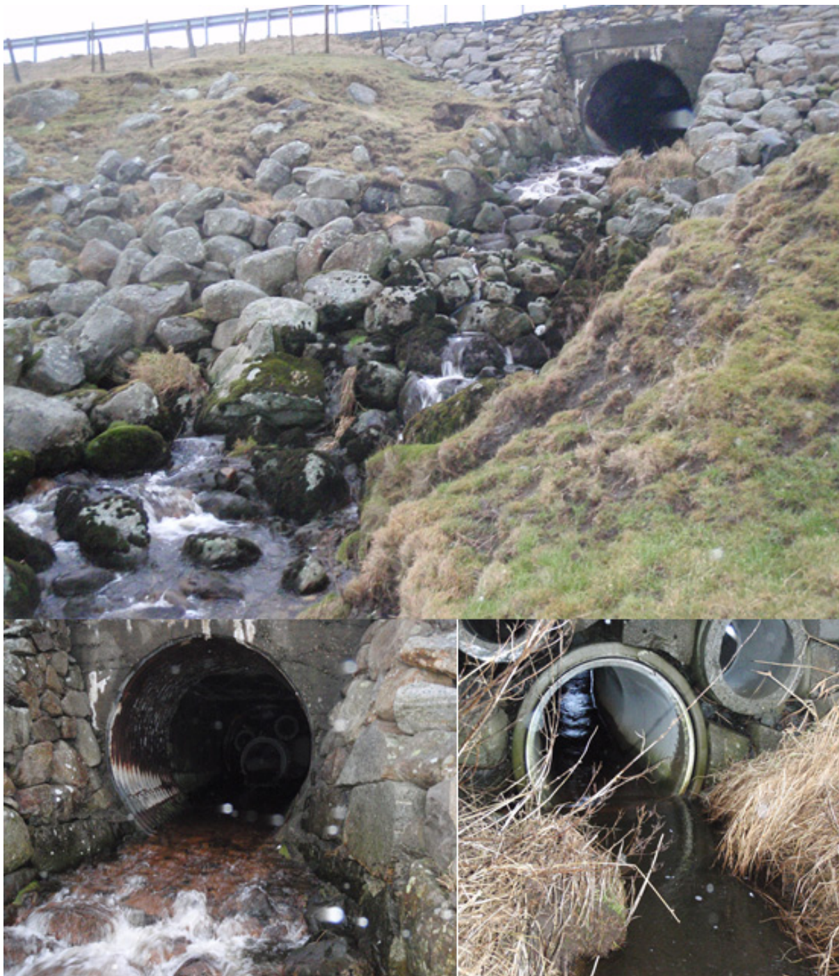
Figur 33. Krysningsområde (øverst) og kulvertens ut-(t.v.) og innløp (t.h.).
