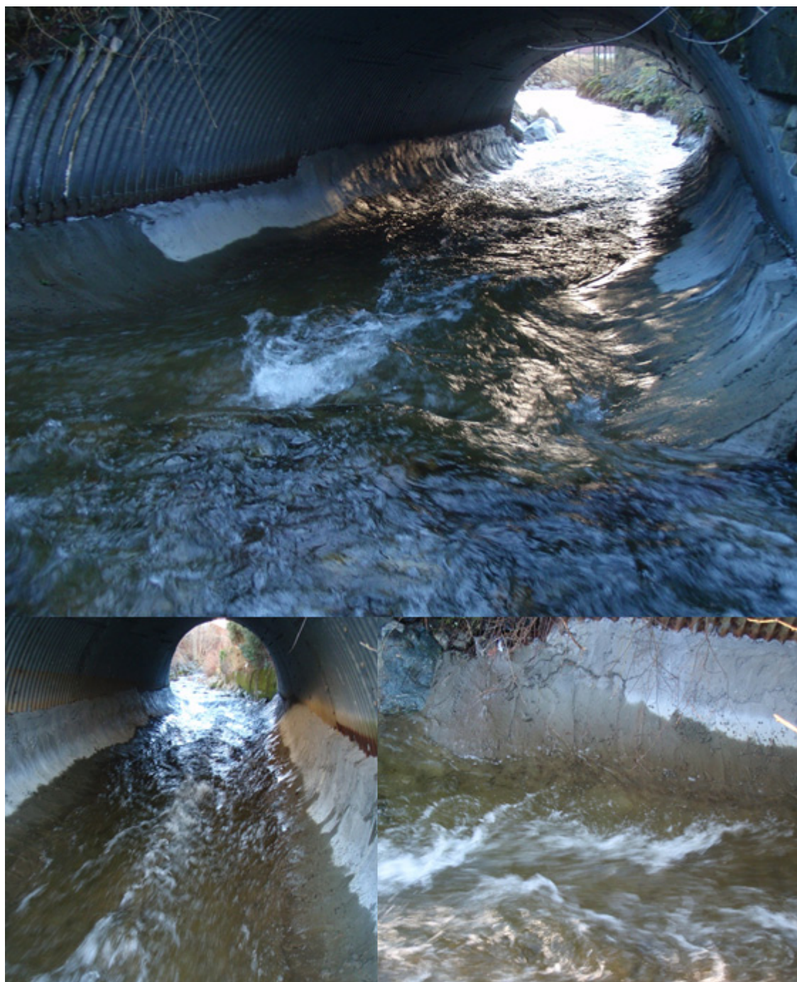
Figur 36. Kulvert under Rv 13 i Skardbekken.
