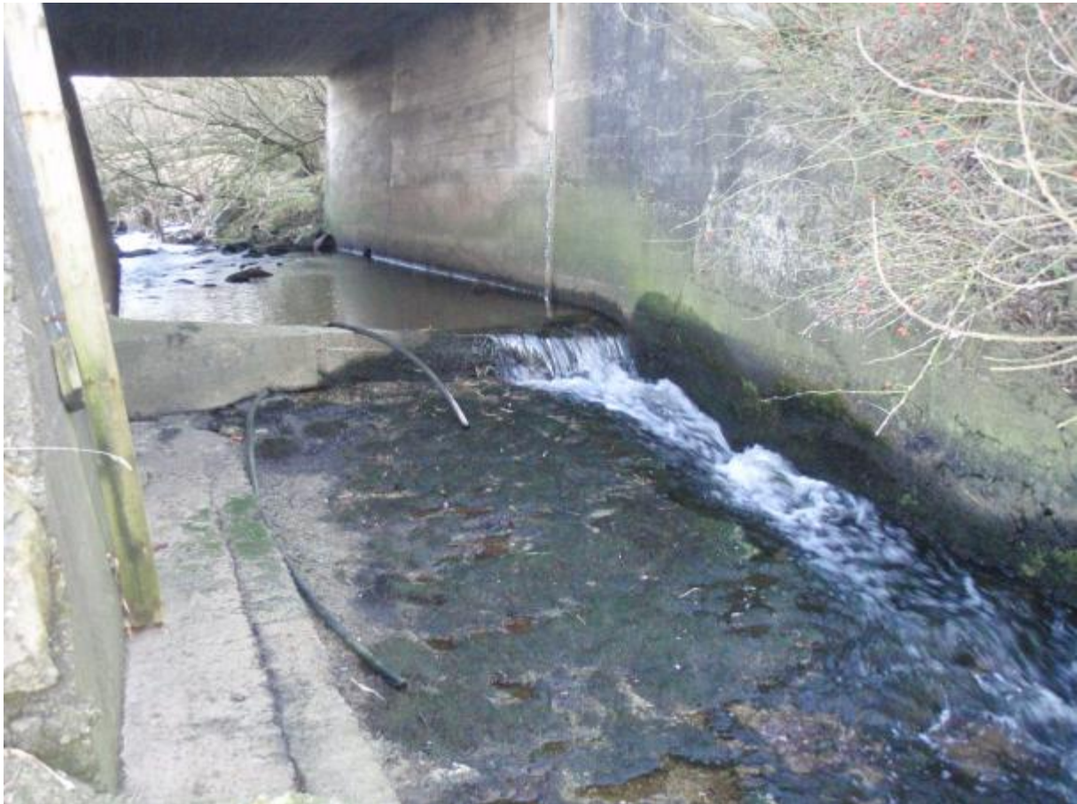
Figur 31. Kulvert under Fv 44 i Årslandsåna.
