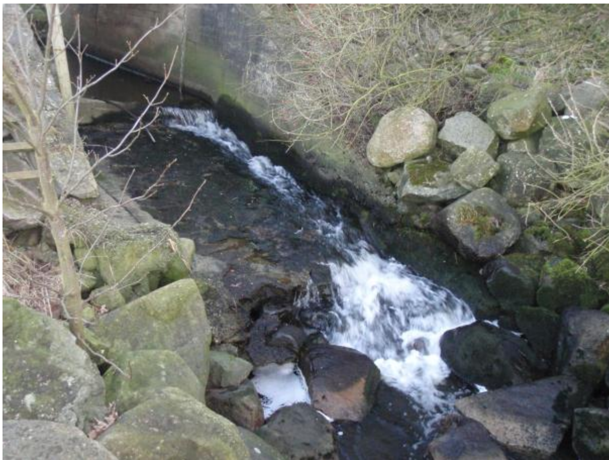
Figur 32. Kulvert under FV 44 i Årslandsåna.
