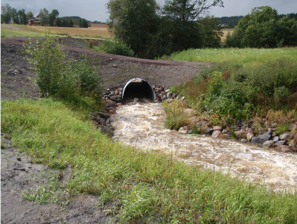
Figur 15. God krysning som ivaretar fiskevandring i Sverstadbekken.
