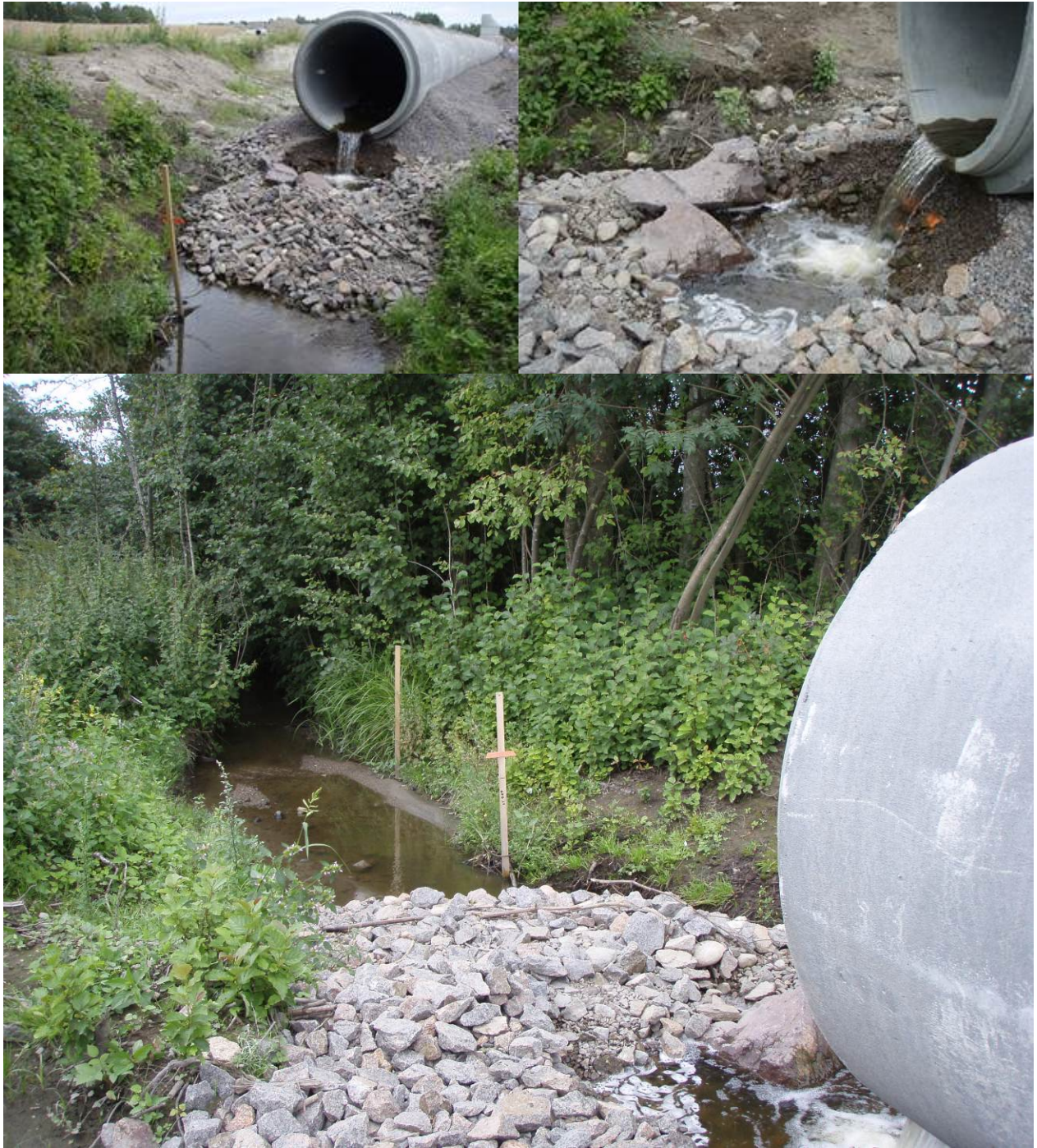
Figur 19. Nyanlagt kulvert i Homannsbekken i anleggsfasen på lav vannføring i 2009.
