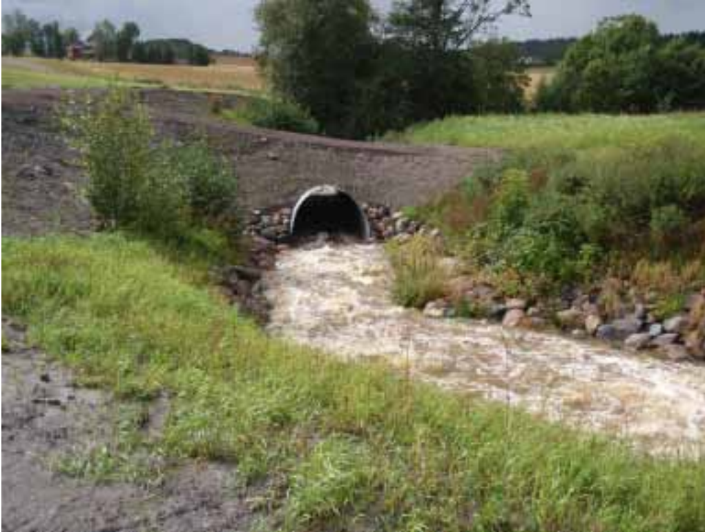
Figur 15. God krysning som ivaretar fiskevandring i Sverstadbekken.
