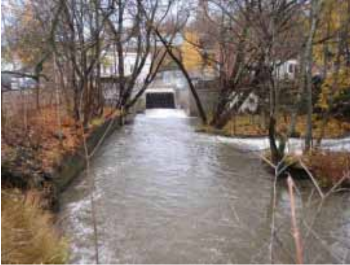
Figur 78. Kulvert under Enebakkveien (4) etter Kværnerfossen (3) i Alna. Foto: NIVA
