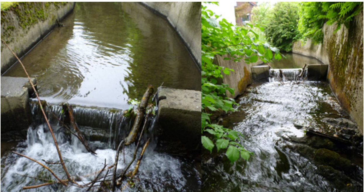
Figur 67. Demning (5), som i dag er vandringshindrende, med muligheter for å sperre for vandring av fisk dersom man setter en treplanke på tvers. Foto: NIVA.
