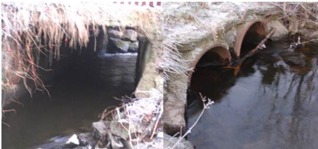
Figur 108. Kulvert under Rådyrstien (t.v.)(8) og Leirskallhellinga (t.h.)(9). Foto: NIVA
