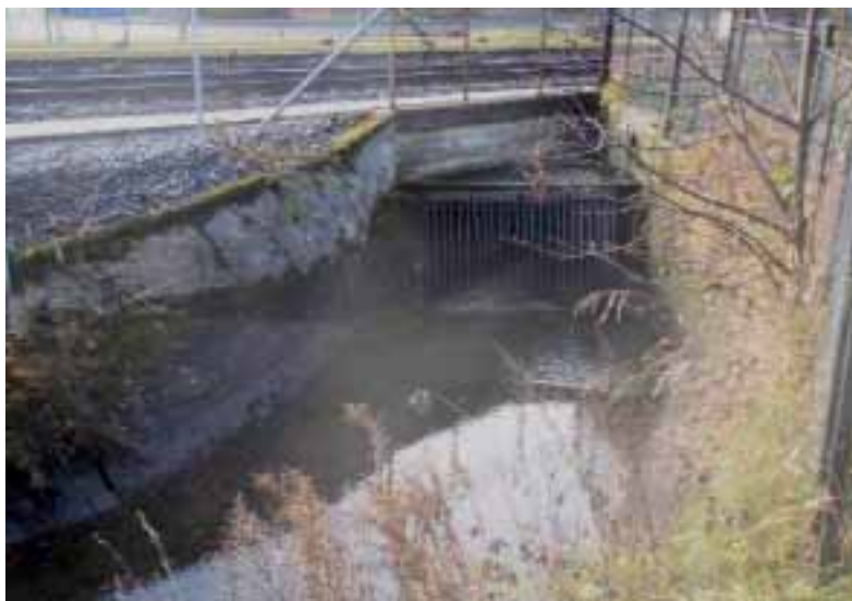
Figur 75. Kulvert (8) nedstrøms HOV2, der Hovinbekken går i bakken over en lengre strekning. Foto: NIVA
