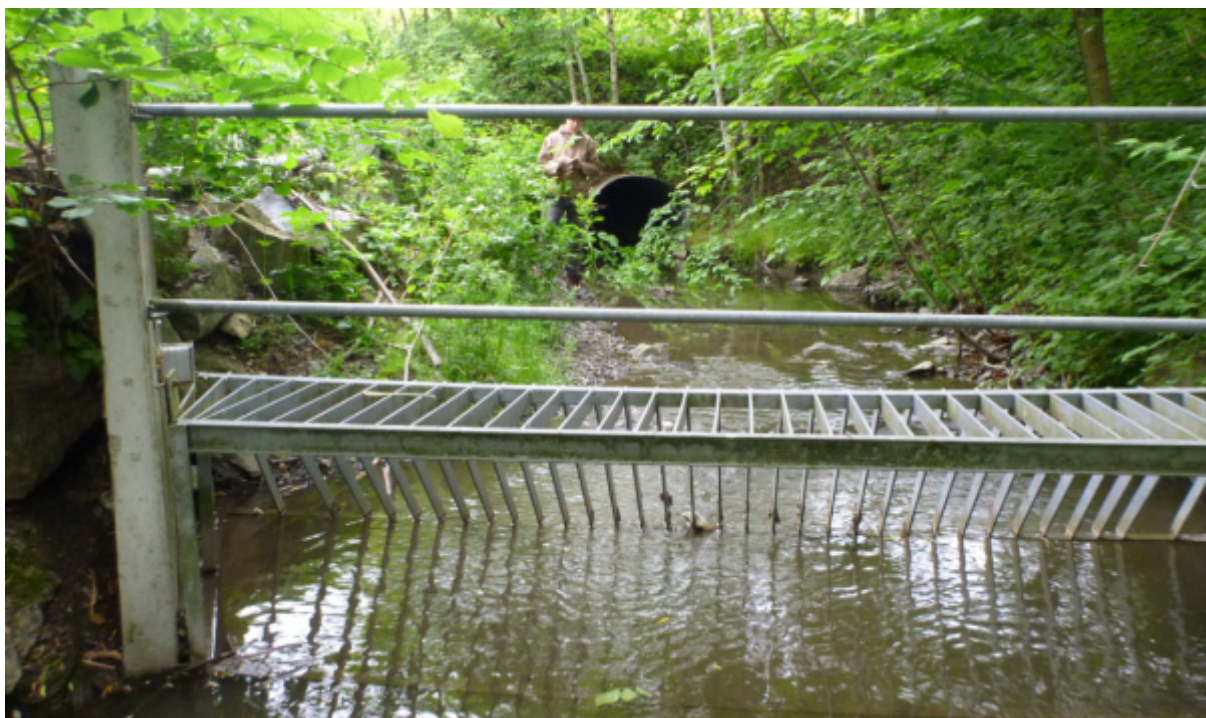
Figur 12. Rist på tvers av bekkestrengen før kulvert under jernbanen (3). Foto: NIVA
