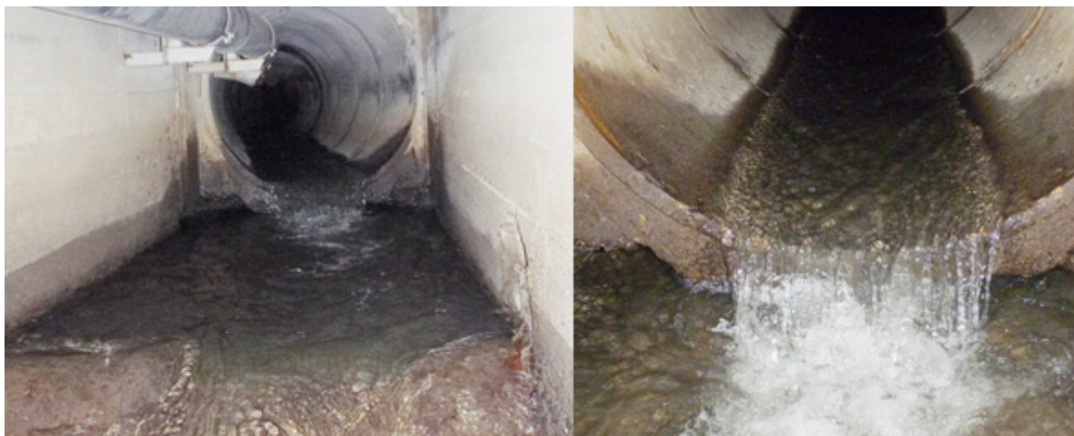
Figur 5. Lukking under E 18 (1), der vanndybder, vannhastighet og sprang til sammen utgjør svært vandringshindrende partier for anadrom laksefisk. Foto: NIVA
