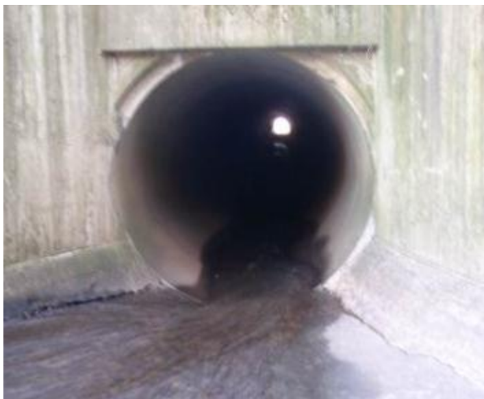
Figur 38. Kulvert under Ring 3 (1). Foto: NIVA
