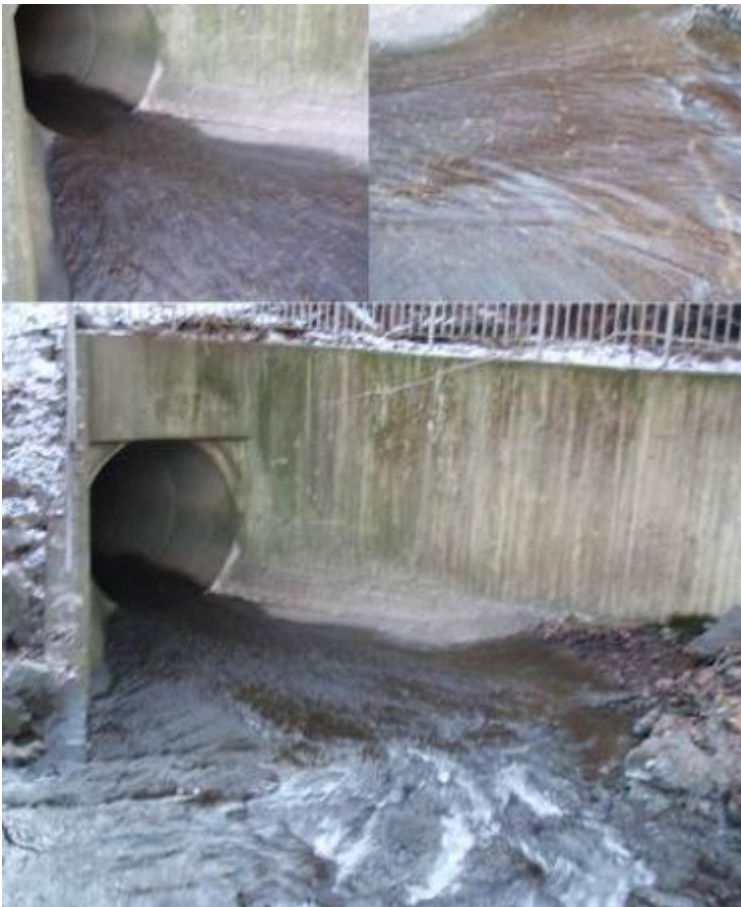
Figur 37. Kulvert under Ring 3 (1). Foto: NIVA
