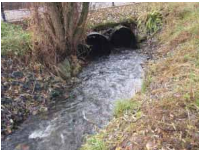
Figur 74. Kulvert (7) som ikke er til hinder for fiskevandring i stasjonsområdet HOV2. Foto: NIVA
