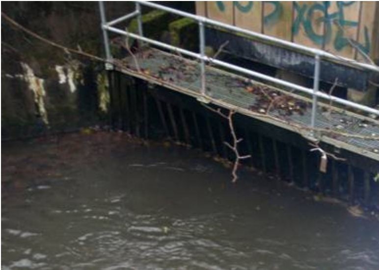
Figur 42. Inngangen til kulvert i nedre del av Frognerelva (1). Foto: NIVA
