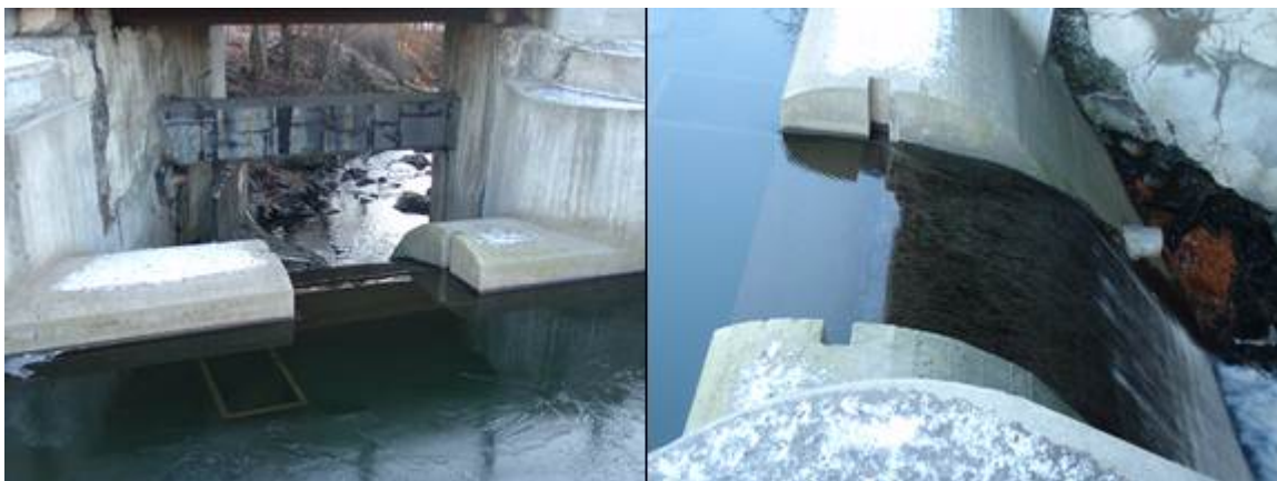
Figur 36. Demning nedstrøms øvre Smestad-dam (1). Foto. NIVA
