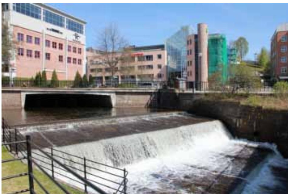
Figur 62. Terskel mellom AKR3 og AKR2 (15)(Foto: Bymiljøetaten).
