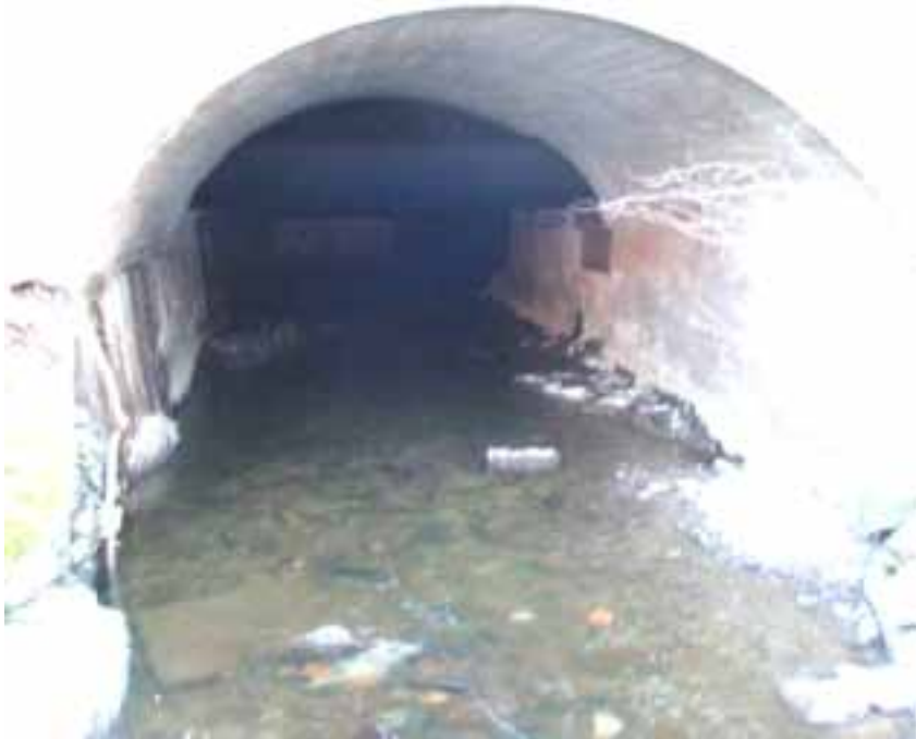
Figur 27. Kulvertinnløp Engebregts vei (2). Foto: NIVA
