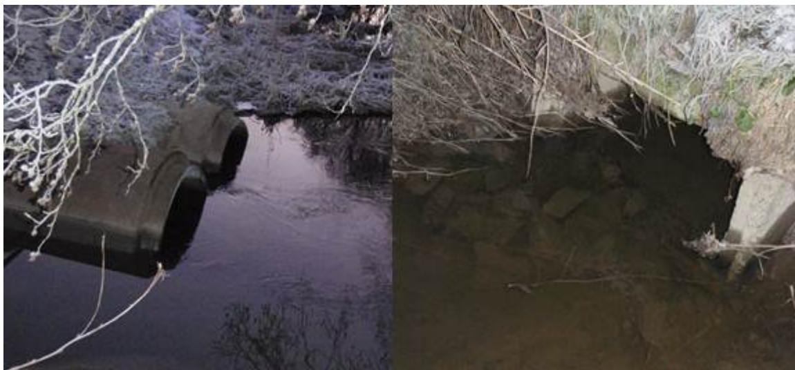
Figur 110. Ljanselvas (t.v.) og tilsigsbekkens (t.h.) krysninger under Enebakkveien (12). Foto: NIVA
