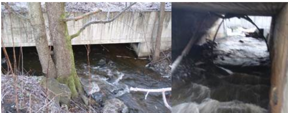
Figur 115. Krysning under Ljansbruveien med bevart bekkebunn (2). Foto: NIVA
