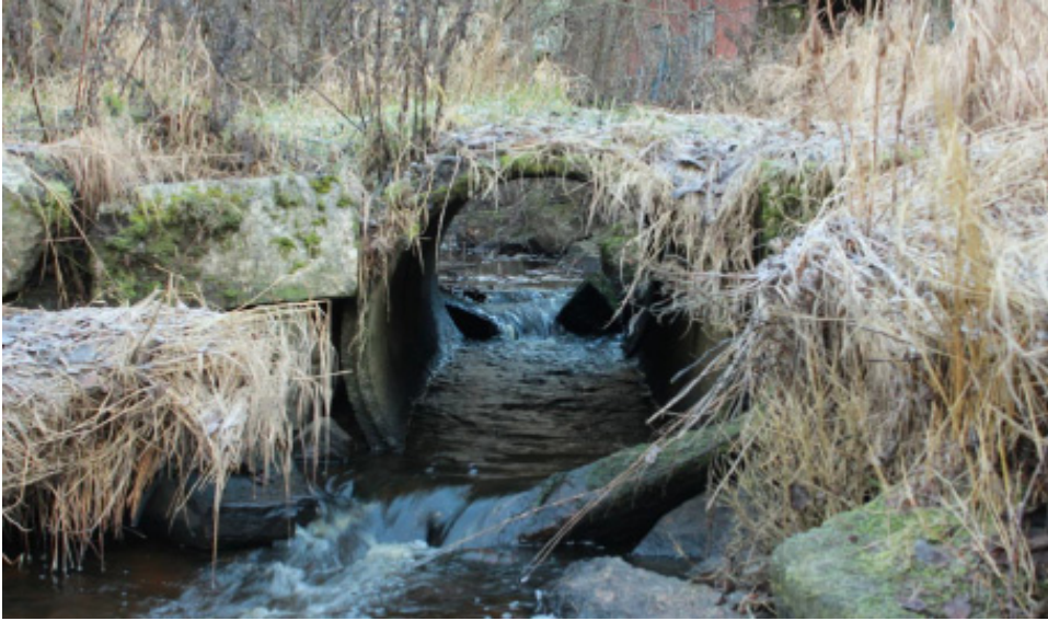
Figur 131. Kulvert/stikkrenne under grusvei/traktorvei (6). Foto: Bymiljøetaten
