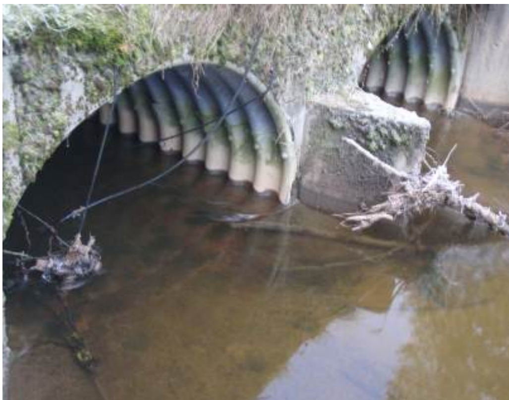
Figur 105. Kulvert Munkerudveien (6). Foto: NIVA
