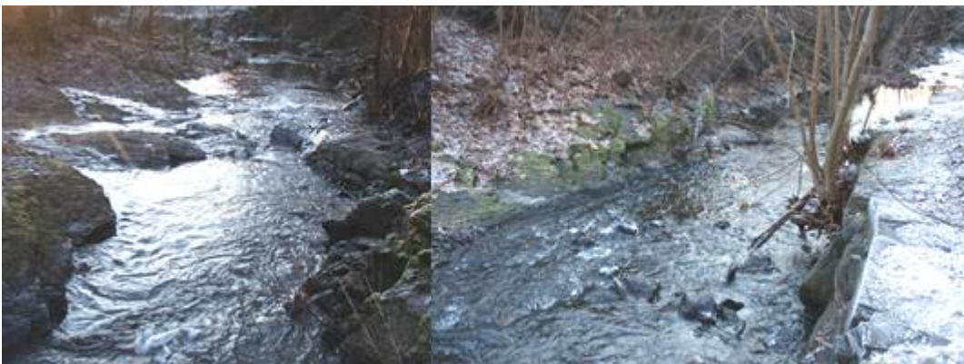
Figur 30. Strekninger oppstrøms kulvert under Engebregts vei. Foto: NIVA
