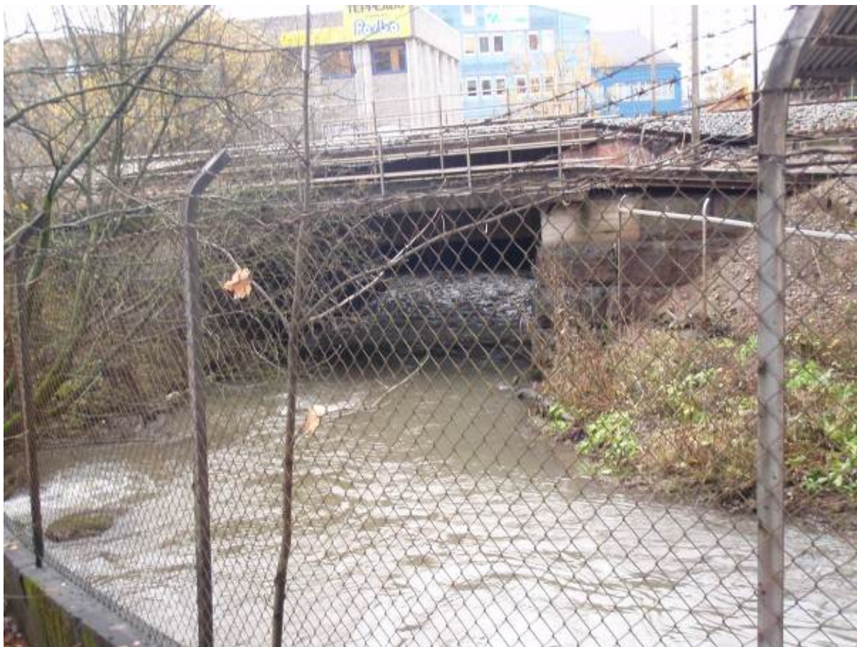
Figur 81. Alna ved Tvetenbrua, før lukking under industriområde ved Fyrstikkbakken (13). Foto: NIVA
