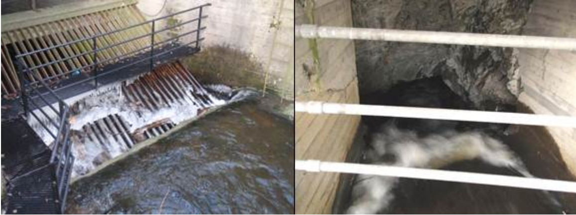
Figur 102. Kulvertinngang under jernbaneområde. Foto: NIVA
