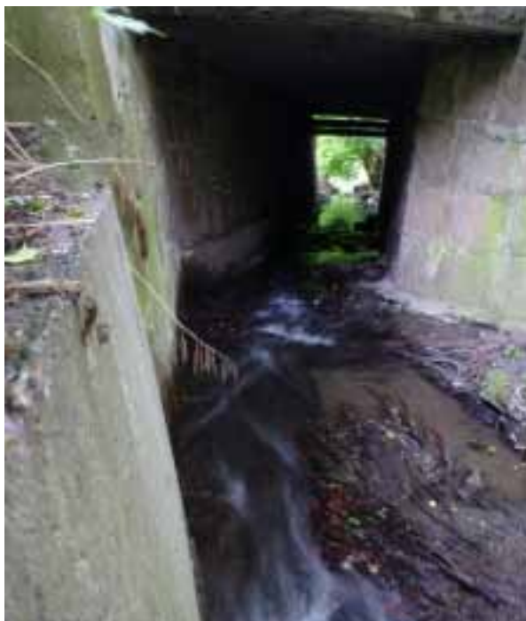
Figur 70. Kulvert under Økernveien (4). Foto: NIVA
