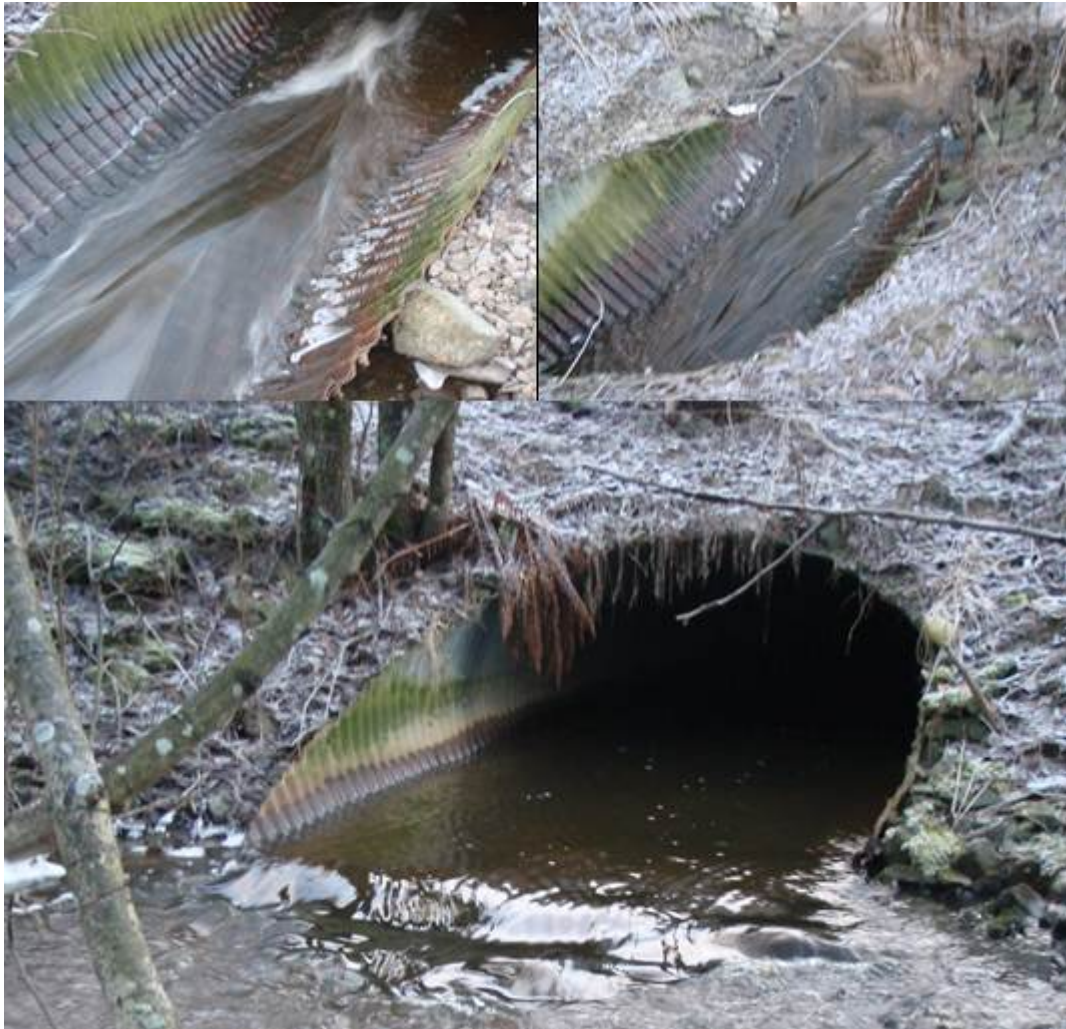
Figur 123. Kulvert Slimeveien (10). Utløp (nederst) og innløp (øverst). Foto: NIVA
