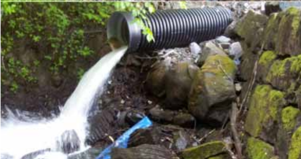
Figur 90. Alna ledes i rør nedenfor Trondheimsveien (øverst), forbi anleggsområdet ved dam og demning, og ut i sitt naturlige løp (nederst). Foto: NIVA.
