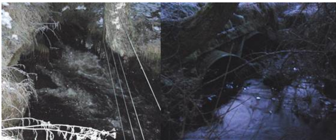
Figur 111. Kulvert under grusvei ved Smemo (14). Foto: NIVA
