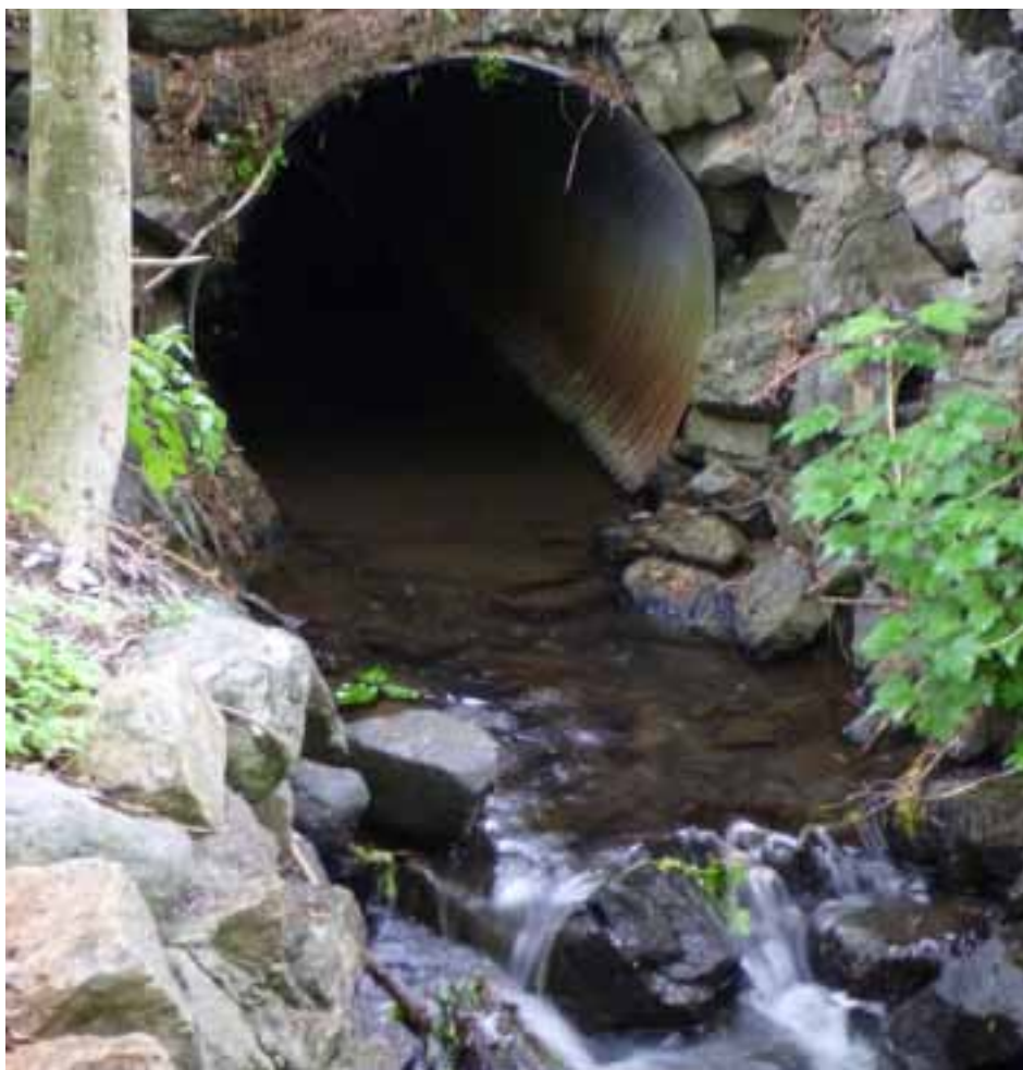
Figur 71. Kulvert under Brobekkveien (6). Foto: NIVA
