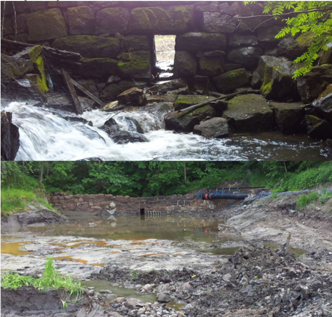
Figur 88. Demningsområdet og nedtappet dam (26). Foto: NIVA
