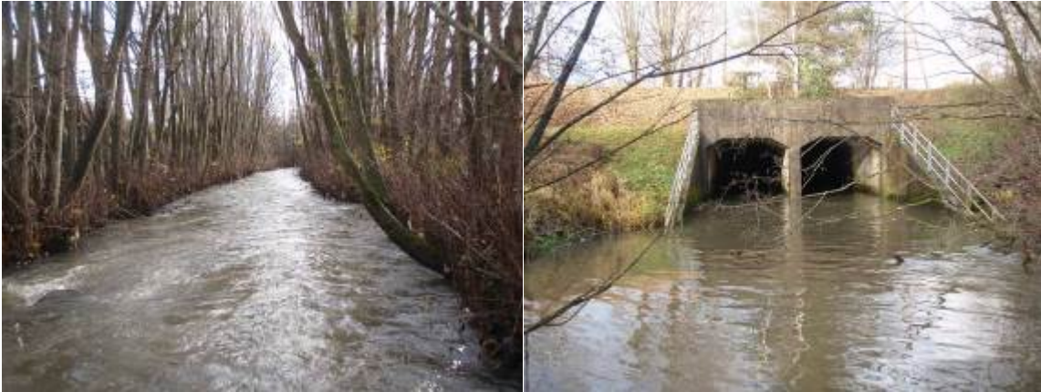
Figur 83. Stasjonsområdet ALN4 og dets elveavsnitt bærer preg av å være utrettet (til venstre). Utløpet av kulvert (16) ovenfor ALN4, som går under Alnabruterminalen (til høyre). Foto: NIVA
