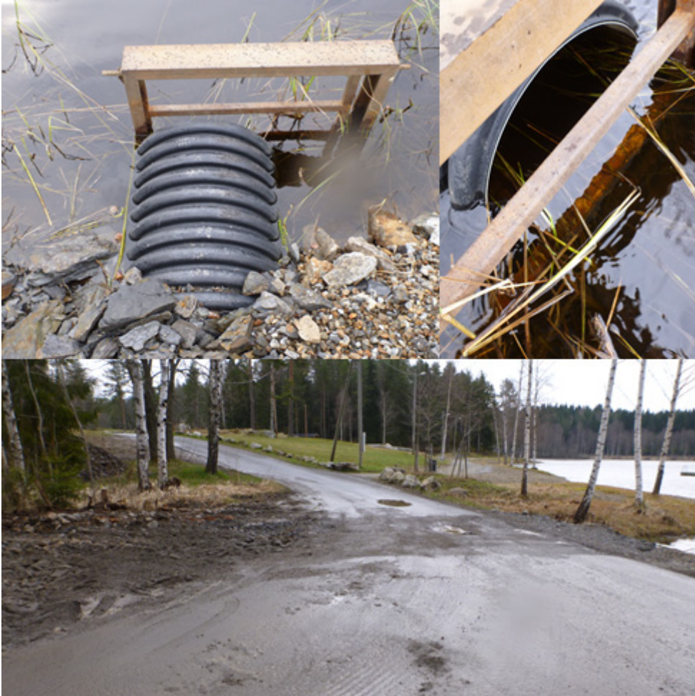
Figur 128. Inngang til kulvert ved utløpsbekken fra Stensrudtjern (øverst), og lukket strekning under Stensrudåsveien (1). Foto: NIVA
