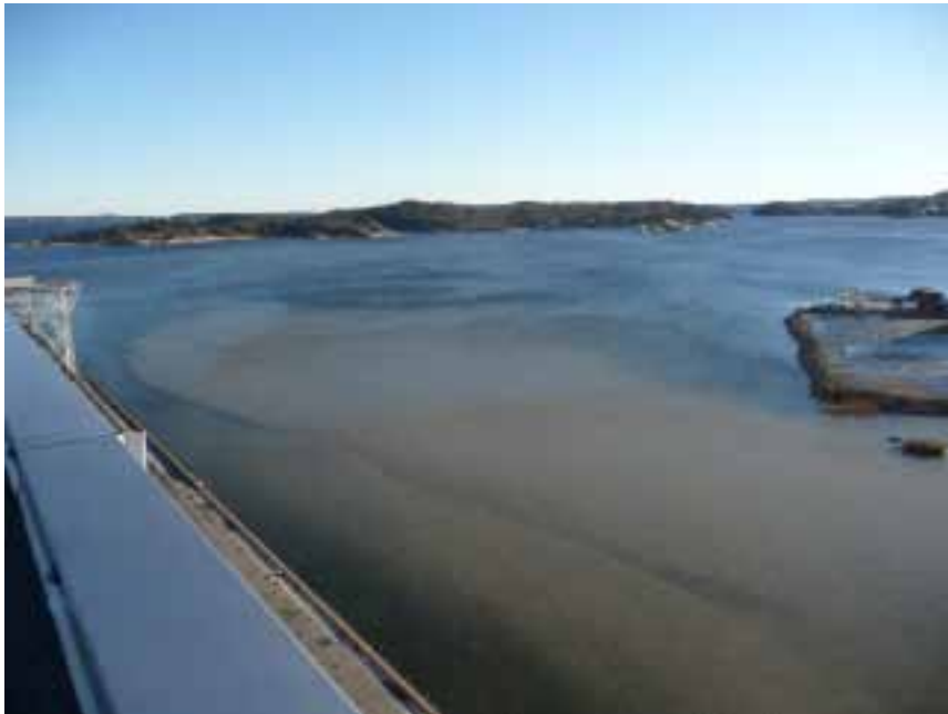
Figur 7. Synlig tilførsel av partikler fra arbeidet med ny Vågsbygdvei. Bildet viser typisk situasjon gjennom flere måneder i 2010 og 2011. Bilde fremskaffet av Bente Sundby Håland, Elkem Carbon.
