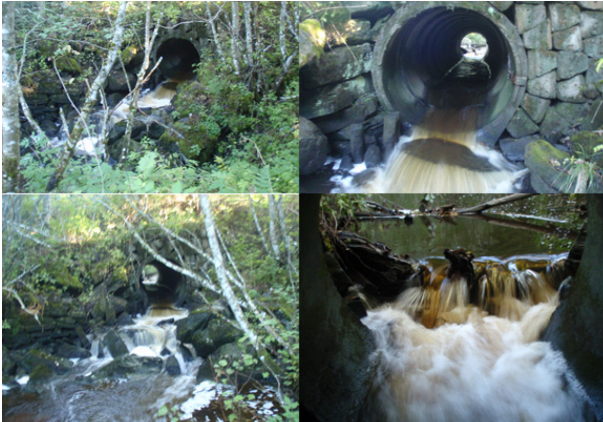
Figur 45. Kulvert under Fv 261 i Fløra.
