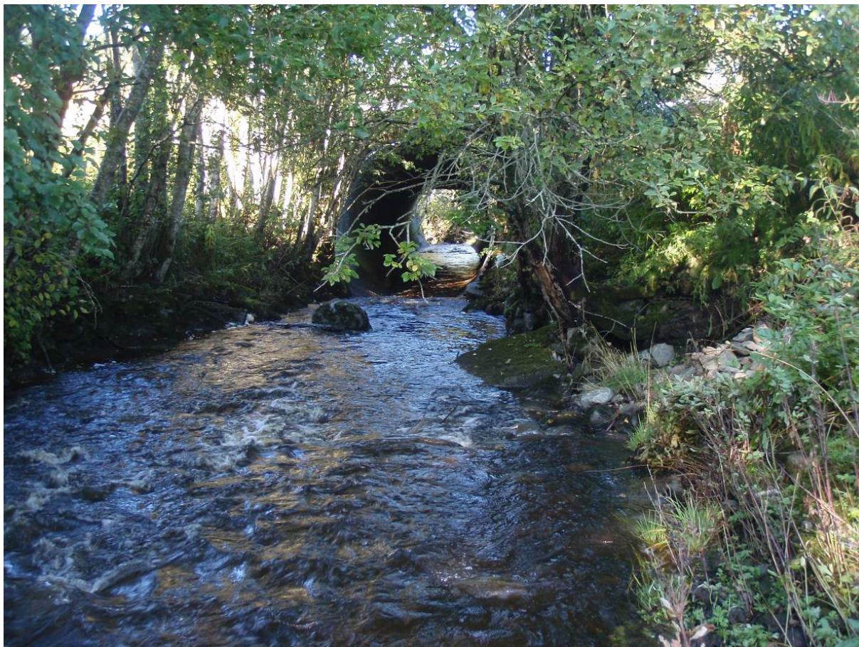
Figur 34. Kulvert under Fv 285 i Tessemelva.
