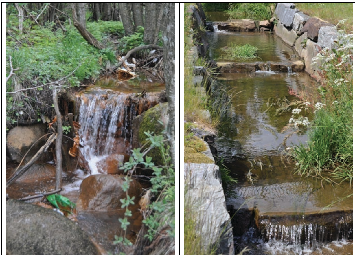
Figur 19. Naturlig vannfall med lufting i bekken ved Morholt (venstre bilde). Lokalteten bør utbedres til å være en av de 3-4 tersklene som etableres i bekken. Konstruerte terskler i Groosebekken i Grimstad kommune (bildet til høyre).
