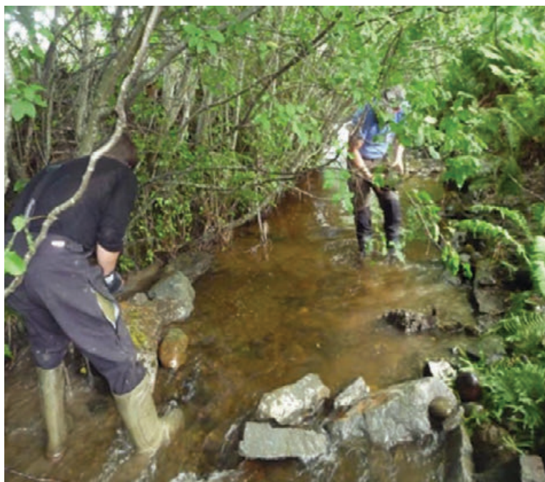
Figur 20. Eksempel på etablering av en utett terskel bestående av store stein.
