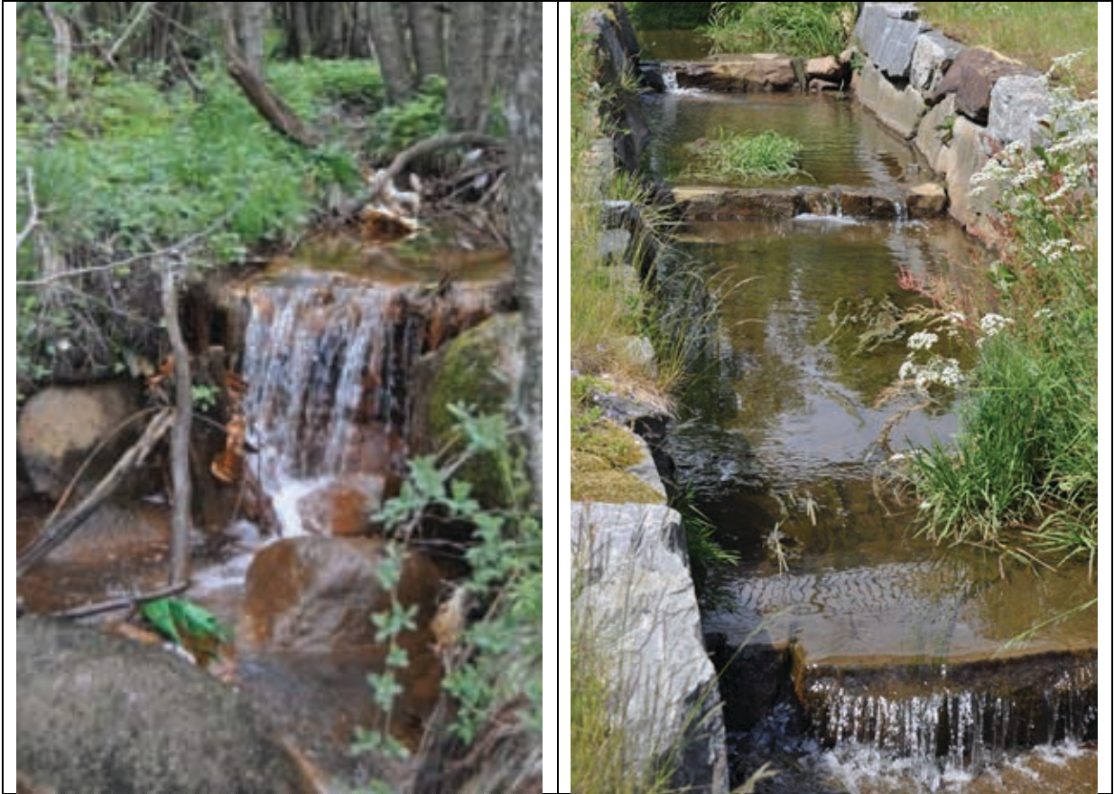
Figur 19. Naturlig vannfall med lufting i bekken ved Morholt (venstre bilde). Lokalteten bør utbedres til å være en av de 3-4 tersklene som etableres i bekken. Konstruerte terskler i Groosebekken i Grimstad kommune (bildet til høyre).
