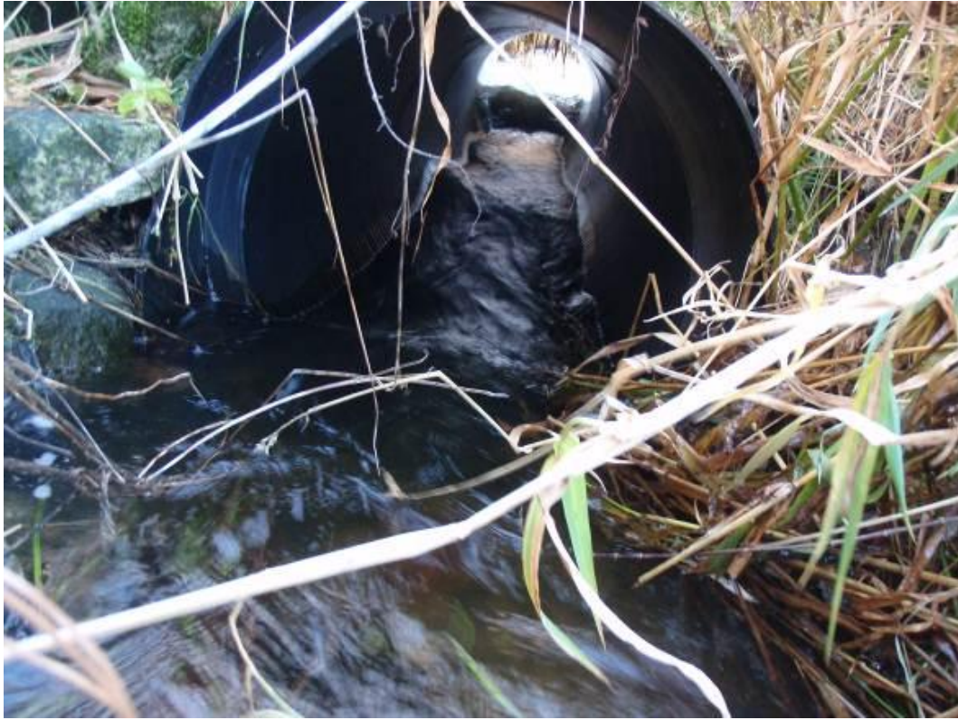
Figur 74. Krysning under gårdsvei i nedre deler av utløpsbekken fra Litlvatnet.
