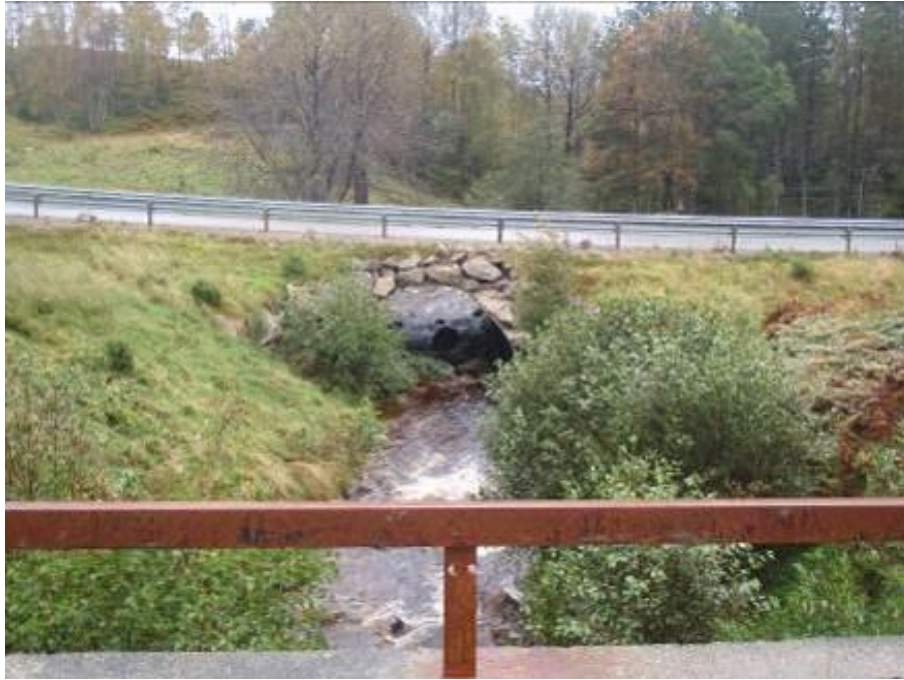
Figur 13. Krysning med bevart bekkebunn under Fv 713.
