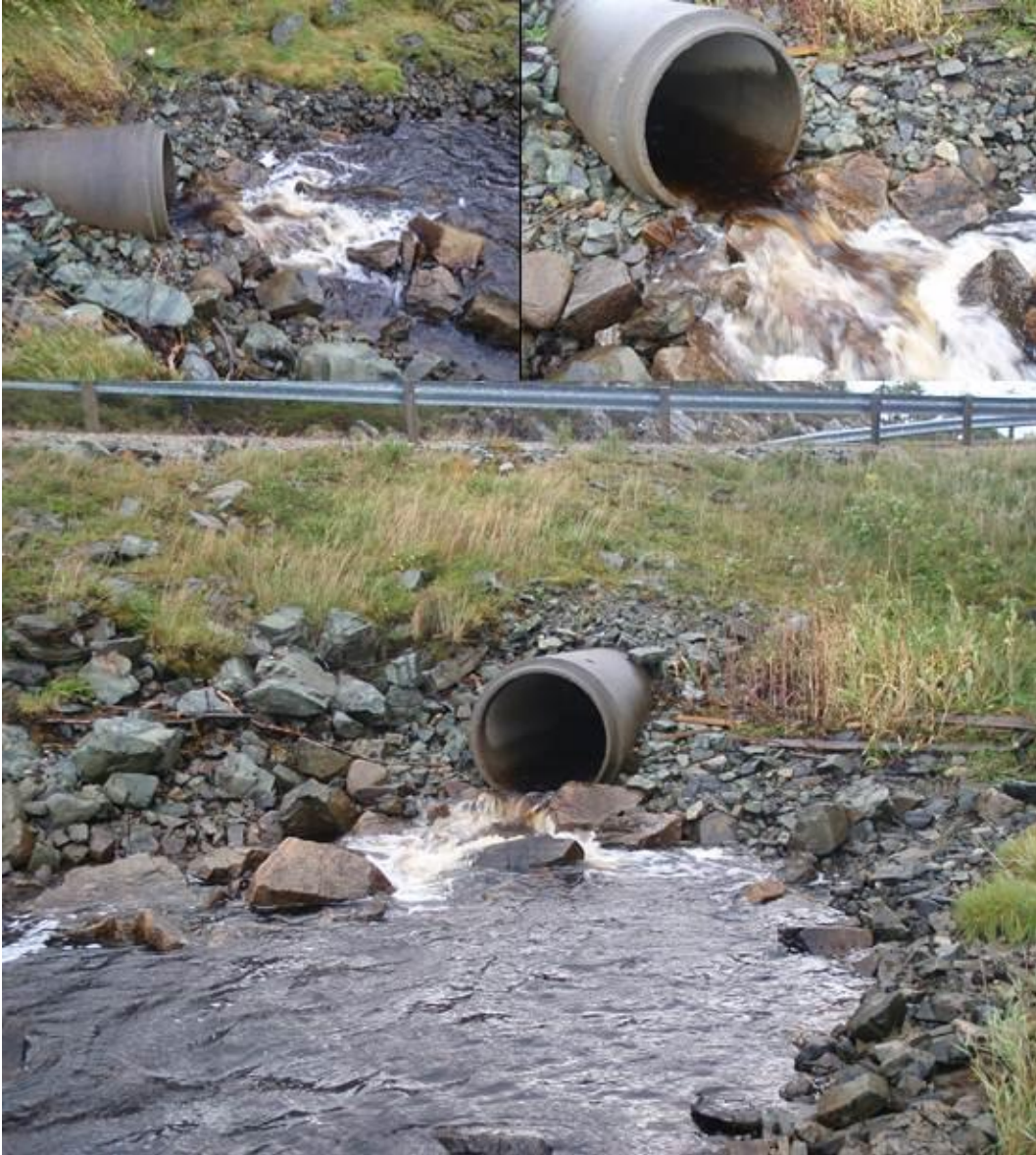
Figur 17. Kulvert under Fv 713 bekk fra Fløvatnet ved høyvann.
