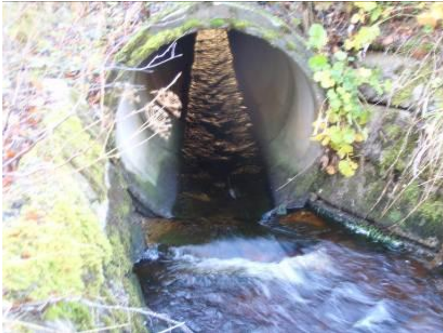
Figur 112. Kulvert under Fv 342.
