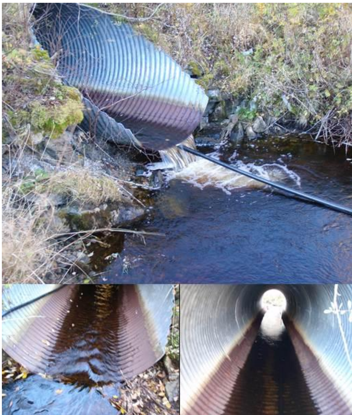
Figur 82. Kulvert under Fv 714 i Fauslandsbekken.
