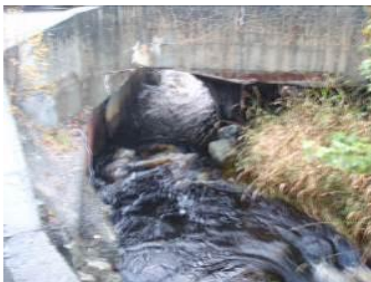
Figur 6. Kulvert under privat vei.
