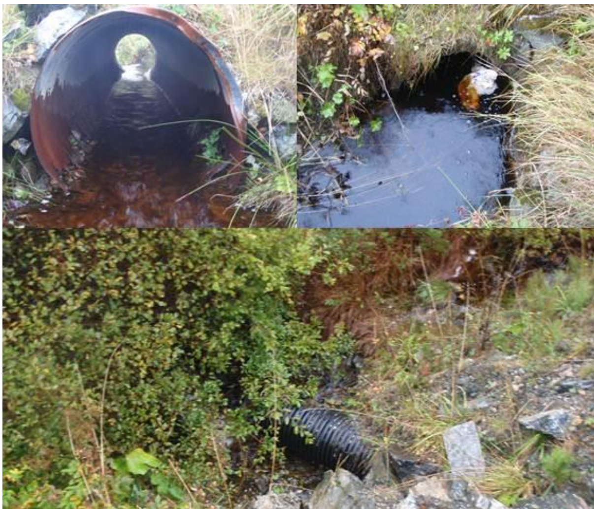
Figur 47. Krysning under privat grusvei (øverst tv.), nedre krysning under Fv 713 (øverst t.h.) og øvre krysning under Fv 713 (nederst) i tilløpsbekken til Litlsandvatnet.
