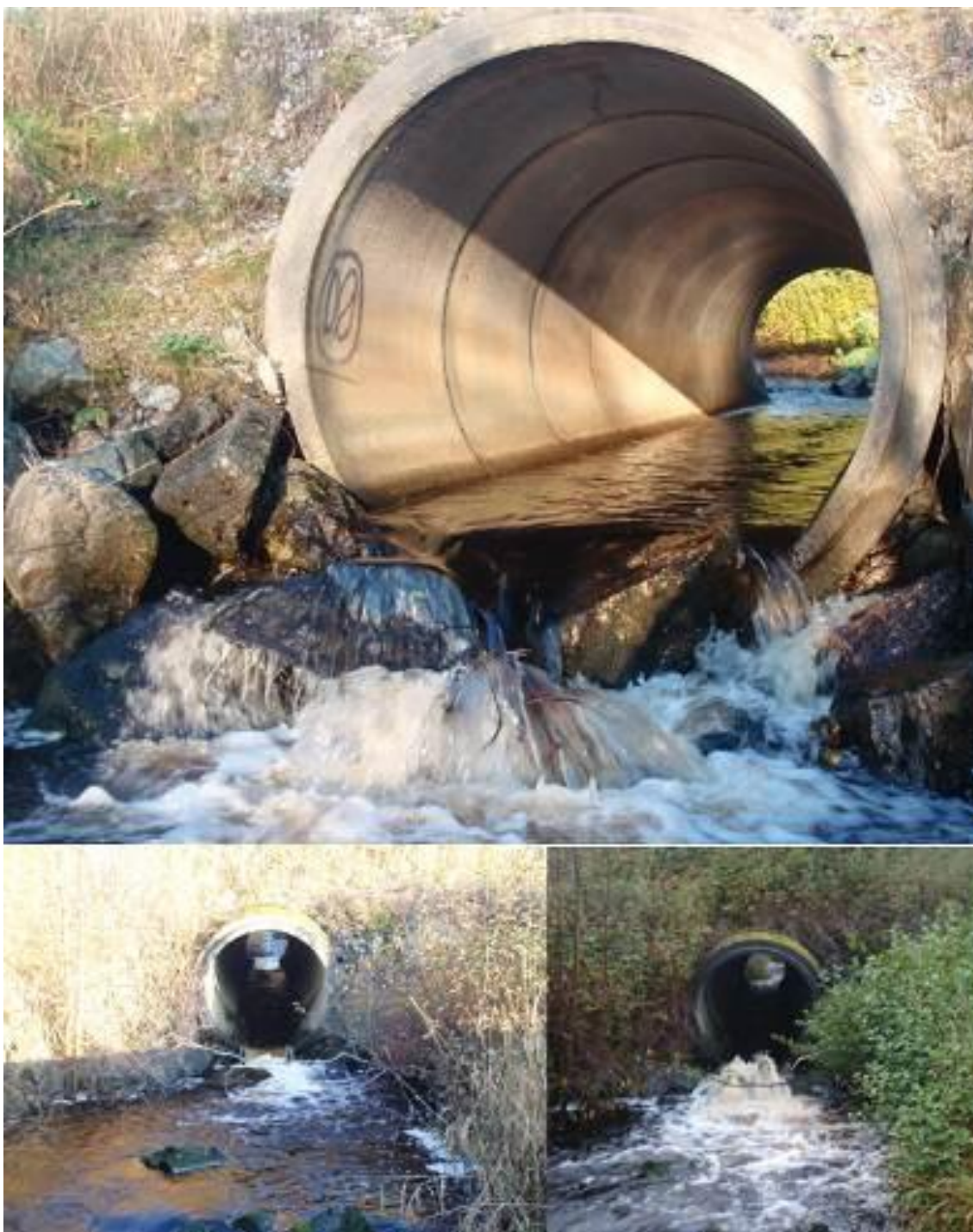
Figur 7. Kulvert under Fv 714, med utløpsenden på lav- (under, t.v.) og høy vannføring (under, t.h.).
