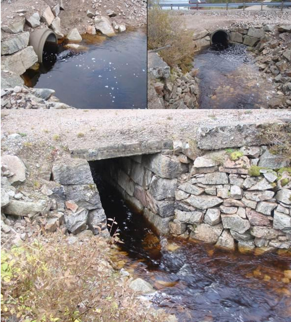
Figur 29. Kulvert under FV 713 (øverst) og krysning under grusvei (nederst).
