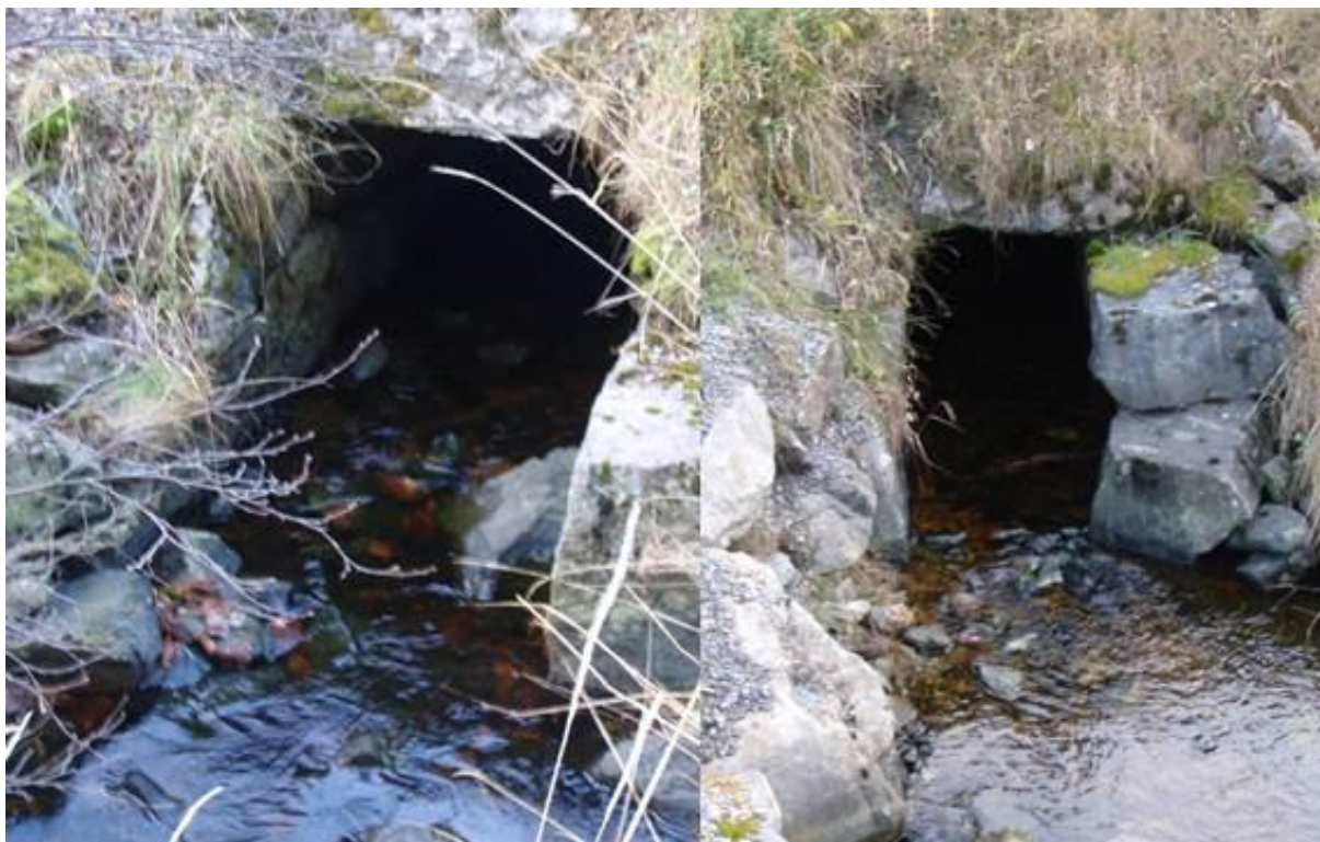
Figur 106. Inn- og utløp av steinkulvert (2) under Fv 381.
