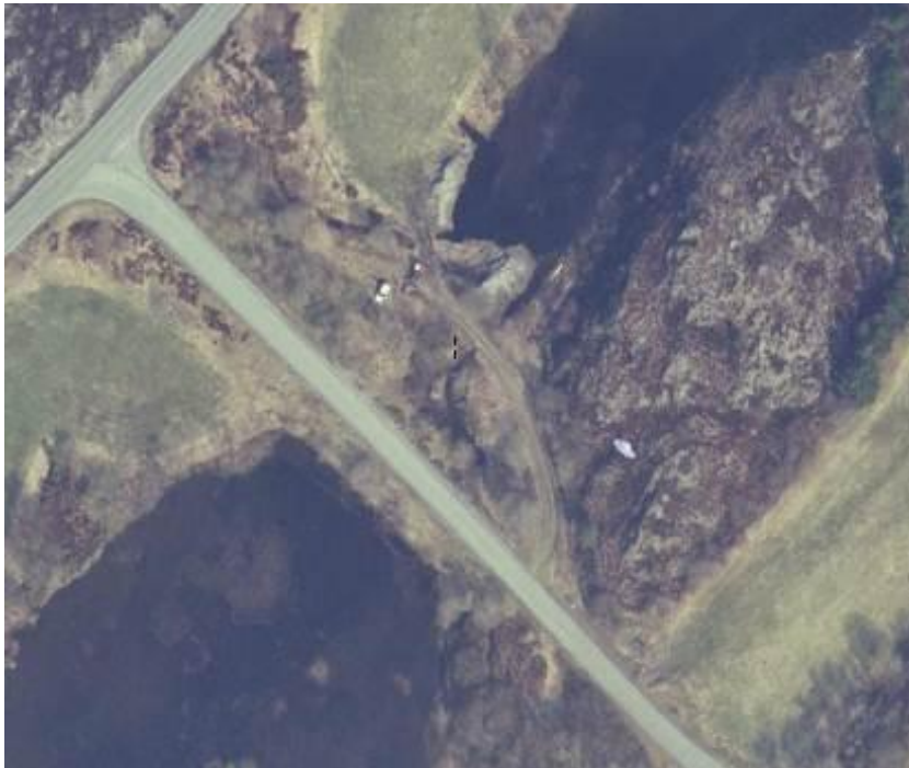
Figur 79. I dag er veifyllinga utvidet og kulverten fjernet, slik at vannet renner tvers gjennom veien og ingen sjørretet kan lenger passere. (Kilde: www.webatlas.no )
