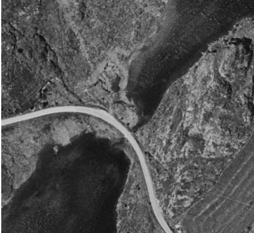
Figur 78. Bekken mellom Litlvatnet og Jevikvatnet gikk tilsynelatende i en kulvert som trolig var passerbar for sjørretet i 1967. (Kilde: www.webatlas.no )
