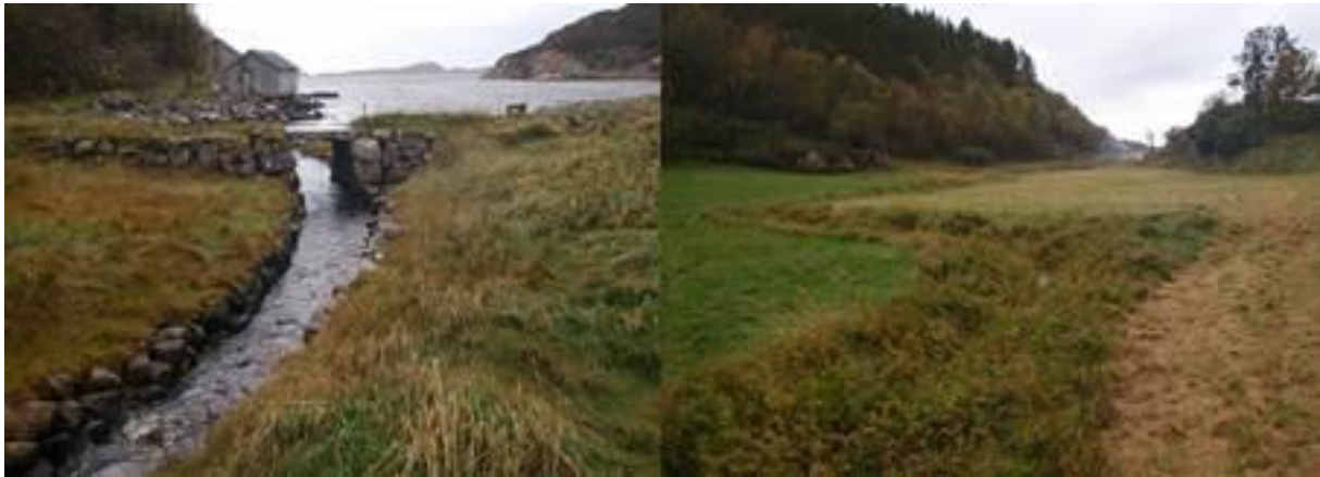
Figur 38. Dalavassbekken før munning (t.v.) er svært utrettet og steinsatt lang kantene, der all opprinnelig kantvegetasjon er fjernet. Inngrepene her er av eldre art, og gjort før 1967.
