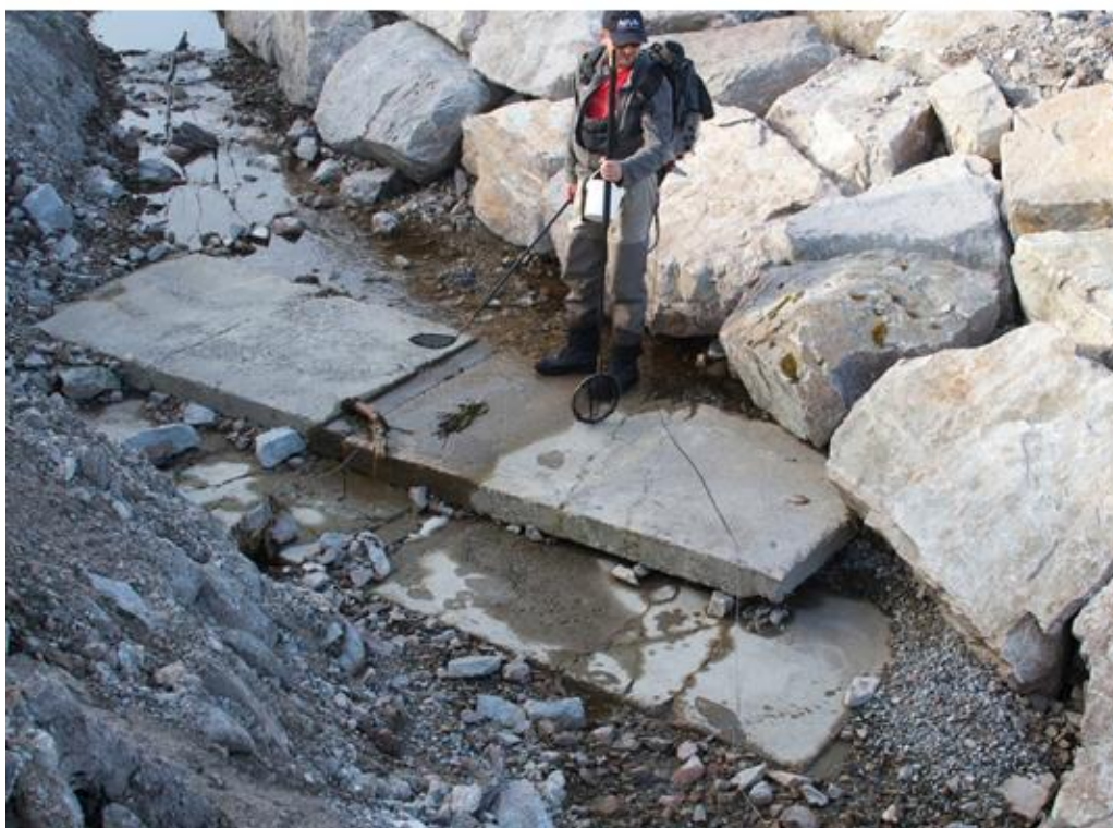
Figur 72. Leirvågbecken, sommeren 2012, etter tiltak. Øverste foto er tatt på vannføring over middels, tilnærmet høy. Nederste foto tatt på lavere vannføring, tilsvarende normal sommervannføring. Betongklosser lagt på bunn skaper lav vanddybde på kun noen få centimeter på normale vannføringer. På lave vannføringer er øvre avsnitt av vassdraget nå adskilt fra nedre avsnitt og sjøen, som en følge av at vannet går i bakken (i anleggsområdet) og tar vei utenom bekkeløpet. Foto: privat
