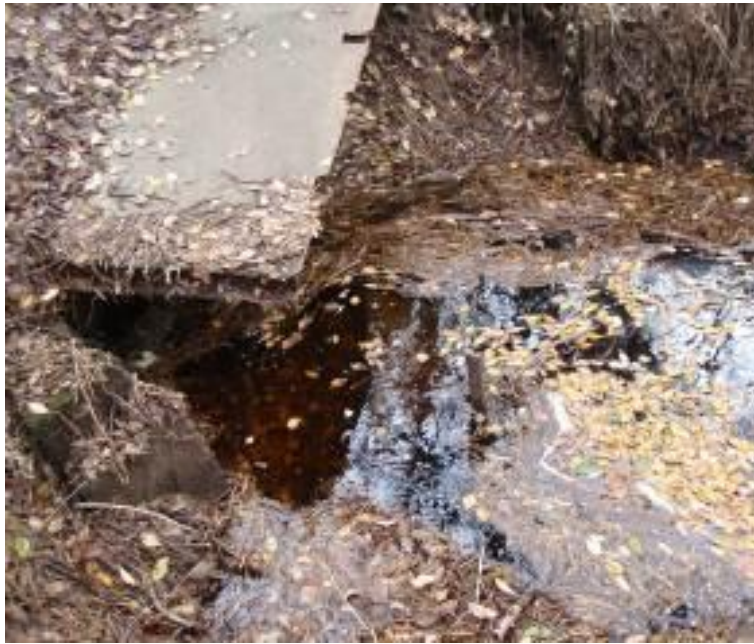
Figur 59. Innløp til kulverten under fotballbanen..
