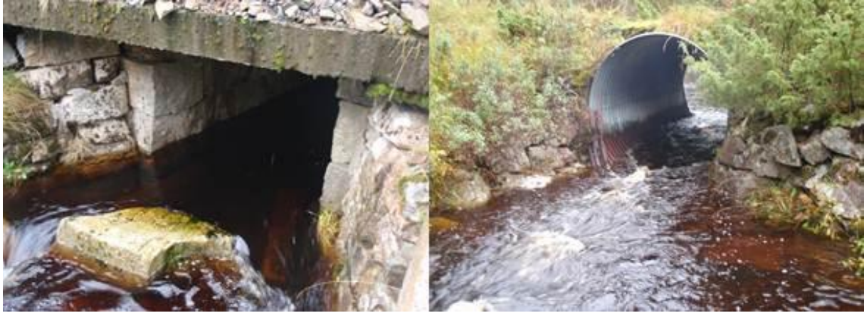
Figur 40. Krysning under Fv 713 (t.v.) og privat grusvei (t.h.) ivaretar vandringer for anadrom laksefisk.
