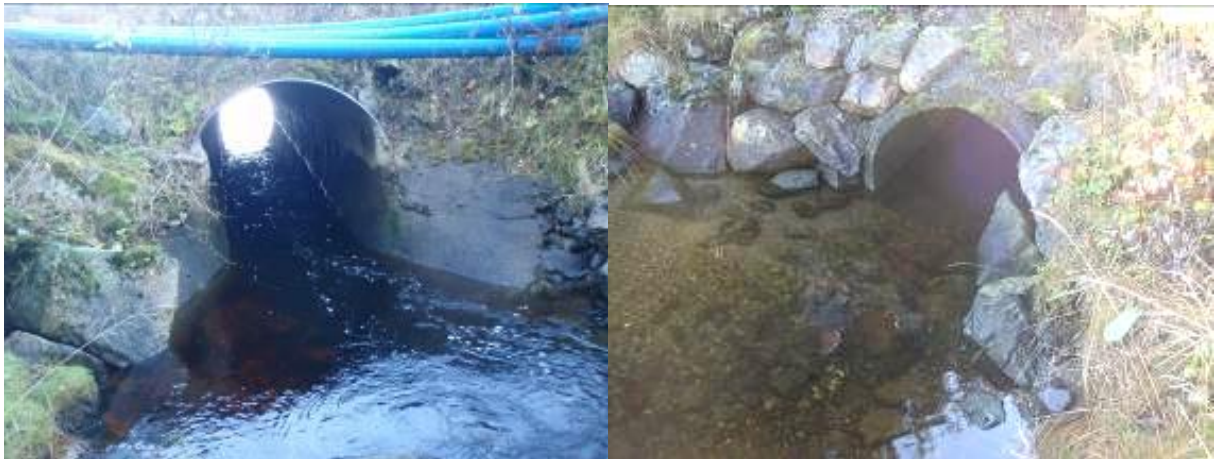
Figur 110. Krysning under Fv 342 i Strandaelva (t.v.) og ved mindre grusvei i Bonbekken (t.h.).
