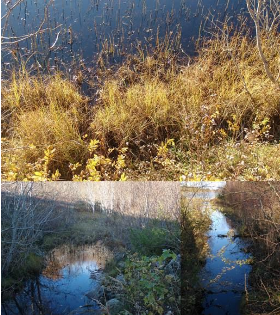
Figur 77. Bekken som forbinder Litlvatnet med Jevikvatnet er synlig på nedsiden av veien, men veifyllingen og veien er lagt tvers over vassdraget, slik at vannet renner i hulrommene gjennom fyllinga. Den økologiske kontinuiteten for sjørret er brutt.
