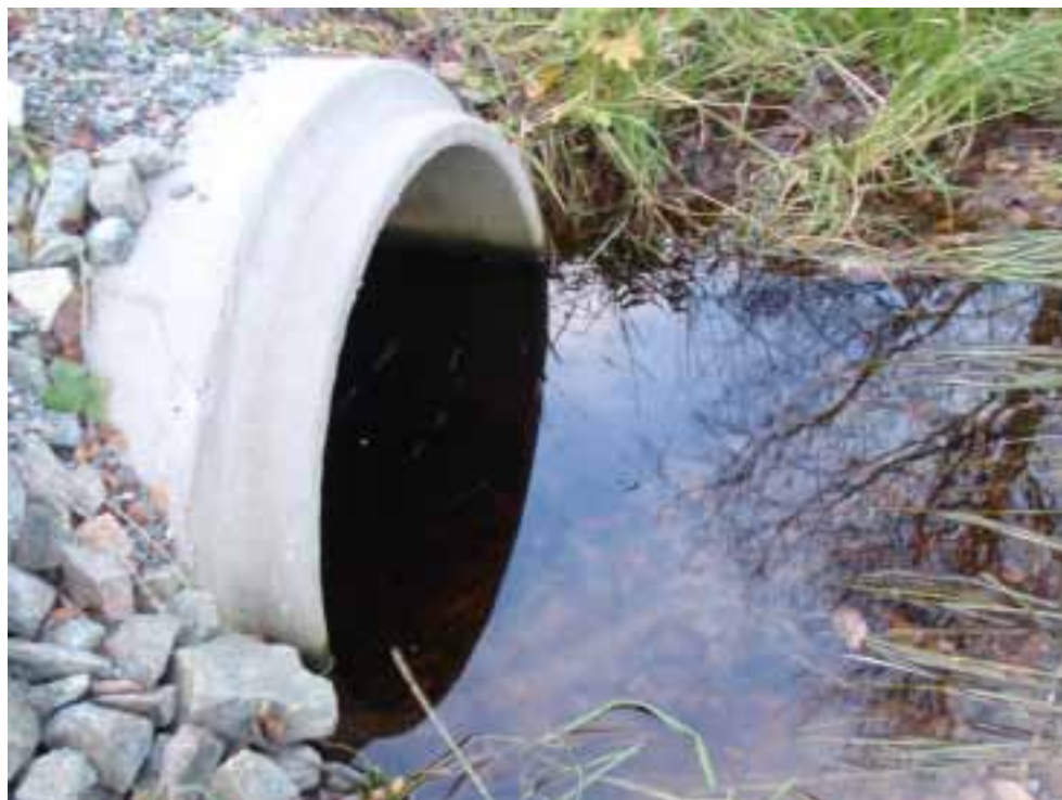
Figur 107. Krysning under grusvei (5) i tilløpsbekken til Hopsjøvatnet.
