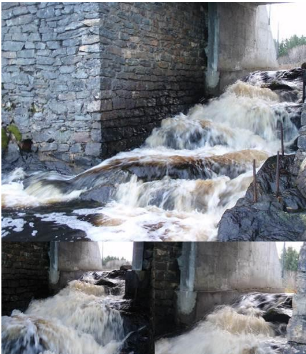
Figur 95. Problematisk passeringspunkt under Fv 382, der opprinnelig vanskelige vandringsforhold har blitt forverret som følge av veikrysningen.
