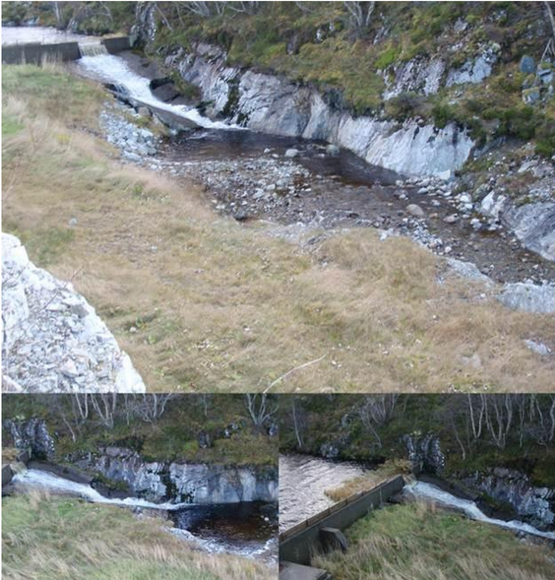
Figur 127. Demningen ved utløpet av Dragevatnet.
