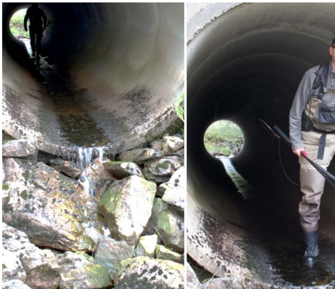
Figur 101. Kulverten under Fv 381 ved befarings på middels vannføring i august 2012. (Foto: privat)
