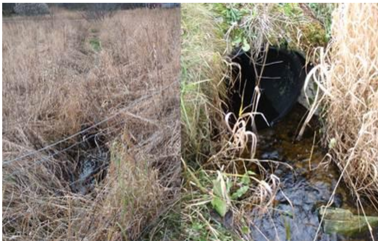
Figur 92. Bekken går i bakken under jordbruksareal og Fv 382.
