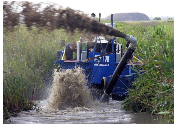
2. Materialet kan sprutes eller pumpes på land eller til en avvanningslekt
