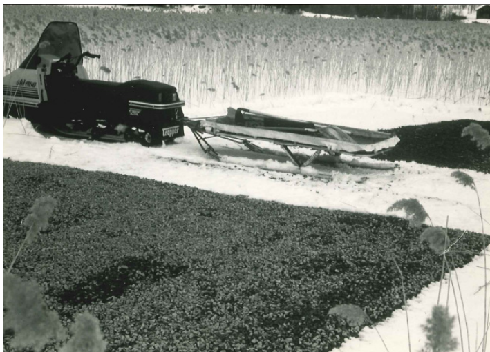
Figur 24. Utlegging av fiberduk i bestand av takrør ( Phragmites australis ) Steinsfjorden 1987. Foto: Dag Berge.
