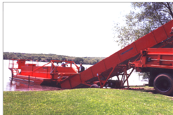
4. Lekteren tømmes over på et nytt transportbånd som lesrer materialet opp i en lastebil.
