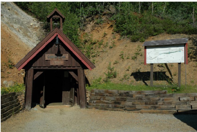
Figur 5. Gruveinngangen til Gammelgruva.
