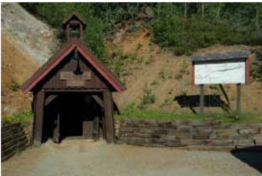
Figur 5. Gruveinngangen til Gammelgruva.
