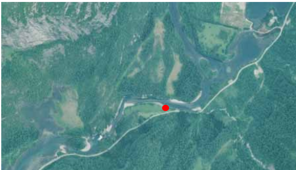
Figur 10. Satellittfoto av Modalselva ved Espeneset. Lokalitet for kalkdoserer er merket med rødt (Norge i bilder).
