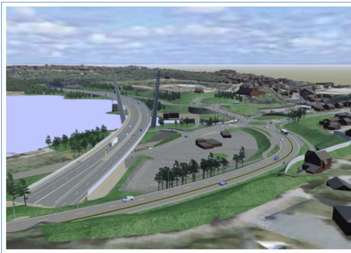
Figur 4. Farrisbrua sett fra vest. Oversiktsbilde over nye E-18s passering av Farriseidet fra vest etter ferdigstillelse (3 D skisse fra www.vegvesen.no ). Utløpet av Martineåstunnelen nederst i venstre hjørne. Gamlevegen til høyre for ny-veien, Farrisvannet til venstre, havet bakerst til høyre.
