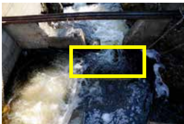
Figur 9. PIT-antennesløyfa i Trappa er lagt på bunnen i trinnet og illustreres her med gul rektangel. Foto: F.Kroglund.
