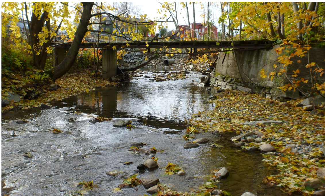
Figur 15. Nedre strekninger av Vikelva (st. 16) høsten 2012.(Foto: Morten Andre Bergan)
