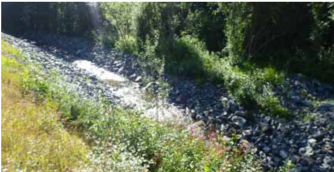
Figur 14. Nylig steinsatt stasjonsområde 15 i nedre del av Amundbekken. (Foto: Morten Andre Bergan)
