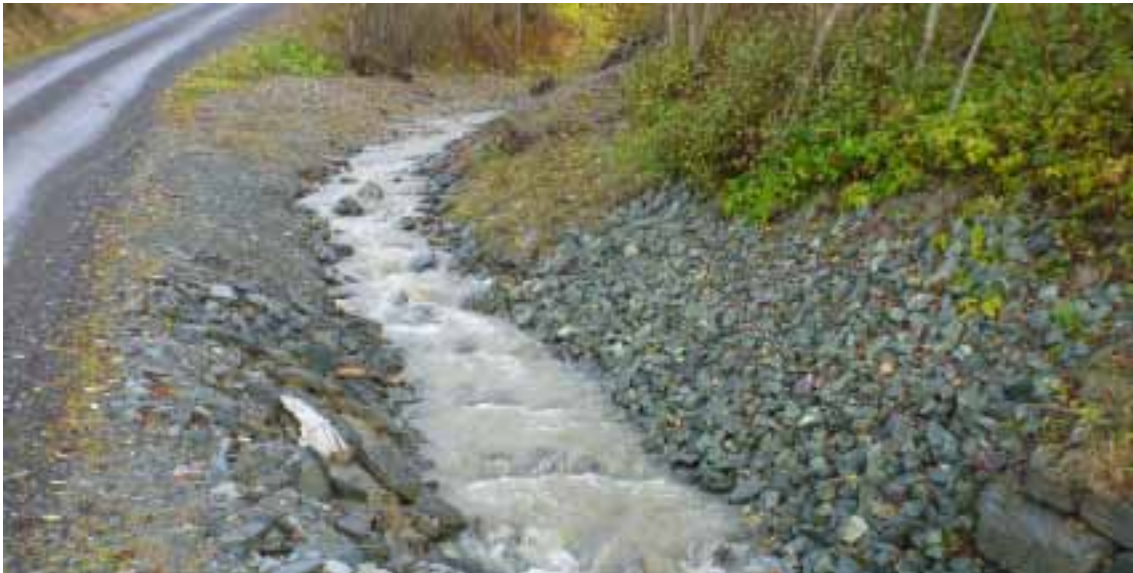
Figur 21. Stasjonsområdet i Ristelva/Høstadbekken ved Brenslan. (Foto: Morten Andre Bergan)
