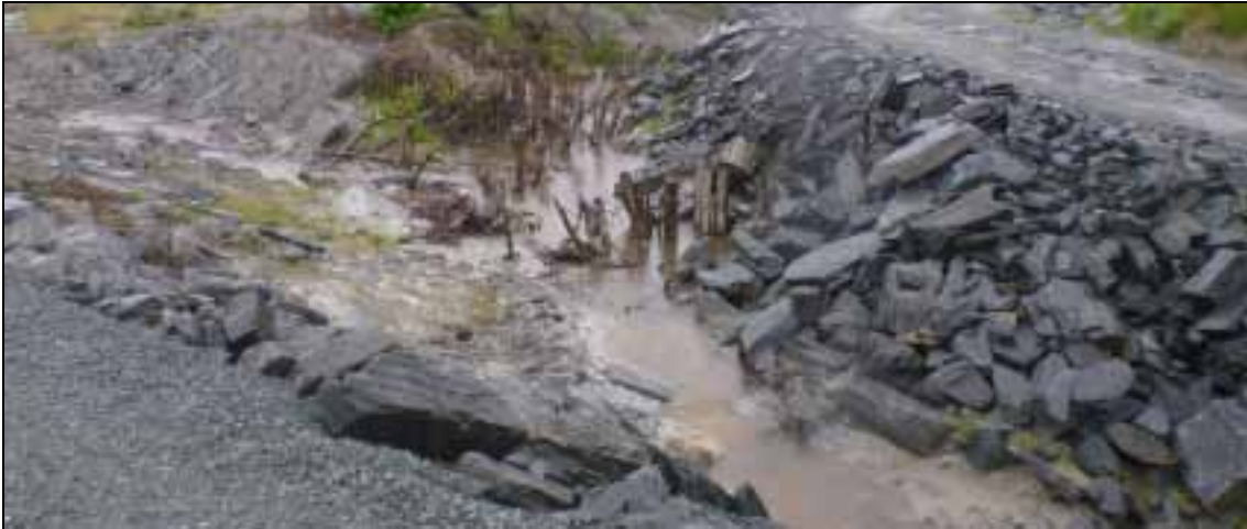
Figur 20. Raspartier, der ustrakt steinsetting er utført og fortsatt pågår, finnes mellom stasjonsområde 19 og 20 i Ristelva. (Foto: Morten Andre Bergan)
