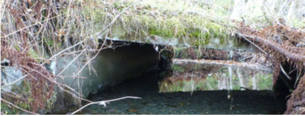
Figur 92. Krysning under traktorvei. (Foto: M. Bergan)
