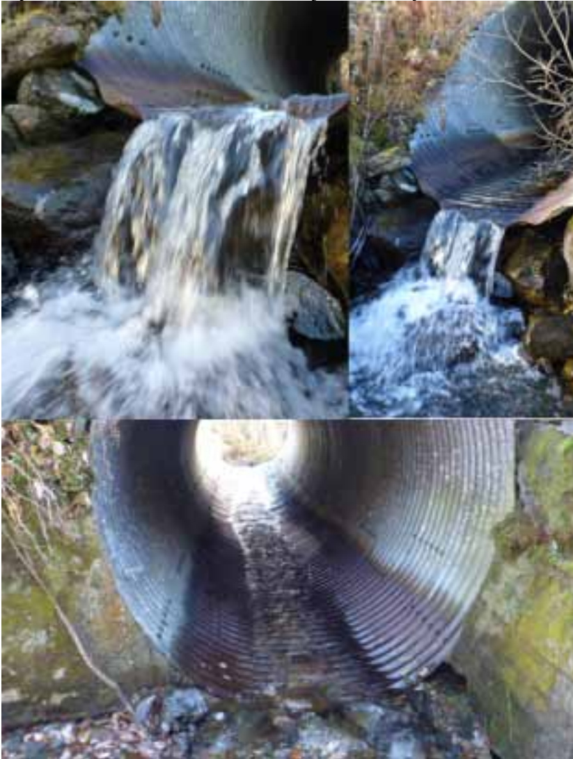
Figur 70. Kulvert under Garbergsveien nedstrøms (over) og oppstrøms kulvert (under). Foto: M. Bergan
