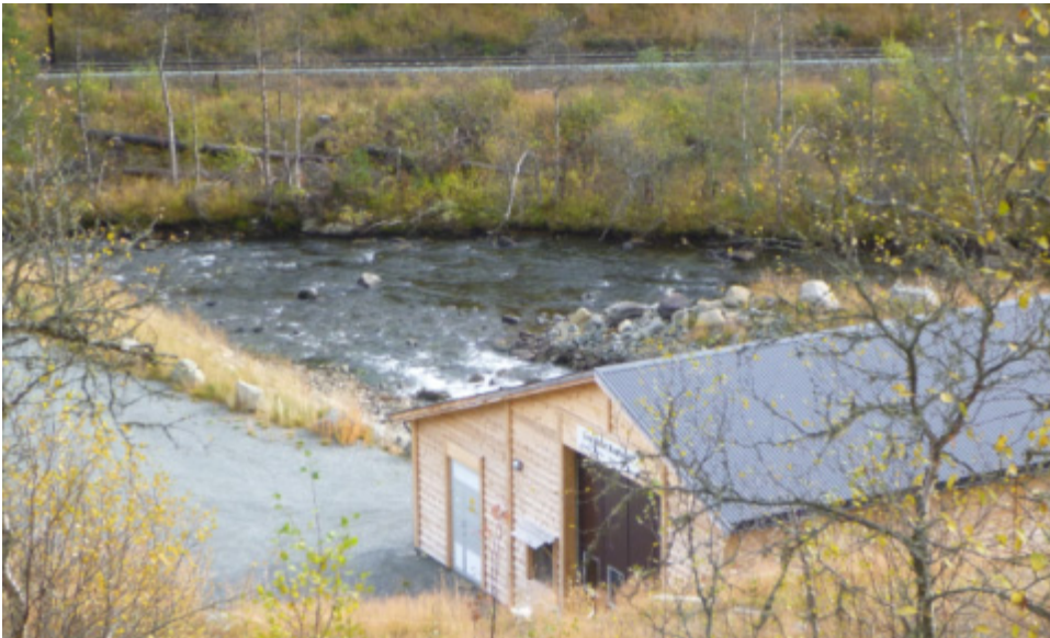
Figur 29. Mesteparten av Gisna nedre (unntatt) minstevannsføringen ledes i rør fra demningen til kraftverk, med utløp i Byna om lag 150 meter oppstrøms Gisnas opprinnelige munning. (Foto: M. Bergan).
