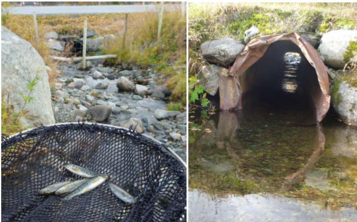
Figur 40. God forekomst av ørret også på strekninger ovenfor Fv 512 i Varghaugbekken (t.v.), og godt nedsenket kulvert under veien (t.h.), som kan passeres av alle størrelser ørret ved normale vannføringer. (Foto: M. Bergan).
