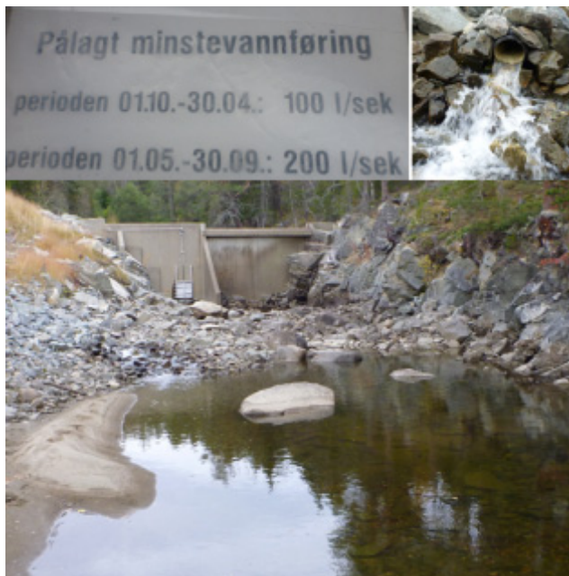
Figur 28. Pålagt minstevannføringsregime i Gisna nedre (øverst, t.v.), og vannslippet som skal sikre minstevannføringen (øverst, t.h.). Bildet viser det som skal være 100 liter i sekundet i en vinterperiode, som også skimtes i bildet under av demningen. (Foto: M. Bergan).
