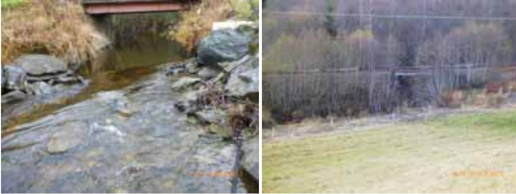
Figur 119. Brukrysnings og bevart elvebunn under kommunal vei (t.v.) og jernbanelinje (t.h.) i Sola (Foto: M. Bergan)
