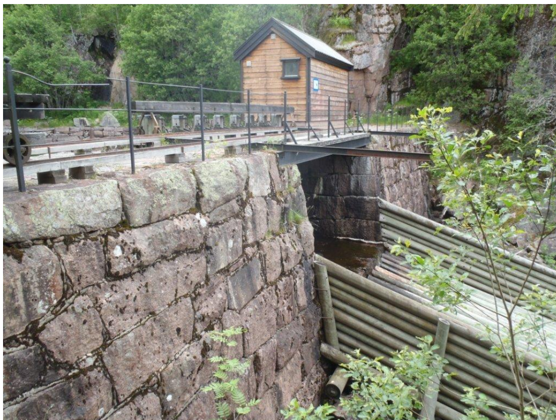
Figur 1. Dammen i utløpet av Bjørnsjøen, en typisk steinmurt dam av tømmerfløtningstypen. Foto VAV.
