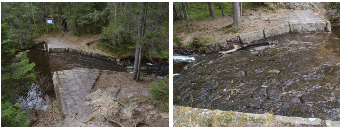
Figur 163. Dammen i utløpet av Aurevann med overløpsrenne. Foto: VAV.
