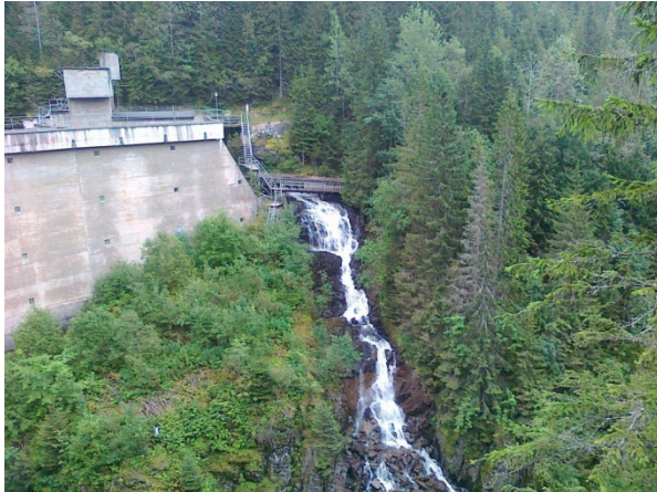
Overløpet ved tømmerrenna. I tillegg er det et flomoverløp på andre siden av dammen.
