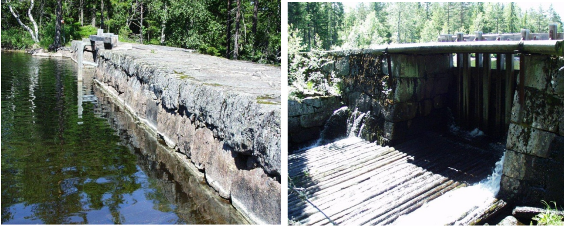
Figur 110. Fyllingen dam og tappeanordning. Foto: VAV.
