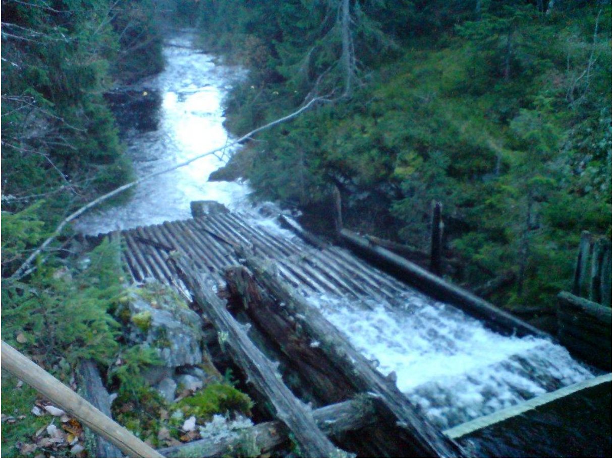
Figur 134. I utløpet av Myrtjern er det en ødelagt tømmerkistedam med lederenne for tømmer «skottbru» som de ofte kalles. Foto: VAV.
