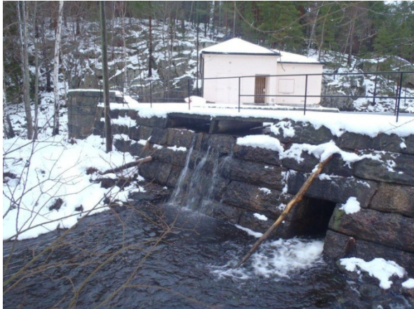
Dammen sett nedenfra med vannslipp fra bunnluke
