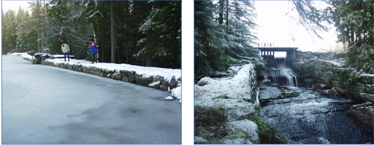
Figur 56. Pershusvannet er demmet opp med dam i utløpet. Foto: VAV.
