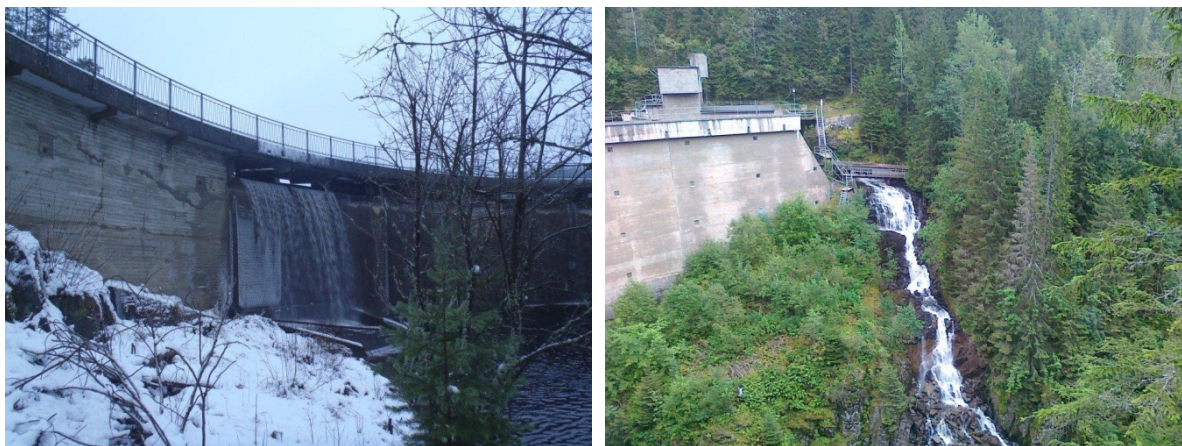
Figur 2. Elvågdammen og Langliadammen er eksempler på dammer som er laget i første rekke for å magasinere drikkevann. Legg merke til at i Langliadammen (til høyre) er det også installert tømmerluke og tømmerrenne for fløtning. Foto: Dag Berge.
