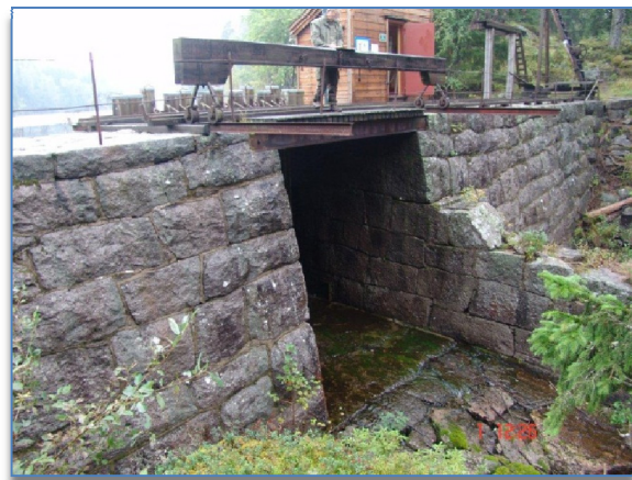
Figur 104. Hakkloa dam og utløpsanordning. Foto: VAV.
