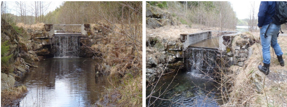
Figur 184. Dammen i utløpet fra Lutvann. Foto: VAV.
