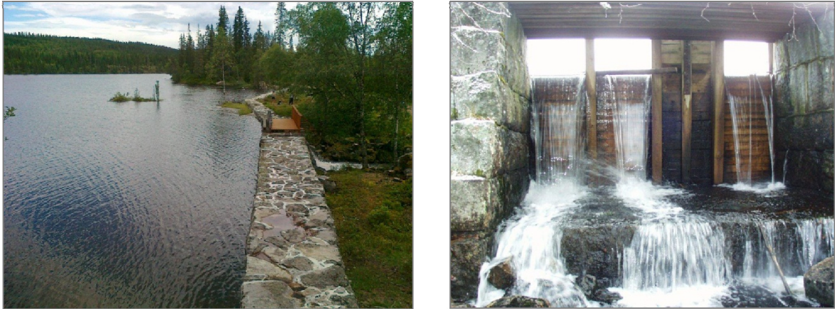
Figur 52. Dammen og utløpsanordningen fra Tverrsjøen. Foto: venstre panel, Dag Berge, høyre panel, VAV.
