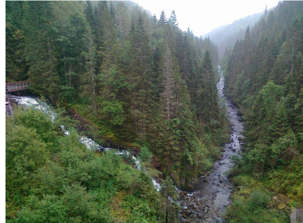
Overløpet munner ut i Langlielva nedenfor dammen. Like nedenfor der overløpet munner ut, men på høyre side av elva, munner avløpet fra bunnventilen i dammen ut, der minstevannføringen ble tappet fra da innsjøen var tappet ned under HRV.
