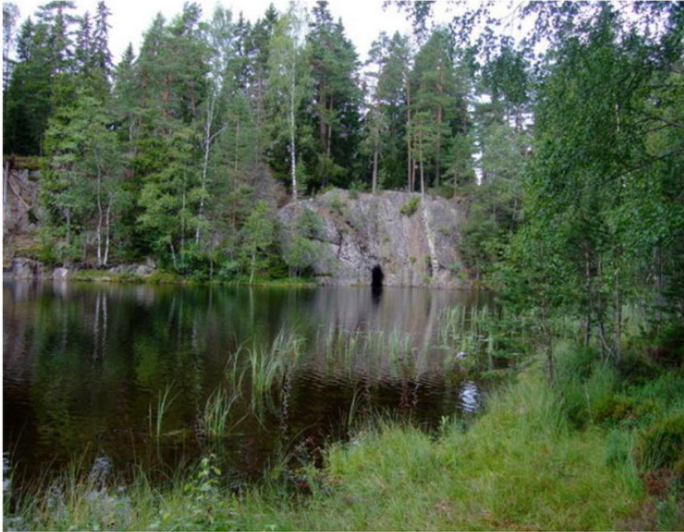
Figur 188. Tunnelen som overfører vann fra Kroktjern og ned i Lutvann. Foto: VAV.
