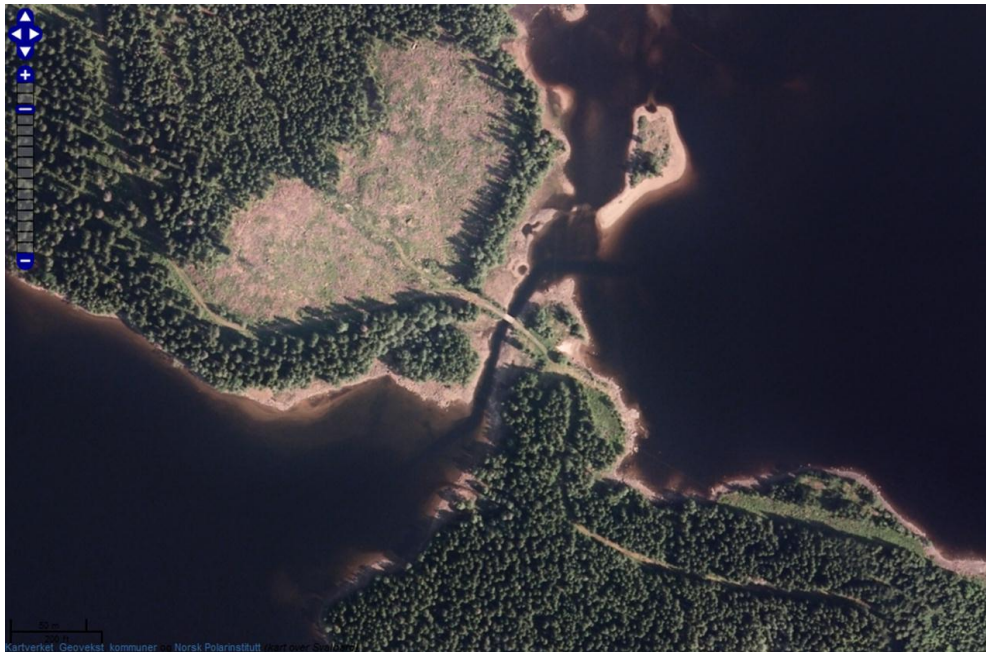
Figur 91. Sundet mellom Store og Lille Sandungen er gravd ut slik at de kommuniserer med felles vannflate også ved LRV. Foto: Kartverket, Norge i Bilder.
