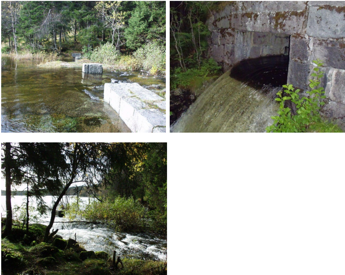
Figur 87. Dam og utløp og overløp fra Daltjuven ved flom. I tørre perioder kan utløpet tørke helt ut. Mesteparten av vannet fra Daltjuven tappes via tunnel til Sandungen. Foto: VAV.
