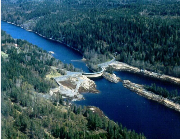
Flyfoto av Elvågadammen
