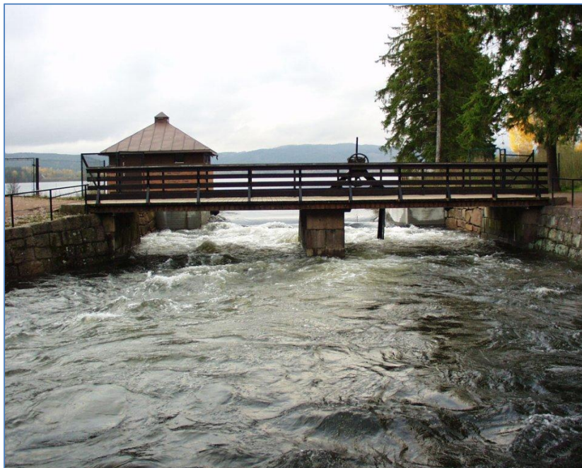
Figur 160. Dammen i utløpet av Maridalsvannet i en periode med stor tilrenning. I slike perioder er det mulig for fisk og passere dammen. Foto: VAV.
