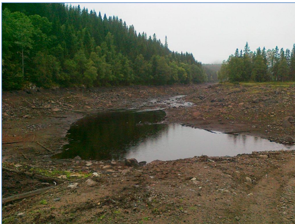
Figur 36. Utløpsbukta i Svarten når vannstanden er tappet ned til LRV dvs. 6 m nedtapping fra HRV som er den normale vannstanden (fra august 2012 da man arbeidet med renovering av dammen). Foto: Dag Berge.
