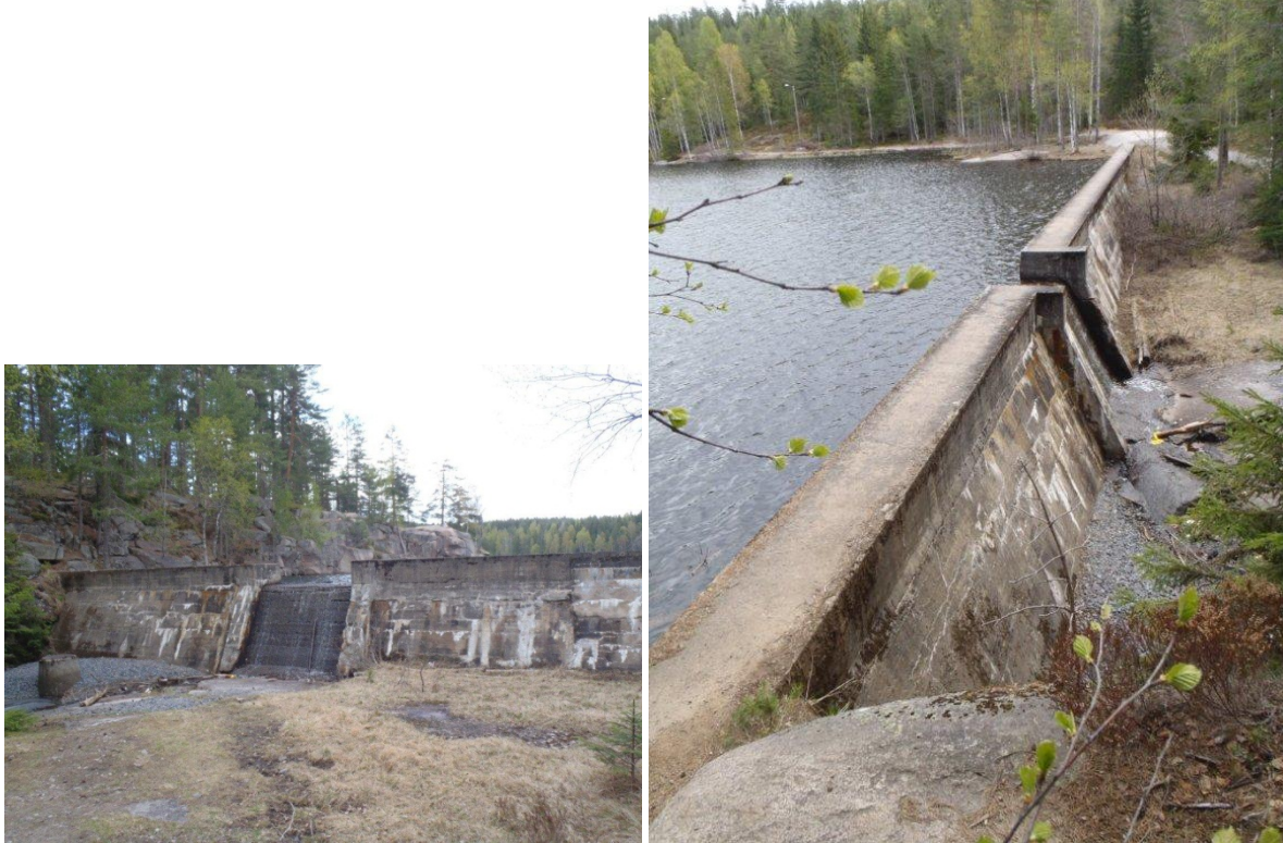
Figur 169. Dam ved Romstjern med flomoverløp. Foto: VAV.
