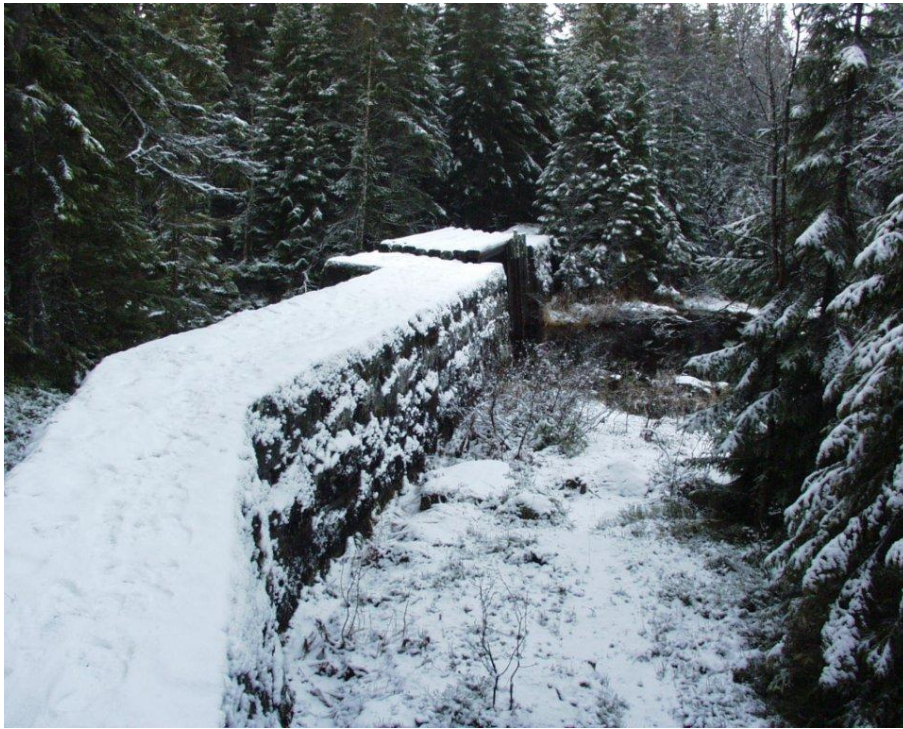
Figur 59. Finntjerdammen. Reguleringsinnretningen er fjernet og innsjøen står på LRV. Foto: VAV.
