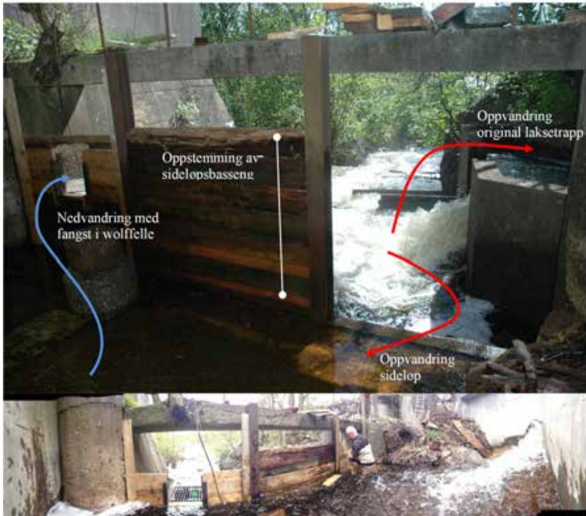
Figur 4. Øverst: Sideløpsbassenget sett fra sideløpet med smoltutvandringshull (forutsetter at hele sideløpsbassenget er oppdemt) og to ulike veier for oppvandrende fisk. Nederst: Oppdemming av sideløpsbassenget med Wolffelle, sideløpet i høyre bildekant (Foto: T. Haraldstad).
