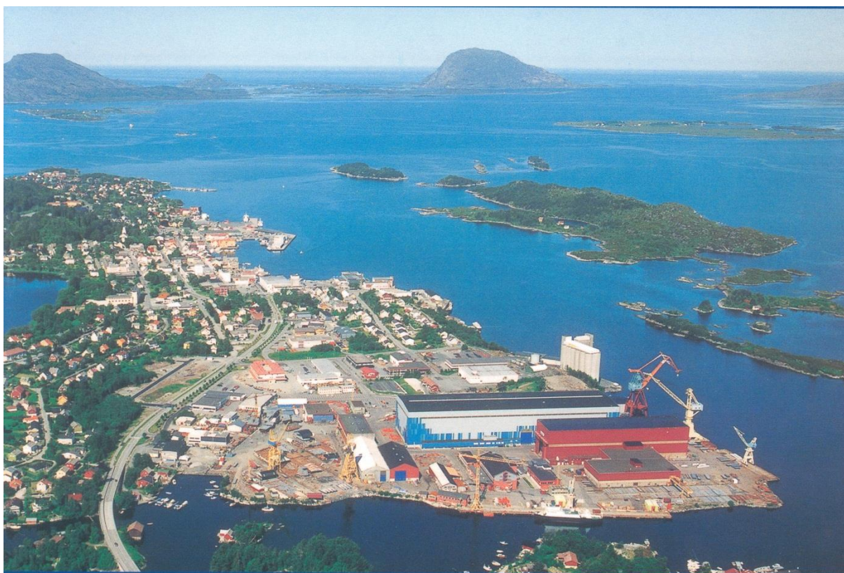
Figur 1. Westcon Yard Florø. Oversiktsbilde som viser bedriftens beliggenhet på Hestneset nordøst på Florølandet. Bildet er orientert slik at nord-nordvest er oppover i bildet. Den nedre delen av bildet viser Gaddevågen som er det trange sjøområdet mellom Florølandet og Brandsøy. Innerst i Gaddevågen ses en liten småbåthavn. Et gammelt, mindre og nedlagt deponi var lokalisert nordvest av denne havna.
