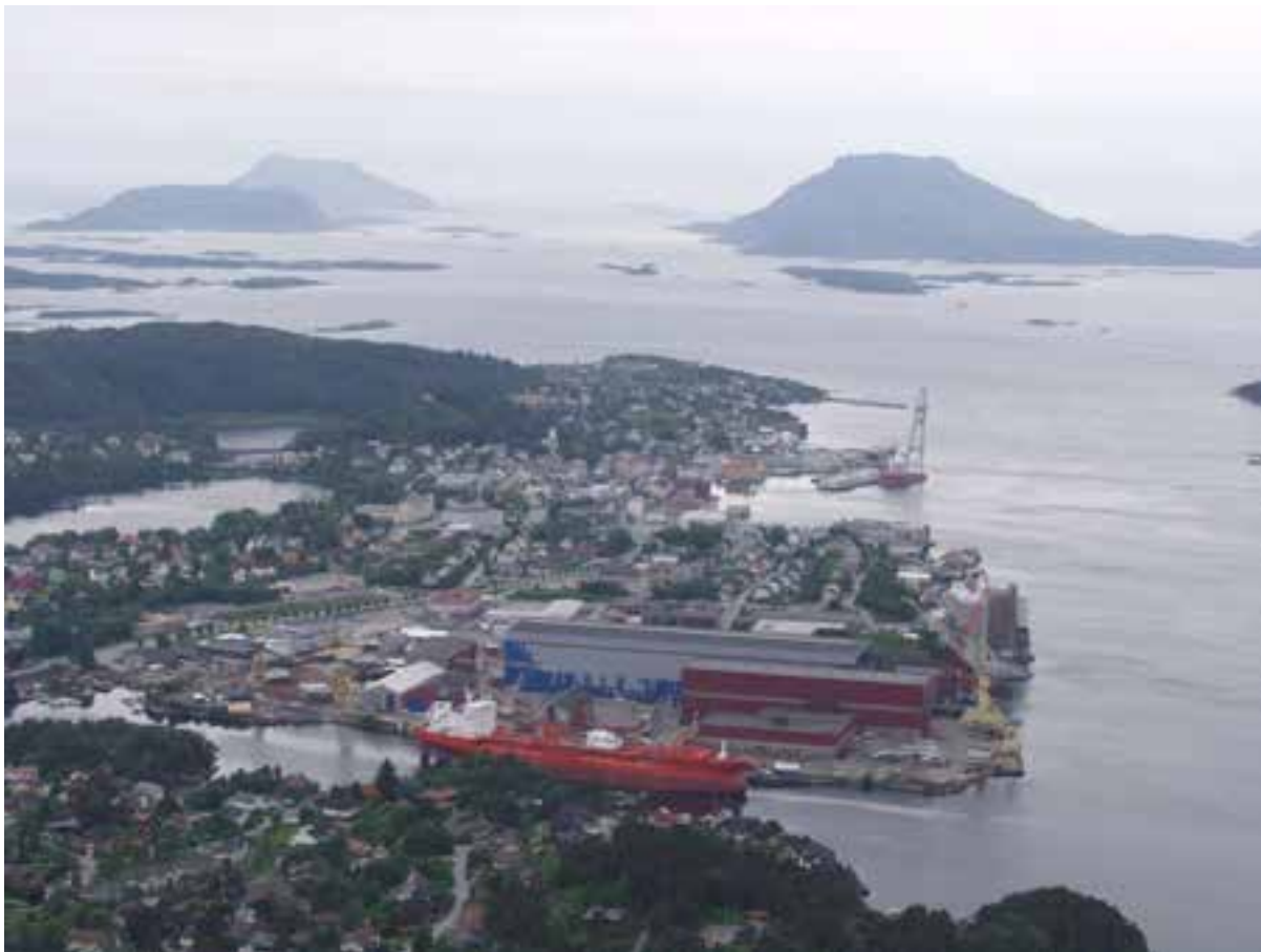
Figur 2. Westcon Yard Florø. Bilde av verftsområdet med et skip liggende ved utrustningskaaien.
