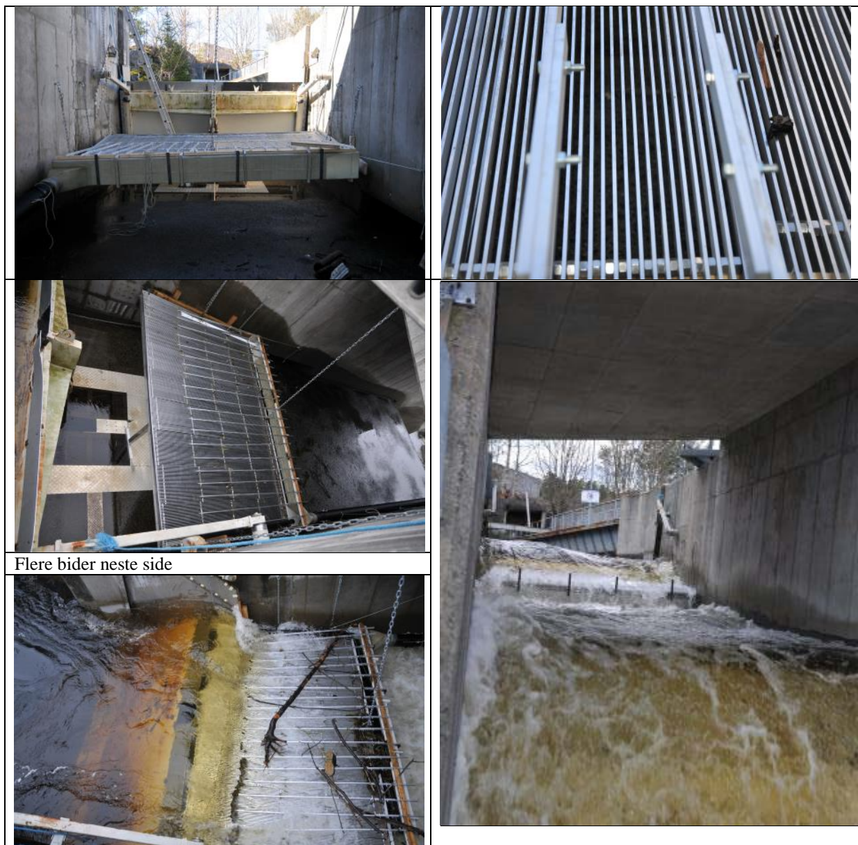
Figur 16. Øverst venstre. Isluken er lukket. Wolf-fella henger fra kjettinger i isløpet. Oppsamlingsrenne er montert nederst på fella. Herfra ledes fisken til fangstkar. Øverst høyre. Selve Wolf-fella med spilene. Nederst venstre. Wolf-fella slik den står når isluken er lukket. Nederst midten. Slik fella her står ville det snarest bli behov for å rense vekk trepinner mm. Når disse begynte å samle seg ble det raskt flere. Tilslutt kunne fella gå nær tett. Nederst høyre. Isløpet med felle sett nedenfra.
