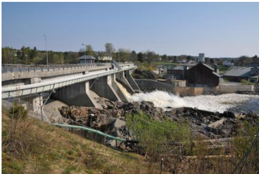
Figur 4. Vannslipp ut segmentluke 3. Foto tatt 18. mai 2013.
