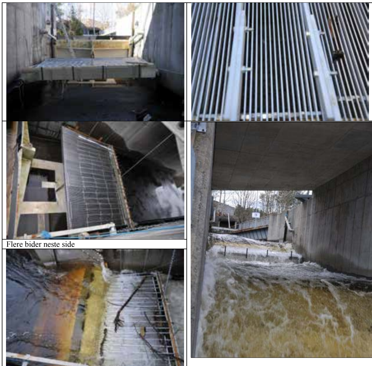
Figur 16. Øverst venstre. Isluken er lukket. Wolf-fella henger fra kjettinger i isløpet. Oppsamlingsrenne er montert nederst på fella. Herifra ledes fisken til fangstkar. Øverst høyre. Selve Wolf-fella med spilene. Nederst venstre. Wolf-fella slik den står når isluken er lukket. Nederst midten. Slik fella her står ville det snarest bli behov for å rense vekk trepinner mm. Når disse begynte å samle seg ble det raskt flere. Tilslutt kunne fella gå nær tett. Nederst høyre. Isløpet med felle sett nedenfra.
