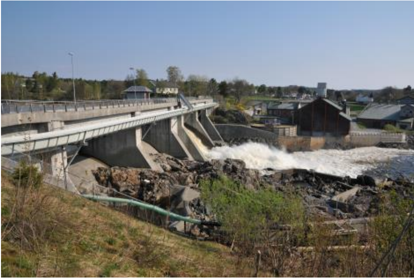
Figur 4. Vannslipp ut segmentluke 3. Foto tatt 18. mai 2013.
