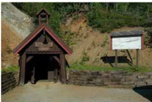
Figur 4. Gruveinngangen til Gammelgruva.
